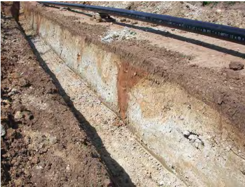
ABB. 6 Huisheim. Oben: Ausgesteckte Pseudobefunde. Unten: Verwitterungstasche im Rohrgraben (Fotos: B. Kopecky-Hermanns).
