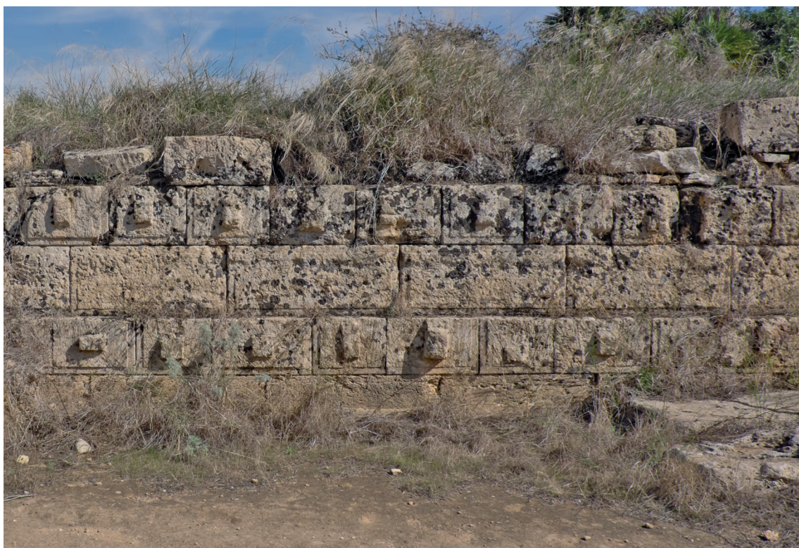
Abb. 1: Selinunt. Strassenbegleitende Stützmauer westlich hinter Tempel D.
