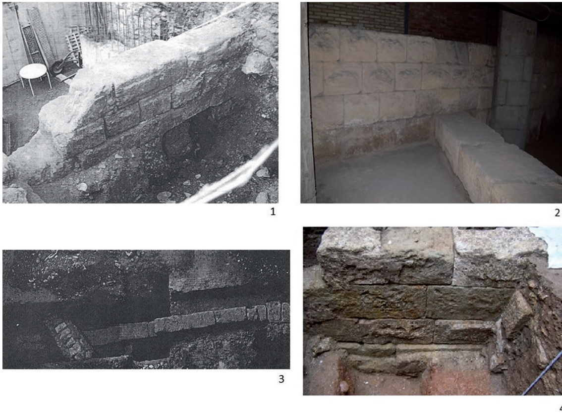
Fig. 6: Restos del muro de contención en el trazado republicano.
