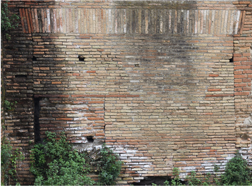
Abb. 7 vermauerter Eingang mit Fensteröffnung an der Ostseite von Raum 5, Ostia, Terme dei Sette Sapienti (III X, 2)
