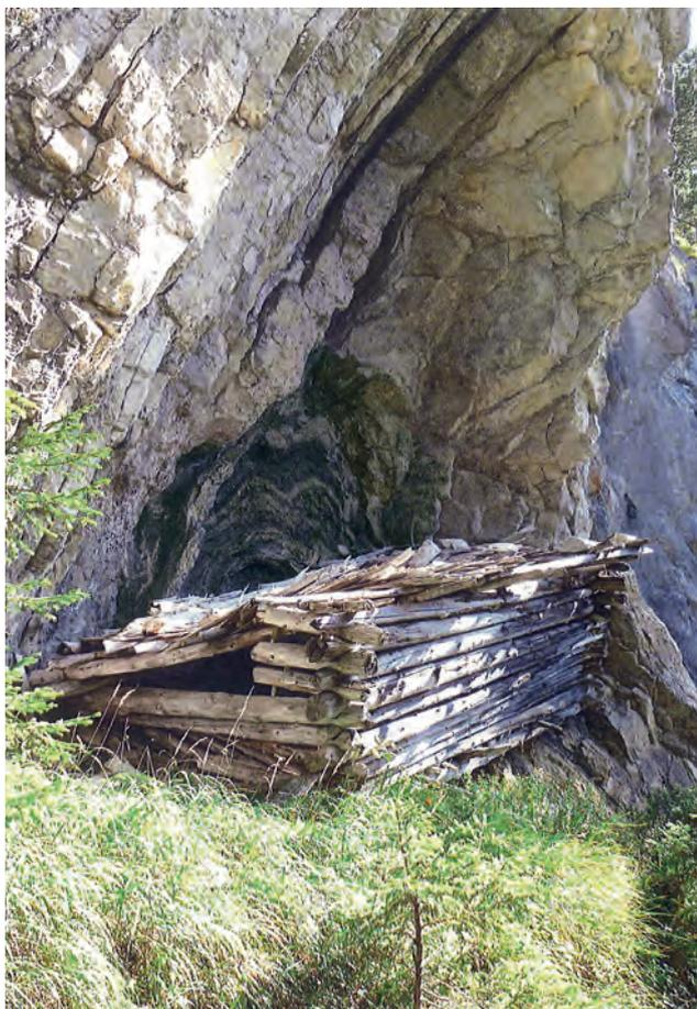
**Abb. 184** Innertkirchen BE, Gadmental. Gaden zur Einlagerung von Wildheu. Die Abdeckung war ursprünglich vermutlich als Pulldach an die Felswand gelehnt.
