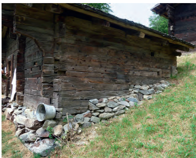
Abb. 70 Der Übergang vom Mauersockel zum Holzaufbau verläuft bei den Alpgebäuden von Alp Richinen (Bellwald VS) wegen der Hanglage abgestuft. Aufnahme der versetzten Gebäude am neuen Standort im Freilichtmuseum Ballenberg.
