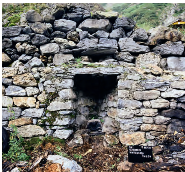
Abb. 74 Innertkirchen BE, Wendenläger 1. Die halbrunde Ausbuchtung beim Gebäuderest Kat. 234 zeigt die Lage der Feuerstelle an.
