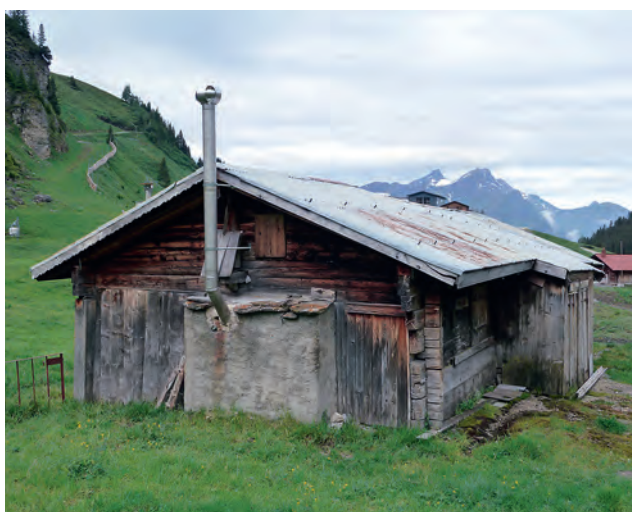
Abb. 68 Hasliberg BE, Mägisalp Unterstafel. Der gemauerte Bereich mit dem Kamin verrät die Lage der Feuerstelle.
