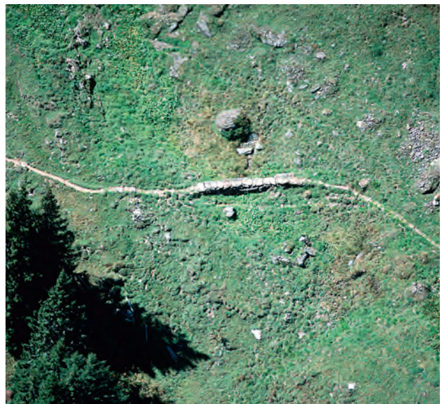
Abb. 109 Innertkirchen BE, Zilflucht, Brücke Kat. 322 . Westlich der Flur Zilflucht wurde zur Querung einer sumpfigen Mulde eine kleine Brücke gebaut.
