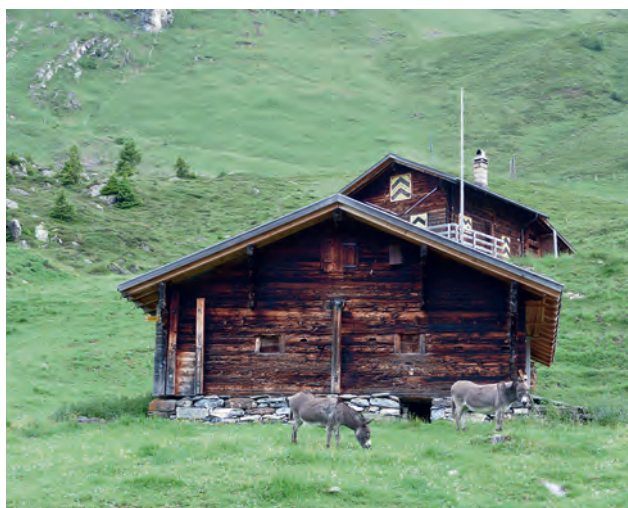
Abb. 66 Hasliberg BE, Mägisalp Unterstafel. Alphütte mit trocken gemauertem Sockel und Holzaufbau.
