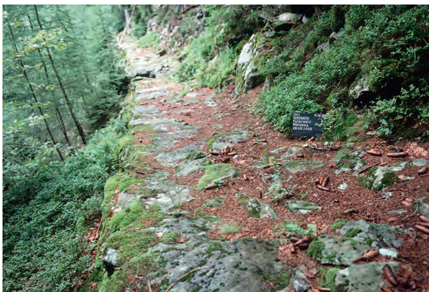
Abb. 107 Innertkirchen BE, Furenwald, Wegabschnitt Kat. 325. Befestigter und gepflasterter Alpweg im Gadmental.
