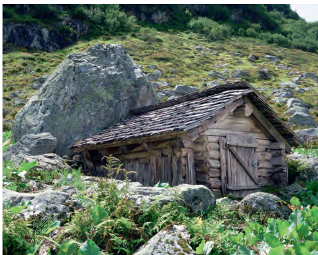
Abb. 81 Innertkirchen BE, Zum See. Neckisches Schweineställchen im Schutz eines Felsblocks. Der Blockbau aus Rundhölzern ist mit Holzschindeln gedeckt.
