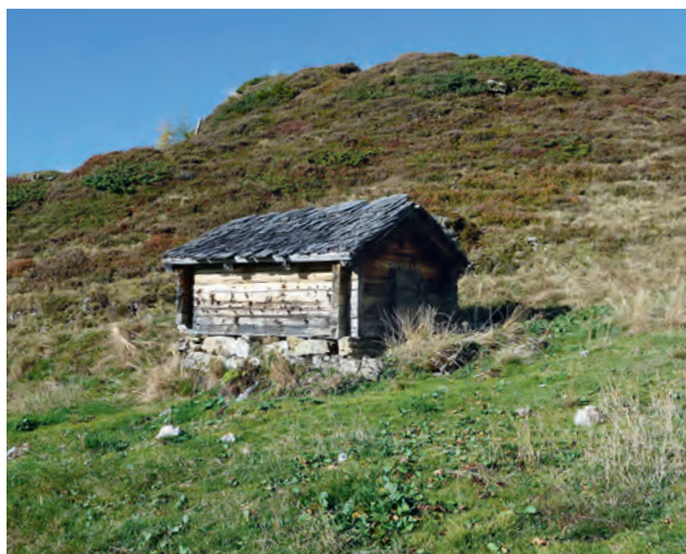
Abb. 84 Innertkirchen BE, Scharmad. Der Blockbau aus Kanthölzern steht auf einem groben Trockenmauersockel und ist mit Holzschindeln gedeckt.
