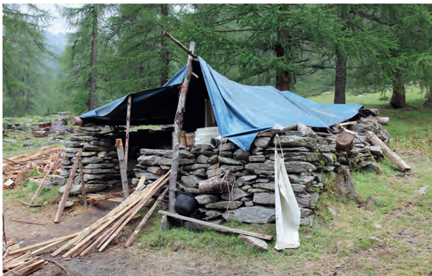
Abb. 72 Eine Sennerei, ein sogenannter Calécc, aus den Valli del Bitto (I) mit mobiler Dachkonstruktion.
