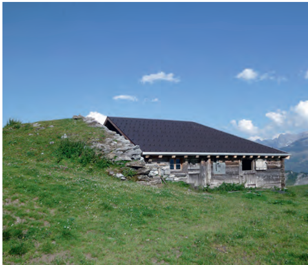
Abb. 54 Hasliberg BE, Schlafenbielen. Das an eine Geländerippe angebaute Alpgebäude wird zusätzlich durch einen Lawenkeil geschützt.
