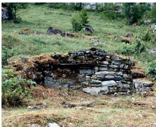
Abb. 69 Innertkirchen BE, Murläger. Die stark in den Hang eingetieft Rückseite des ehemaligen Gebäudes Kat. 93 ist noch bis 1,8 m hoch erhalten. Nach zwei Drittel der erhaltenen Höhe befinden sich zwei in die Mauer eingebaute vorspringende Steinplatten.
