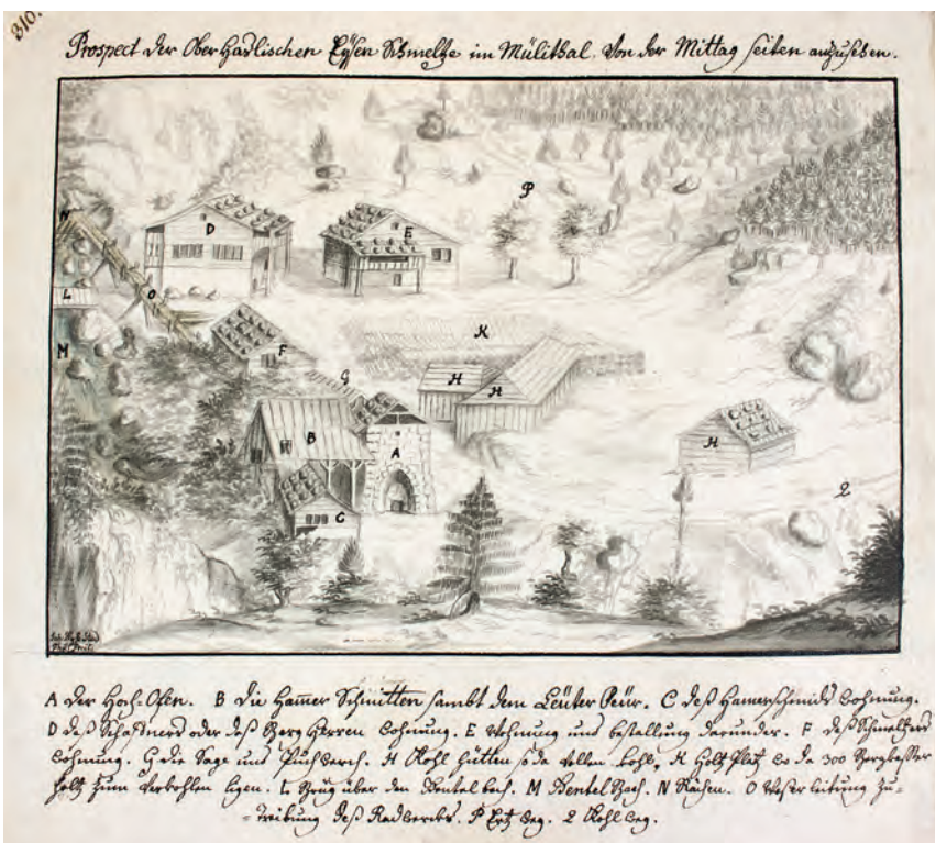
Abb. 30 Das Bergwerk im Mühletal um 1760: «A Der Hochofen; B Die Hammer Schmitten sambt dem Leüter Feür; C Des Hammer Schmidts wohnung; D Des Schaffners oder dess Berg Herren wohnung; E Wohnung und bestallung darunder; F Dess Schmelzers Wohnung; G Die Sage und Puchwerk; H Kohl hütten so da vollen kohl; K Holz Platz wo da 300 Bergklaffer Holz zum verkohlen liegen; L Brüg über den Gentalbach; M Gental Bach; N Rächen; O Wasserleitung zu treibung dess Radwerks; P Ertz weg; Q Kohlweg.» Lavierte Tuschzeichnung von Johannes Wyss, 1760.
