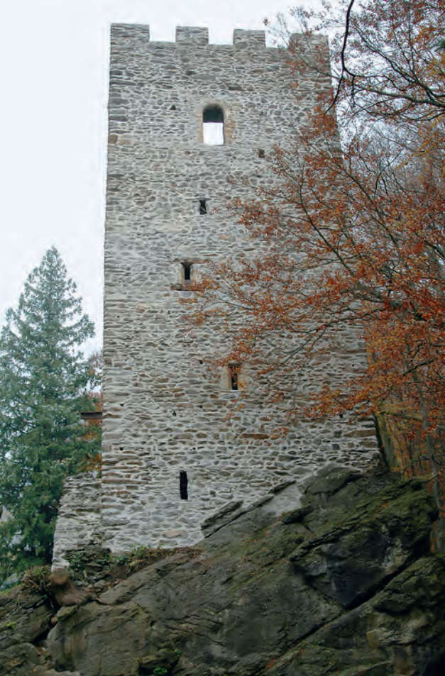
Abb. 27 Der Restiturm in Meiringen nach der Sanierung im Jahr 2004. Blick nach Nordwesten.
