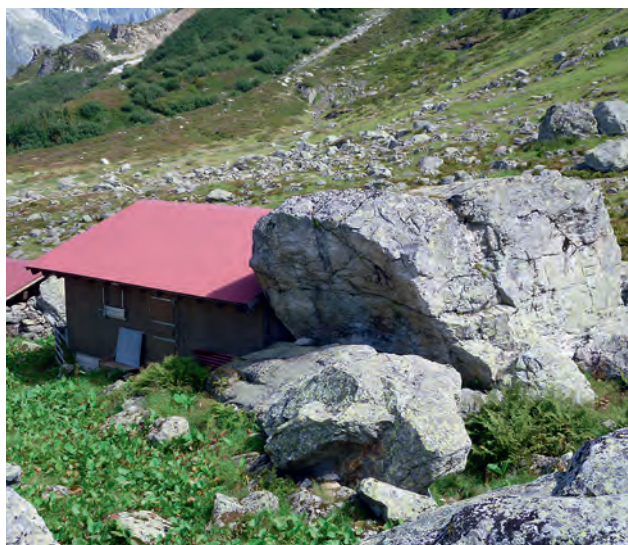
Abb. 51 Innertkirchen BE, Zum See. Die heutigen als Ferienhäuser genutzten Gebäude stehen im Schutz mächtiger Felsblöcke.
