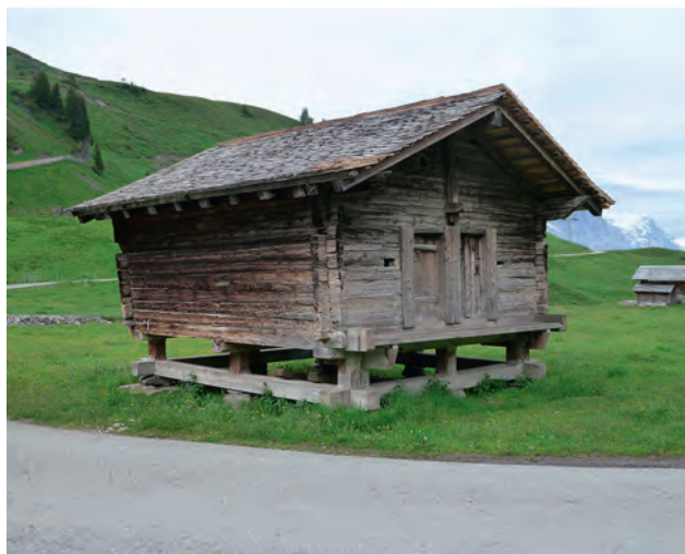
Abb. 170 Hasliberg BE, Mägisalp. Charakteristische abgehobene Konstruktion eines Käsespeichers. Doppelspeicher auf dem Unterstafel.
