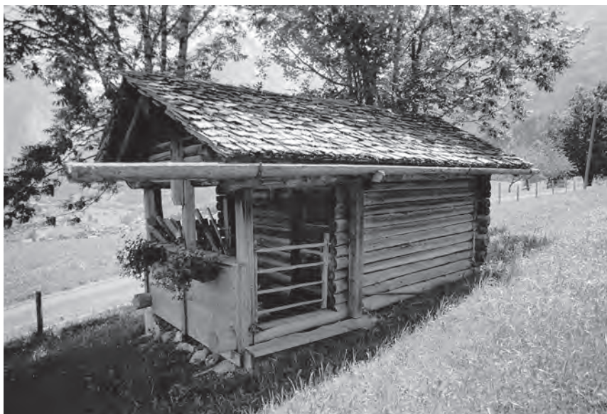
Abb. 165 Grindelwald BE, Zu Aspen. Dendrodatierte Melkhütte von 1800. Kompakter Blockbau aus feinen Rundhölzern mit Käseraum und Melkstand. Schindelgedecktes Satteldach mit Vorgiebel. Der Sockel aus Kalksteinblöcken wurde teilweise ersetzt.
