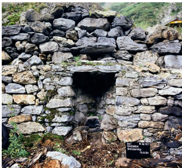
Abb. 74 Innertkirchen BE, Wendenläger 1. Die halbrunde Ausbuchtung beim Gebäuderest Kat. 234 zeigt die Lage der Feuerstelle an.
