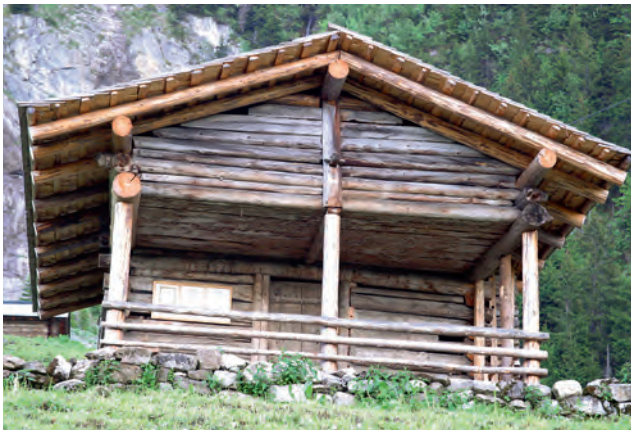
Abb. 167 Iseltwald BE, Bättenalp. Renovierte Melkhütte aus Rundhölzern und mit Stützmauer für den Melkstand.
