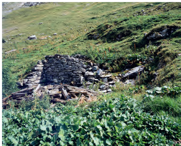
Abb. 64 Innertkirchen BE, Stäfelti 1, Gebäudegrundriss Kat. 111. An der Südseite des Gentals lassen sich blockartige Bausteine aus dem Kalkstein hauen.
