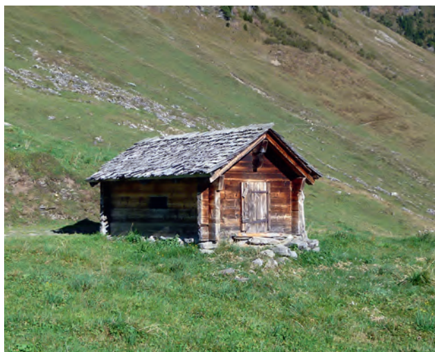
Abb. 82 Hasliberg BE, Baumgarten. Der Trockenmauersockel des mit Holzschindeln gedeckten Blockbaus aus Kanthölzern wurde zu einem kleinen Vorplatz erweitert.
