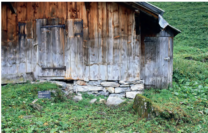
Abb. 80 Innertkirchen BE, Worbi, Gebäude Kat. 150. Heute als Jagdhütte genutzte ehemalige Sennerei mit Stall, zu dessen Eingang eine kleine Rampe führt. Seitlich ist ein Plumpsklo angebaut. Im Vordergrund ist die moosüberwachsene, hochkant gestellte Steinplatte des Mistplatzes erkennbar.
