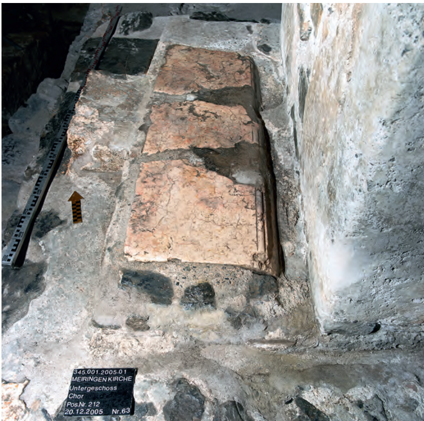
Abb. 23 Meiringen, Kirche, Restaurierung 2005. Detail der vor dem Hauptaltar als Stufe eingebauten Marmorplatte. Blick nach Nordosten.
