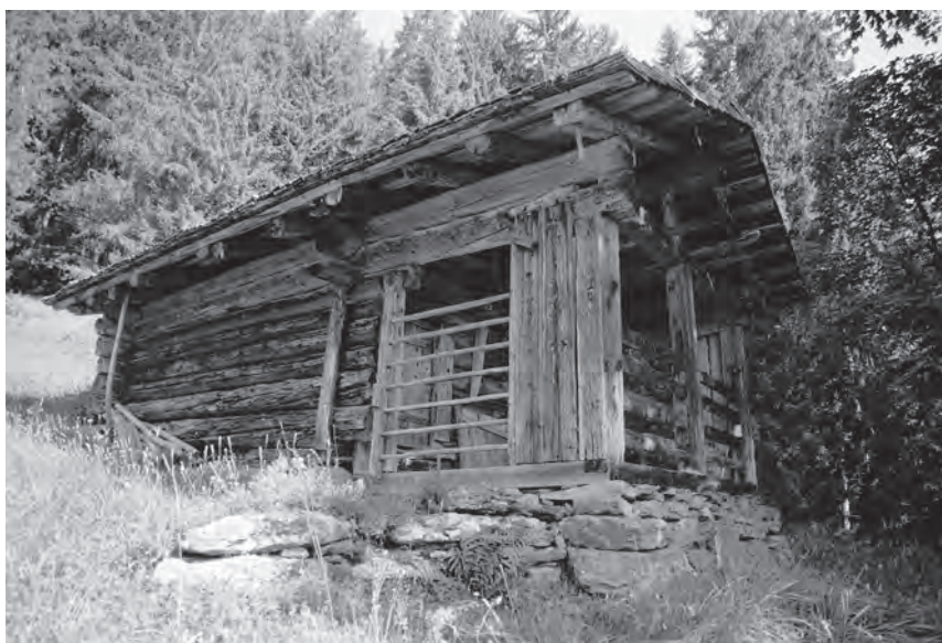
Abb. 166 Grindelwald BE, Nachtigadeweid. Dendrodatierte Melkhütte von 1722. Kompakter Rundholzblockbau mit Käseraum und Melkstand mit Türgatter. Schindelgedecktes Satteldach mit offenem Vorgiebel. Ein Sockel aus Kalksteinblöcken nivelliert den Geländesprung aus.
