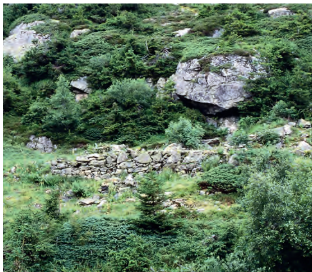
Abb. 78 Innertkirchen BE, Mettlenberg, Gebäudegrundriss Kat. 225. Die mächtige Stützmauer bildet eine Kombination aus Vorplatz und Wegbefestigung.
