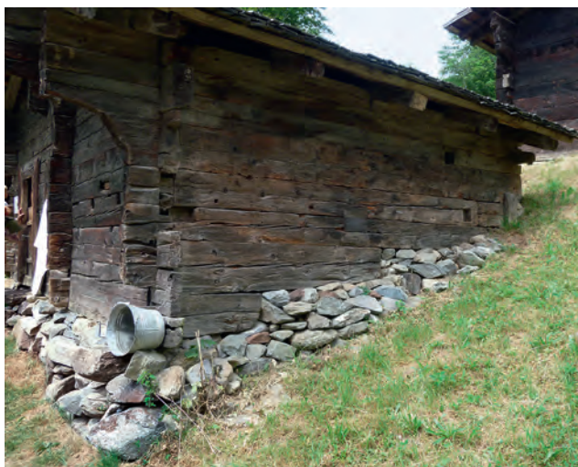
Abb. 70 Der Übergang vom Mauersockel zum Holzaufbau verläuft bei den Alpgebäuden von Alp Richinen (Bellwald VS) wegen der Hanglage abgestuft. Aufnahme der versetzten Gebäude am neuen Standort im Freilichtmuseum Ballenberg.
