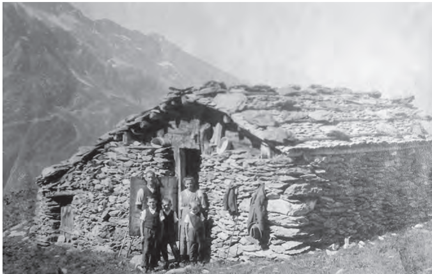
Abb. 67 Innertkirchen BE, Radlef. Die Steinmauern der Alphütte reichen bis unter das Dach. Das Giebeldreieck besteht aus Holz.
