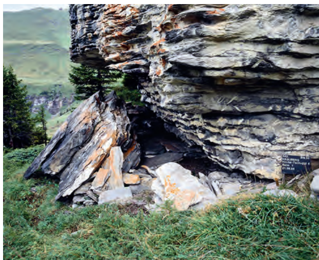
Abb. 93 Hasliberg BE, Hinder Tschuggi 6, Konstruktion unter Fels Kat. 31. An einen grossen Felsblock gebaute Konstruktionen unter Fels. Die Rückseite ist als Trockenmauer ausgeführt, die seitliche Abgrenzung wird durch einen abgewitterten Felsblock gebildet.
