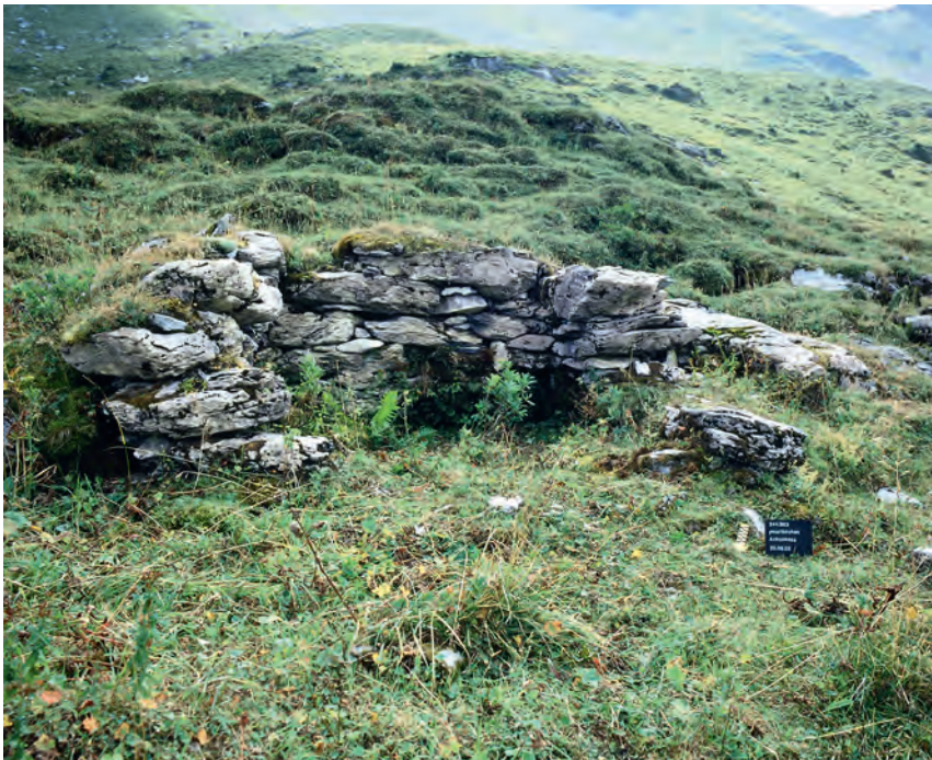
Abb. 136 Innertkirchen BE, Achtelsass. Der kleine, an eine Felsrippe angebaute Gebäudegrundriss Kat. 128 liegt östlich der heutigen Alpsiedlung. Blick nach Norden.
