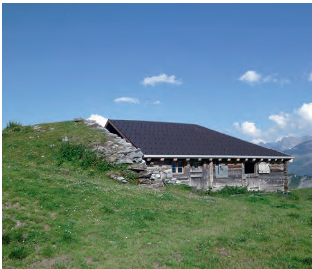
Abb. 54 Hasliberg BE, Schlafenbielen. Das an eine Geländerippe angebaute Alpgebäude wird zusätzlich durch einen Lawinengebiet geschützt.
