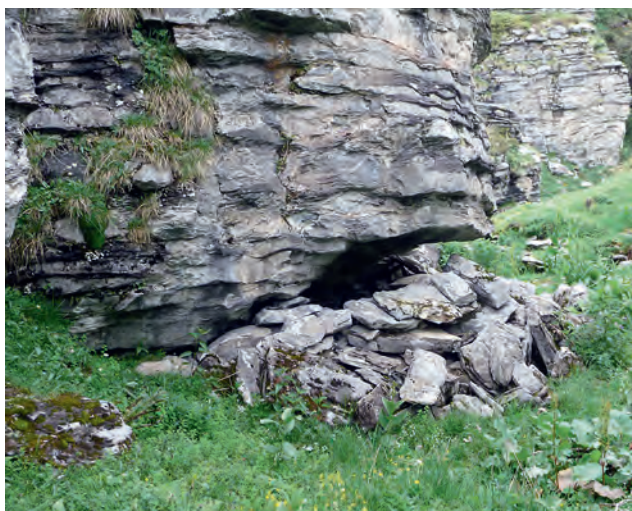
Abb. 92 Hasliberg BE, Hinder Tschuggi 9, Konstruktion unter Fels Kat. 34. Die halbrunde Konstruktion unter Fels ist an eine Felswand im Tschugginollen gebaut und wird vom vorspringenden Fels überdacht.
