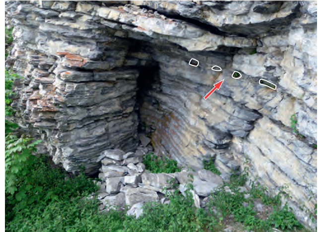
Abb. 89 Hasliberg BE, Hinder Tschuggi 12, Konstruktion unter Fels Kat. 37. Mögliche Balkenlöcher in der Felswand; unten ist die Innenunterteilung der zweiteiligen Konstruktion unter Fels zu sehen.
