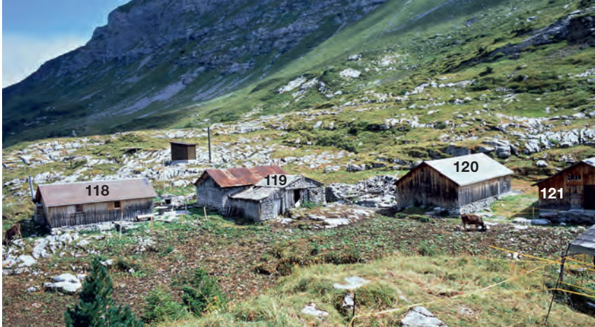
Abb. 135 Innertkirchen BE, Achtelsass. Die halb zerfallene Sennhütte mit angebauten Ställen Kat. 119 wurde wieder instand gestellt. Blick nach Nordosten.
