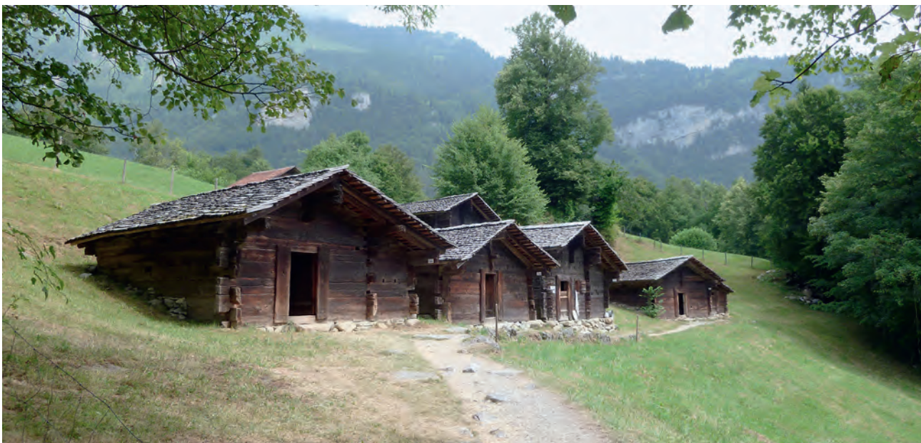
Abb. 168 Fünf von der Alp Richinen (Bellwald VS) ins Freilichtmuseum Ballenberg versetzte Alpgebäude. Blick nach Nordosten.
