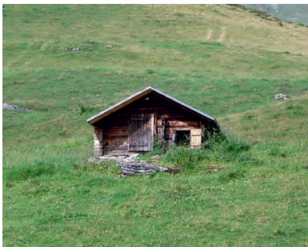
Abb. 83 Hasliberg BE, Hinder Tschuggi. Wie die meisten Schweineställe befindet sich dieser zweitürige Blockbau aus Kanthölzern etwas abseits der Alphütten.
