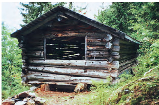
Abb. 185 Innertkirchen BE, Obri Schmallau. Aus Rundhölzern gebauter Heugaden.
