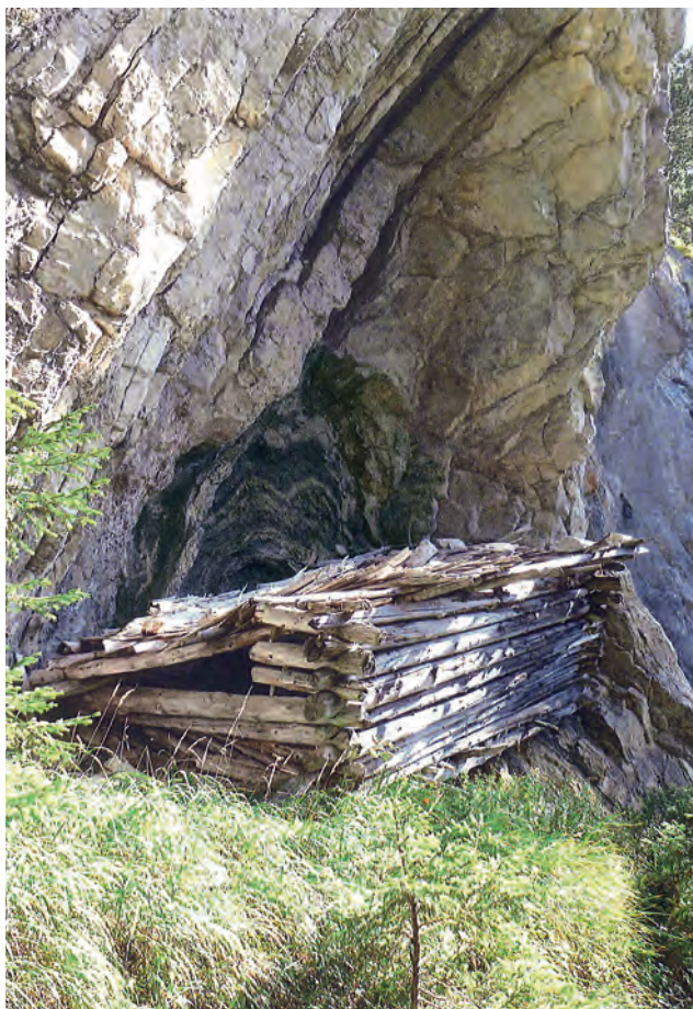
Abb. 184 Innertkirchen BE, Gadmental. Gaden zur Einlagerung von Wildheu. Die Abdeckung war ursprünglich vermutlich als Pulldach an die Felswand gelehnt.
