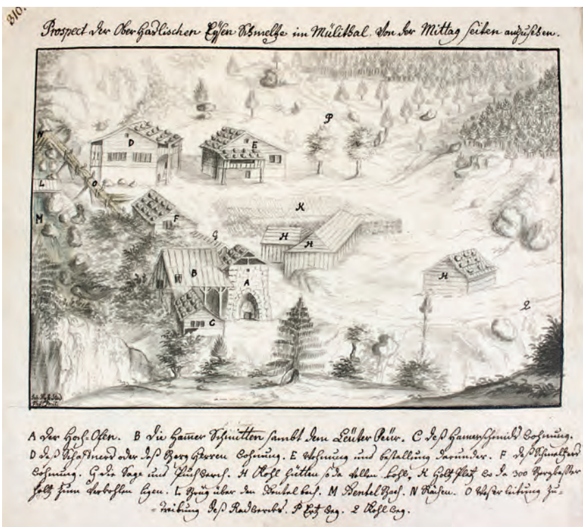
Abb. 30 Das Bergwerk im Mühletal um 1760: «A Der Hochofen; B Die Hammer Schmittten sambt dem Leüter Feür; C Des Hammer schmidts wohnung; D Des Schaffners oder dess Berg Herren wohnung; E Wohnung und bestallung darunder; F Dess Schmelzers Wohnung; G Die Sage und Puchwerk; H Kohl hütten so da vollen kohli; K Holtz Platz wo da 300 Bergklaffer Holz zum verkohlen ligen; L Brüg über den Gentalbach; M Gental Bach; N Rächen; O Wasserleitung zu treibung dess Radwerks; P Ertz weg; Q Kohlweg.» Lavierte Tuschzeichnung von Johannes Wyss, 1760.
