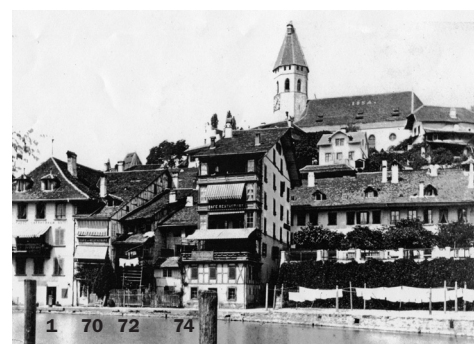
270 Thun, Obere Hauptgasse, Aarequai mit Plätzli zwischen 1862–1875 (Balkon Freienhofgasse 1 von 1862 und Neubau der Häuser Nr. 70 bis 74 nach 1875), Blickrichtung gegen Norden, Foto o. J.
