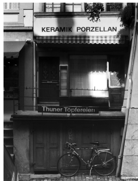
240 Thun, Obere Hauptgasse 45, Gassengeschoss vor dem Umbau 1991, Blickrichtung gegen Norden, Foto o. J.
