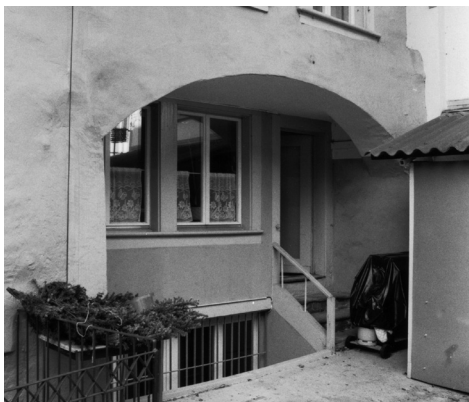
236 Thun, Obere Hauptgasse 39, Fassade Schlossbergseite mit Stützbogen, Blickrichtung gegen Süden, Foto o. J.
