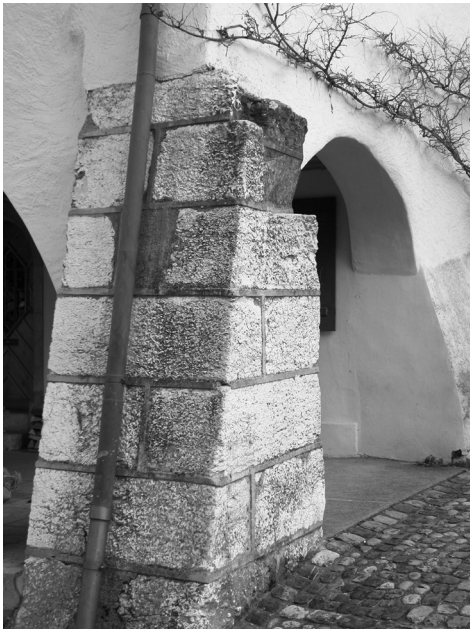
293 Altstadt 27, Laubengangbogenfragment von Nr. 29 (Abbruch 1783), Foto 2007.
