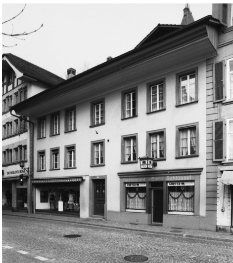
247 Thun, Obere Hauptgasse 77 und 79, Blickrichtung gegen Norden, Foto 1992.
