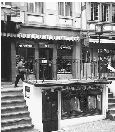
237 Thun, Obere Hauptgasse 43, Blickrichtung gegen Norden, Foto 1999.
