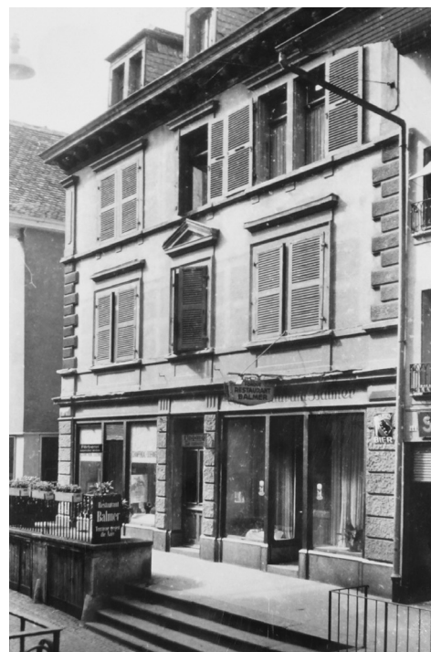
262 Thun, Obere Hauptgasse 46, Blickrichtung gegen Westen, Neubau 1897, Foto o. J.
