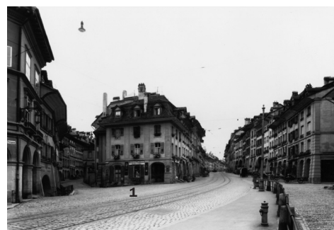
300 Bern, Gerechtigkeitsgasse 1, Blickrichtung gegen Südwesten, Foto 1940.
