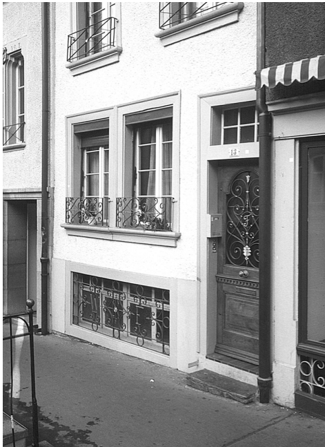
225 Thun, Obere Hauptgasse 13, Hochtrottoir-Geschoss mit Wohnnutzung, Blickrichtung gegen Norden, Foto 1999.
