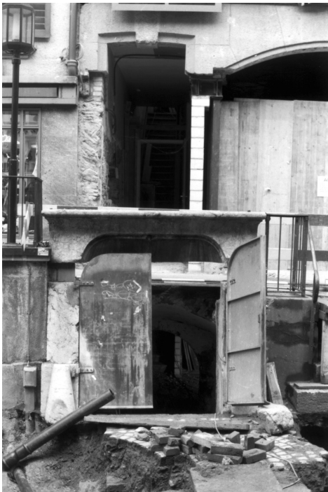
242 Thun, Obere Hauptgasse 53, Zugang zum Untergeschoss, Foto 1991.
