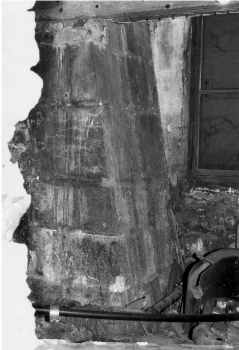
241 Thun, Obere Hauptgasse 45, Pfeiler von Nr. 47 im Innern, Foto 1991.
