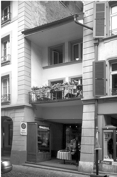
219 Thun, Obere Hauptgasse 3, Blickrichtung gegen Norden, Foto 1999.
