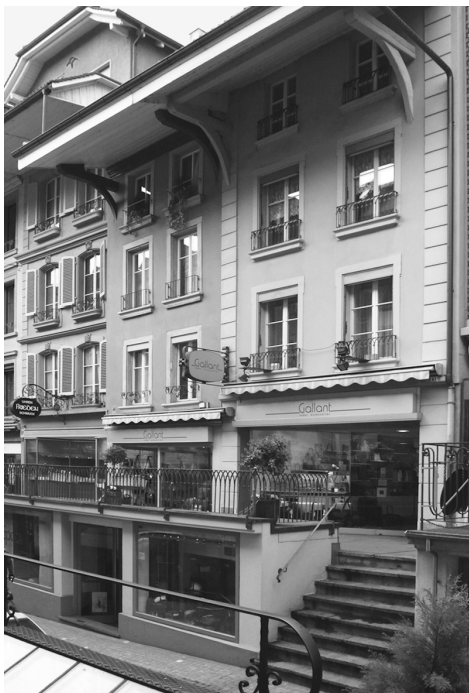
235 Thun, Obere Hauptgasse 39 und 41, Dachkonstruktion mit Bügen, Blickrichtung gegen Norden, Foto 2009.
