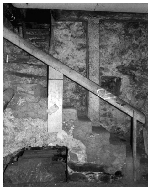
233 Thun, Obere Hauptgasse 35, interner Treppenaufgang, Foto, 1999.
