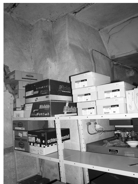
259 Thun, Obere Hauptgasse 30, Aareseite, Strebpfeiler gegen Nr. 32, Foto 2003.
