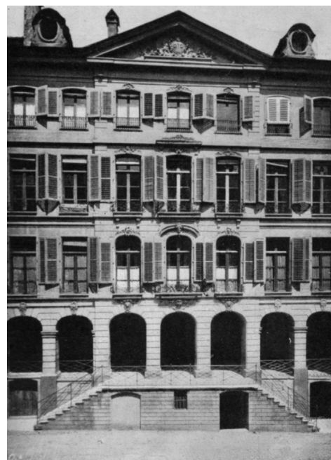
312 Bern, Gerechtigkeitsgasse 42, Blickrichtung gegen Norden, Foto o. J. (vor 1922).
