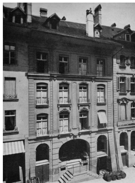
313 Bern, Gerechtigkeitsgasse 44, Blickrichtung gegen Norden, Foto o. J. (vor 1922).
