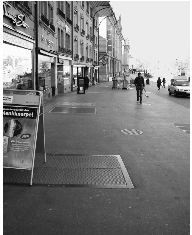
207 Bern, Kornhausplatz Westseite, bodenebene Kellerzugänge, Foto 2008.
