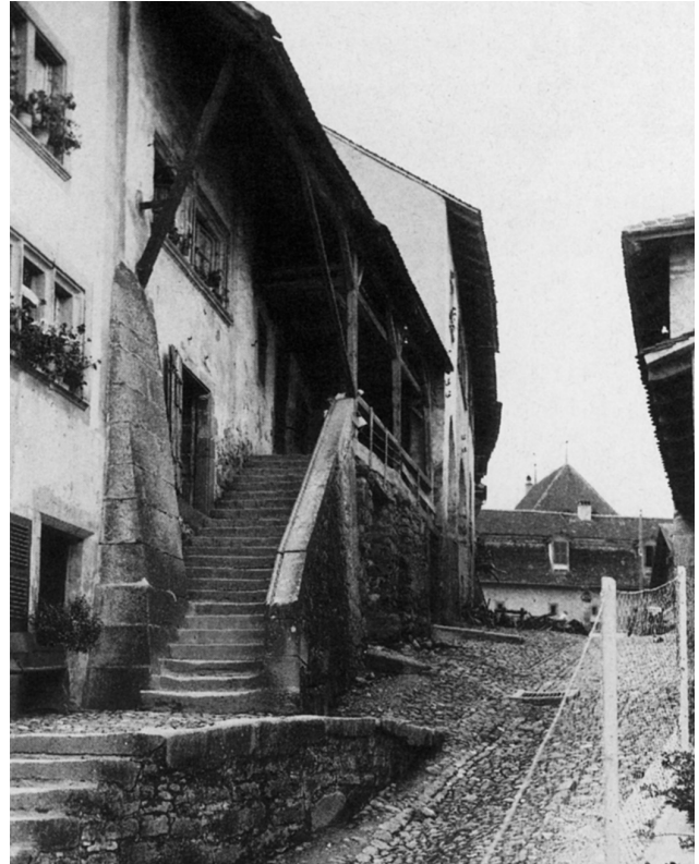
142 Erlach, Aufgang zur Hochlaube bei Altstadt 11, Foto um 1900.
