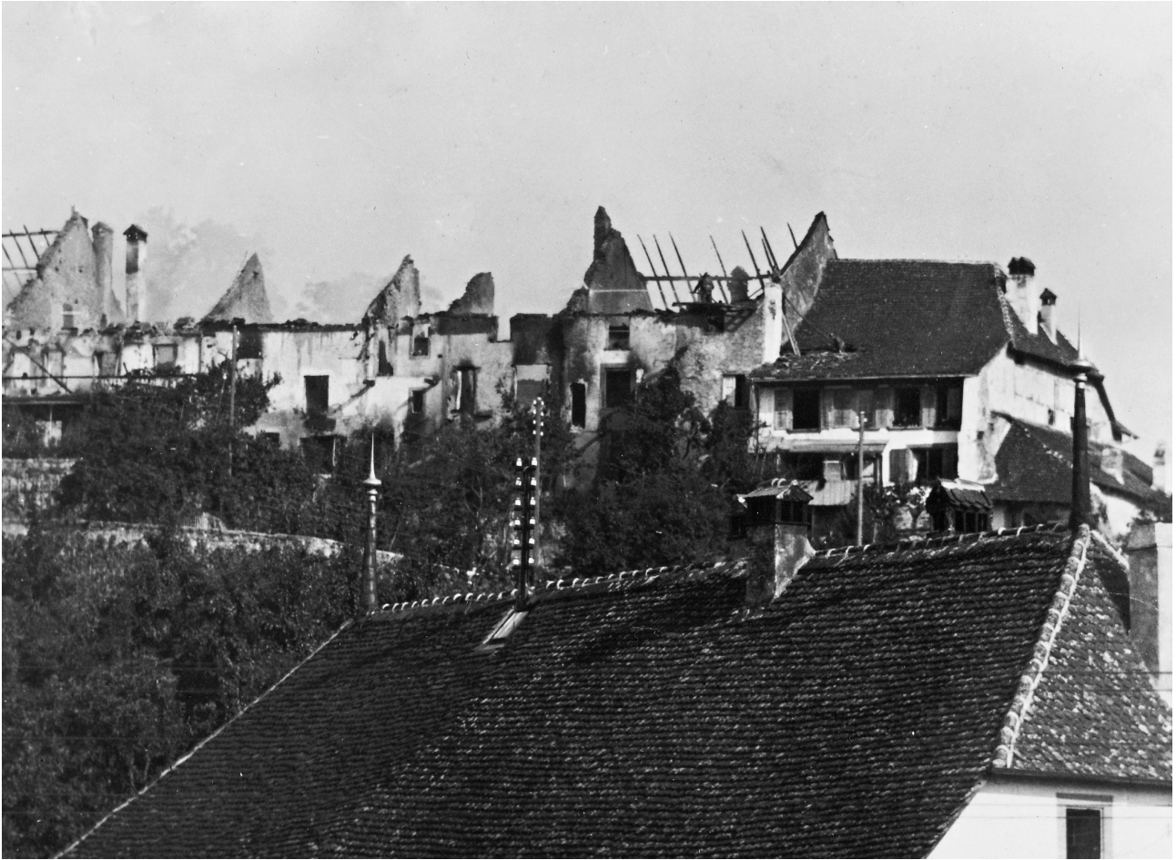
145 Erlach, Altstadt Südzeile nach dem Brand von 1915, Blickrichtung gegen Norden, Foto o. J.
