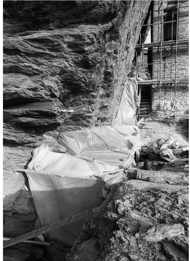
Abb. 16 Marmorera, Burg Marmels. Um den böenartigen Wind abzuhalten, wurde der fundreiche Felschrunn 1988 mit einem Plastikverhau eingepackt. Blick nach Norden.
