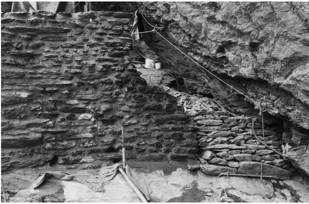
Abb. 12 Marmorera, Burganlage Marmels. Gebäude 3. Gemäss den Vorgaben des Ingenieurs ist die konservierte Mauer seitlich durch Trockenmauerwerk ergänzt, welches das dahinter liegende Terrain stützt. Blick nach Süden.
