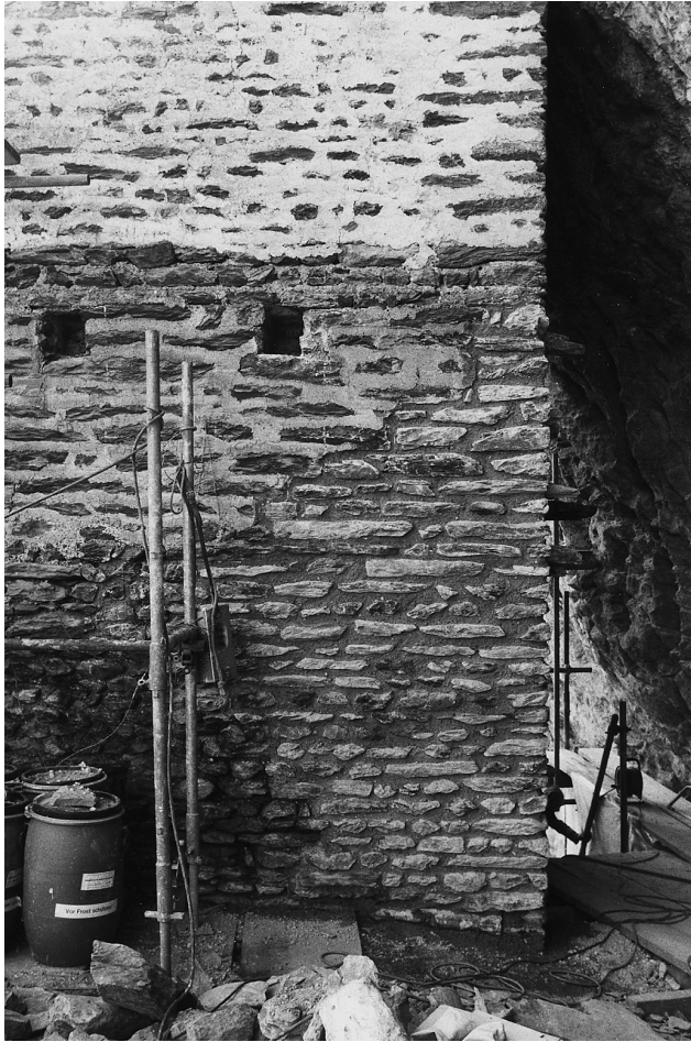
Abb. 13 Marmorera, Burganlage Marmels. Nordfassade der Kapelle. Zwei unterschiedliche, nach Stockwerken getrennte, originale Pietra-rasa-Verputzstrukturen. Rechts unten die stärker steinsichtige Untermauerung von 1988. Blick nach Süden.
