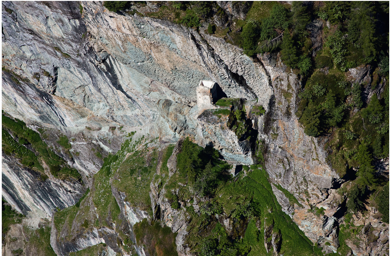
Abb. 5 Im Norden der Burganlage führt ein steiler Weg hinauf zum Burggelände. Dieser führt vor die Reste des abgegangenen Gebäudes 3. Beim in der Bildmitte erkennbaren Gebäude handelt es sich um die – weitgehend erhaltene – Kapelle. Blick nach Südwesten.
