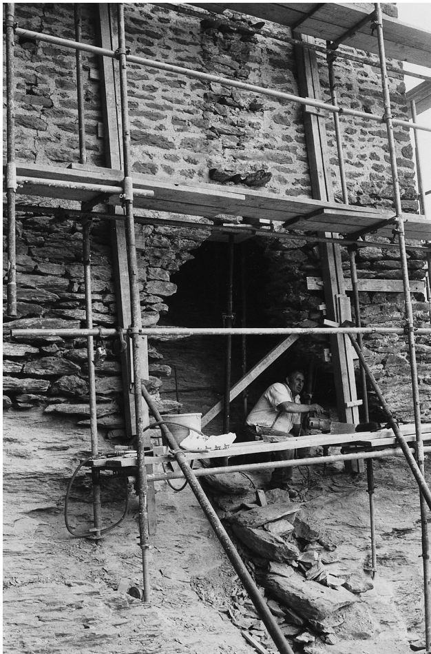
Abb. 10 Marmorera, Burganlage Marmels. Nachdem die einsturzgefährdete Südmauer der Kapelle mit Stahlprofilen provisorisch stabilisiert ist, bereitet der Polier Hans Galliard aus Sicherheitsgründen eigenhändig die Felsauflager für das Ergänzungsmauerwerk vor. Blick nach Nordosten.
