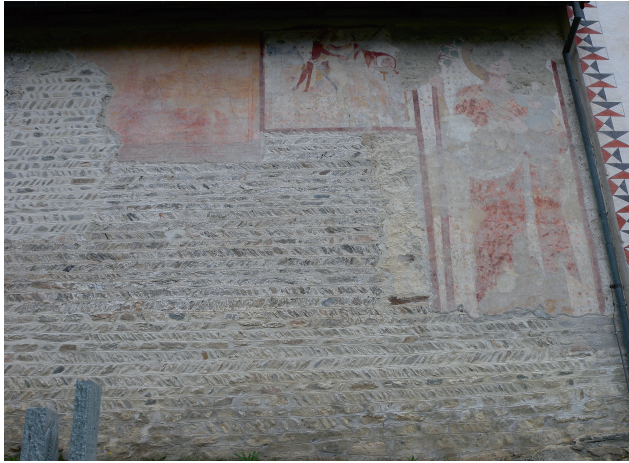
Abb. 150 Pitasch, evangelische Pfarrkirche 2011. Ausschnitt aus der Nordfassade des Schiffes. Blick nach Süden.
