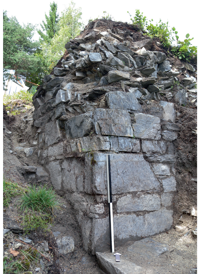
Abb. 149 Trin, Burg Hohentrins/Crap Sogn Parcazi 2010. Südwestecke des Hauptturms. Blick nach Norden.
