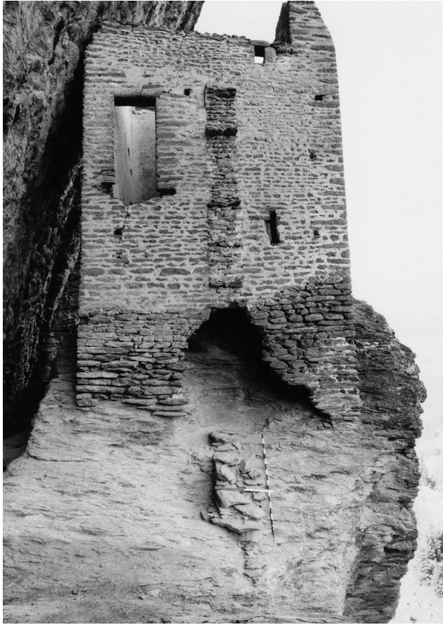
Abb. 29 Marmorera, Burganlage Marmels. Die Südfassade der Kapelle war mit einer nach Süden abgehenden Mauer verzahnt. Blick nach Norden.
