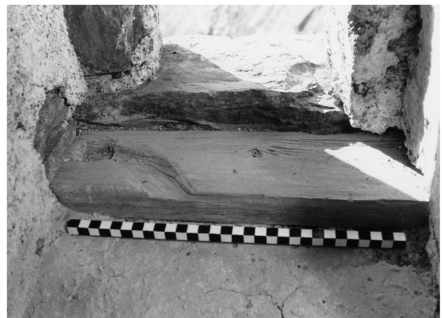
Abb. 50 Marmorera, Buranlage Marmels. Kapelle. Oberstes Fenster in der Südwand. Detail des Fensterbretts mit Einschubhilfe für die Fensterangel. Blick nach Süden.
