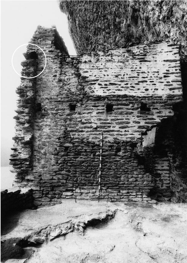
Abb. 65 Marmorera, Burganlage Marmels. Nordfassade der Kapelle beziehungsweise Südwand von Gebäude 2. Gut zu erkennen sind auch die Reste des Mörtelbodens 12. An der Stelle, wo die Ostmauer mit der Kapelle im Verband gestanden hatte, befindet sich eine Aussparung, die möglicherweise als Auflager für die südliche Pultdachpfette von Gebäude 2 diente. Blick nach Süden.
