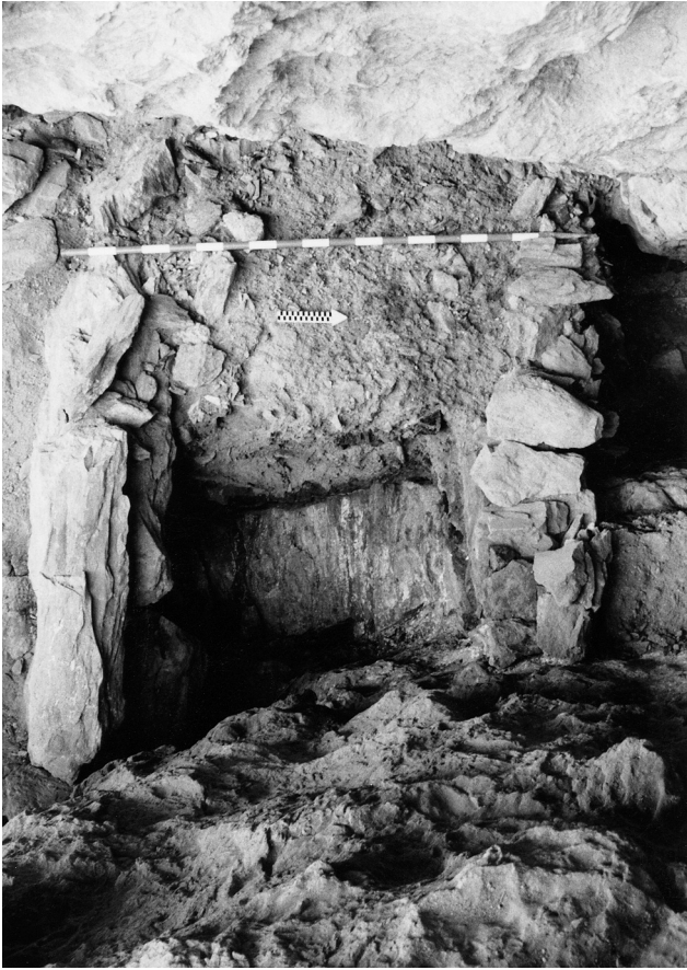
Abb. 27 Marmorera, Burganlage Marmels. Blick gegen Westen in den Felsschlund mit Mäuerchen 36 im Norden und Mäuerchen 37 im Süden.
