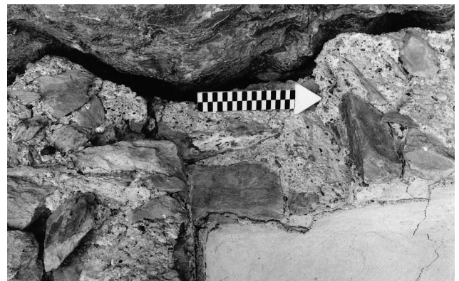
Abb. 57 Marmorera, Burganlage Marmels. Kapelle. Detail des südlichen Balkennegativs in der Mauerkrone der Westmauer. Blick nach Westen.
