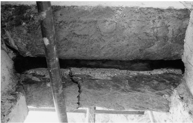
Abb. 48 Marmorera, Buranlage Marmels. Hocheingang der Kapelle. Reste des verkohlten Sturzbalkens. Blick vom Innern der Kapelle nach Süden.
