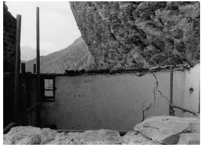
Abb. 54 Marmorera, Burganlage Marmels. Kapelle. Oberster Teil der Südwand. Am Verputz ist die ursprüngliche Dachschräge abzulesen. Blick nach Süden.
