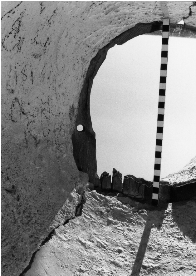
Abb. 42 Marmorera, Burganlage Marmels. Ostwand der Kapelle. Detail des Okulus: Holzrahmen mit Loch und Nut für das Fensterglas. Blick nach Osten.
