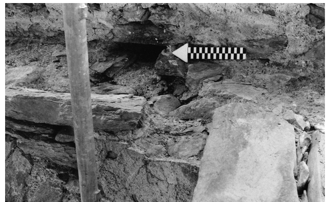
Abb. 58 Marmorera, Burganlage Marmels. Ecke Südmauer/Ostmauer. Detail des südlichen Balkennegativs in der Mauerkrone der Ostmauer, der Nordpfeil zeigt auf den südlichen Ausguss für das Dachwasser. Blick nach Osten.
