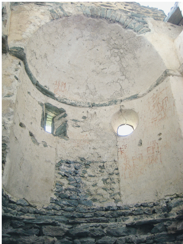
Abb. 33 Marmorera, Burganlage Marmels. Kapelle. Glatter Verputz im Obergeschoss der Kapelle. Apsis mit Okulus, Rechteckfenster und wulstförmigem, verkröpftem Gesims. Die quadratische Aussparung im Verputz markiert die Stelle des einstigen Altares. Blick nach Osten.
