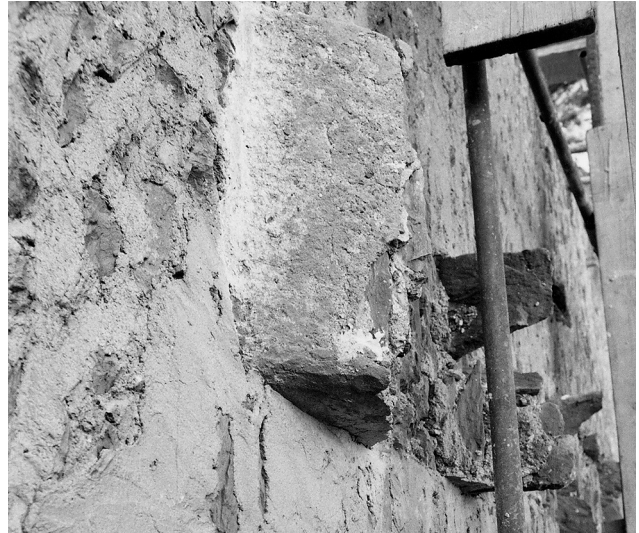
Abb. 59 Marmorera, Burganlage Marmels. Kapelle. Verzahnung der Südfassade mit der nach Süden abgehenden Verbindungsmauer zwischen Kapelle und Gebäude 1 mit schräg abfallender Mauerkrone. Blick nach Osten.
