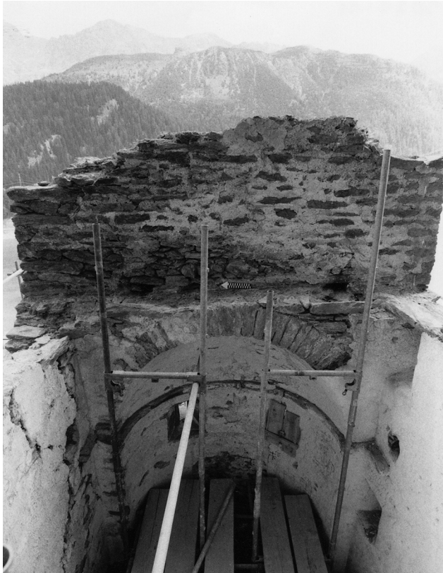
Abb. 40 Marmorera, Burganlage Marmels. Apsis und schräg gemauerter Aufbau über der Ostmauer mit zwei Kanälen zum Ableiten des Dachwassers. Blick nach Osten.
