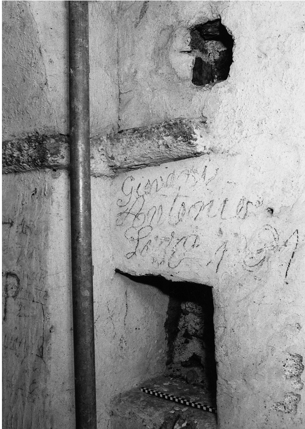
Abb. 55 Marmorera, Burganlage Marmels. Ecke Ostwand/Südwand der Kapelle. Unter dem verkörpften Gesims befindet sich eine Wandnische in der Südwand, über dem Gesims ein Balkenloch. Blick nach Südosten.
