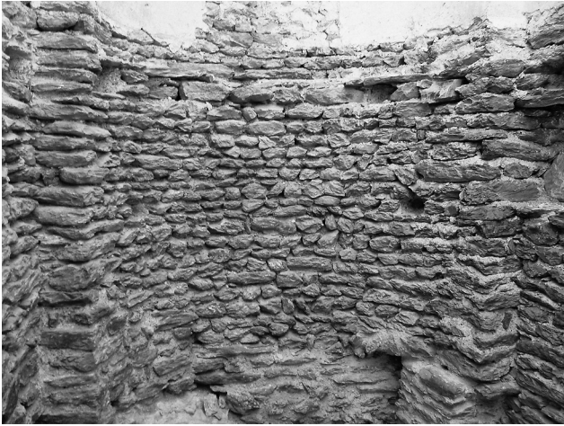
Abb. 31 Marmorera, Burganlage Marmels. Mauerwerk der Ostmauer im ersten Geschoss der Kapelle. Blick nach Osten.
