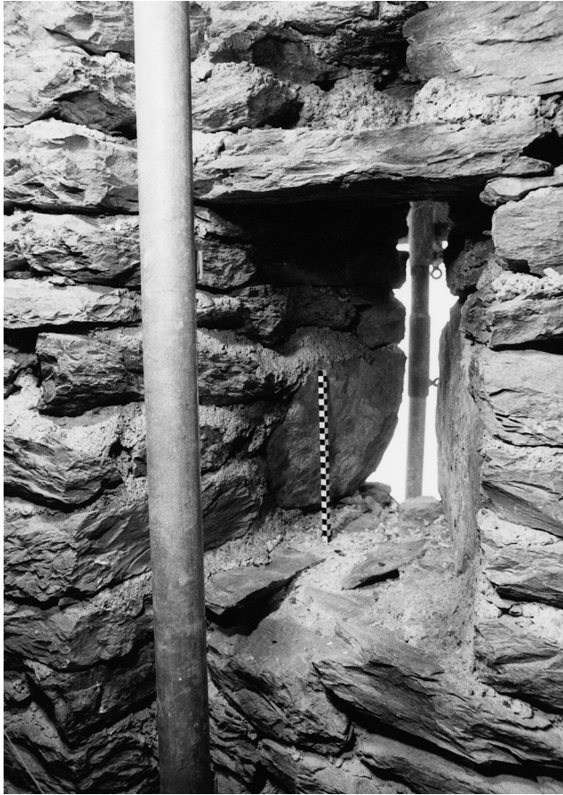
Abb. 51 Marmorera, Burganlage Marmels. Kapelle, Südwand. Scharte im Untergeschoss. Blick nach Südosten.
