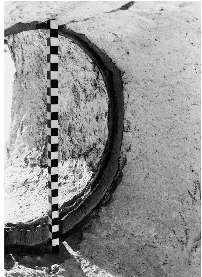
Abb. 42 Marmorera, Burganlage Marmels. Ostwand der Kapelle. Detail des Okulus: Holzrahmen mit Loch und Nut für das Fensterglas. Blick nach Osten.
