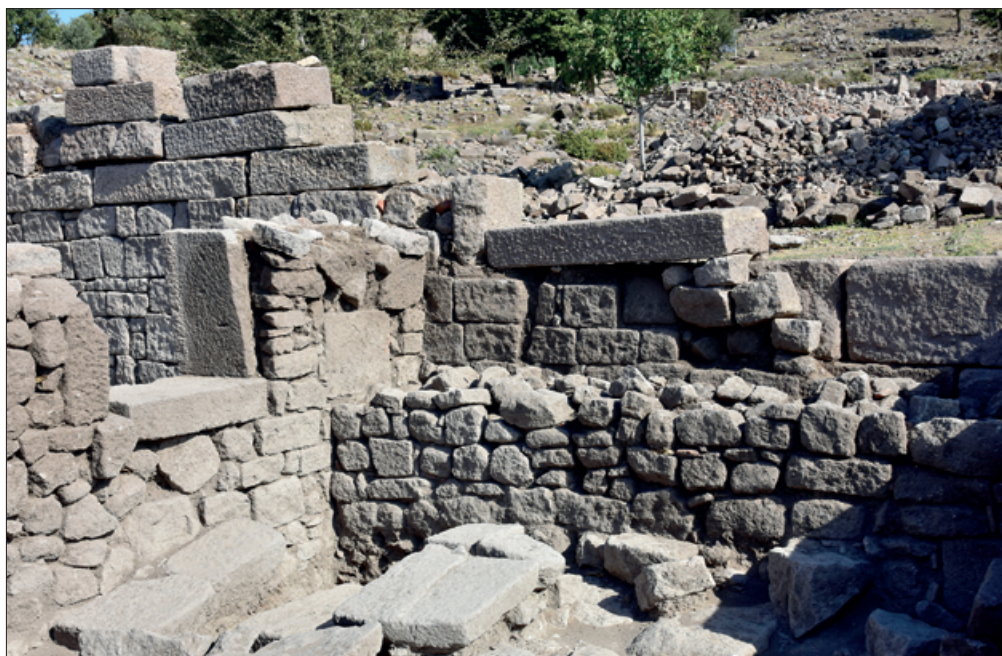
Abb. 47 Bank und Fenster in Raum 9 des Großen Gebäudes. – (Foto Assos-Grabung).
