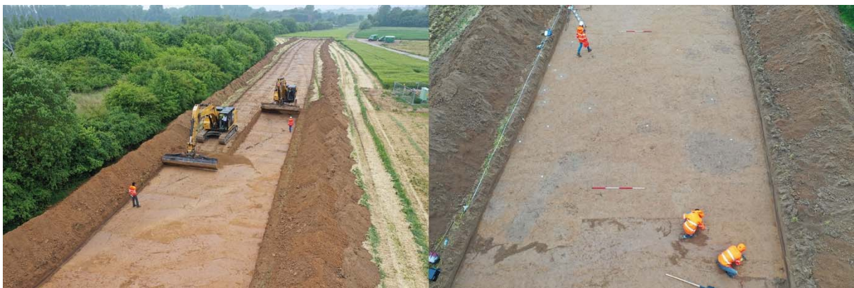
Abb. 5 Drohnenaufnahmen: Anlage des 10 m breiten Sondagestreifens mit zwei Großbaggern im Bereich des Fundplatzes NI 2019/1064 (links) und Planumsdokumentation mit Feinputz des Planums (rechts).
