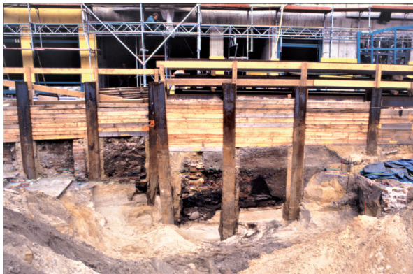
Abb. 97 Zwischen den Stahlträgern und unter den Verbauhölzern ist die Fortsetzung des Kellers 1093 erkennbar, der bis heute unter dem Straßenkörper in der Schlosskirchstraße erhalten geblieben ist.
