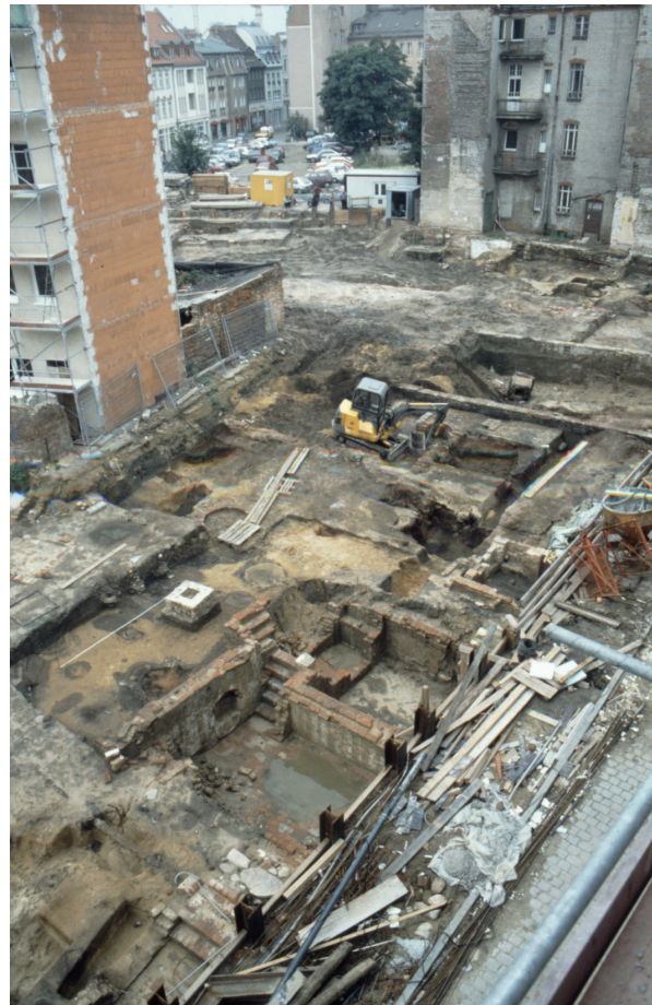
Abb. 15 Blick vom Kran auf den westlichen Teil der Untersuchungsfläche mit freigelegten Kellern unterschiedlicher Zeitstellung. Ein Beleg für die komplexe Situation vor Ort und für das notwendige Verständnis, eine solche Grabung in den Griff zu bekommen und den Überblick zu behalten.
