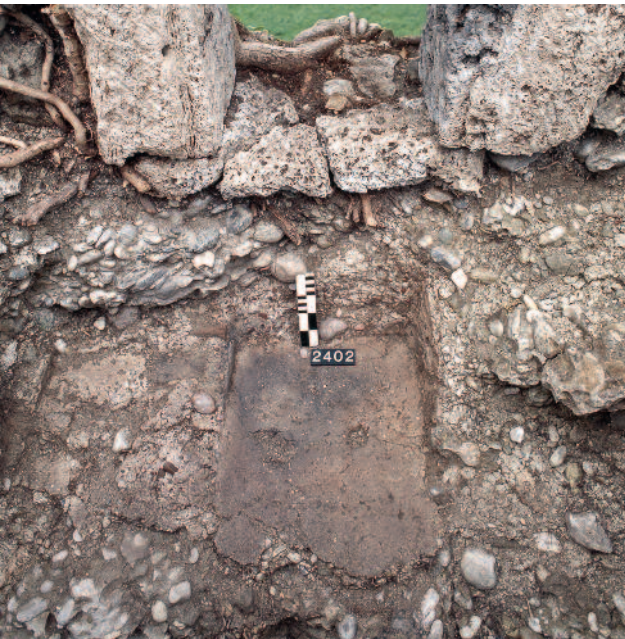
Abb. 112 Kastelen LU. Innenseite Ost, 3. Obergeschoss. Sitznische des Fensters Pos. 2402. Die beiden Sitzbänke sind fast vollständig zerfallen, der Mörtelstrich am Boden der Nische ist jedoch noch gut erhalten. Blick gegen Osten.
