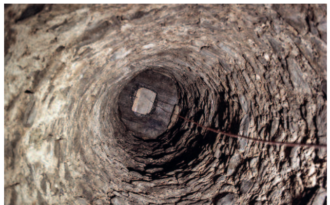
Abb. 261 Kastelen LU. Brunnenkranz des Sodbrunnens, Blick nach oben zum geöffneten Betondeckel.
