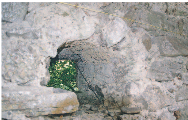
Abb. 135 Kastelen LU. Innenseite Nord, 2. Obergeschoss. Nachträglich durch die Mauer gebrochene Rauchöffnung Pos. 1302. Das Tonnengewölbe weist Negative der Schalungsbretter auf. Blick gegen Nordosten.
