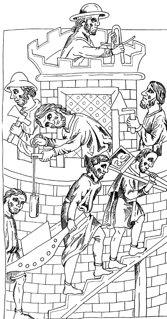
Abb. 197 Unter der Leitung des Baumeisters (mit Zirkel) arbeitet eine hierarchisch gegliederte Bau-truppe: Fachkräfte wie Steinmetze und Maurer stehen über den einfachen Lastenträgern und Handlangern. Umzeichnung einer spätmittelalterlichen Buchmalerei (Morgan Psalter, um 1200; New York, Pierpont Morgan Library, Ms. 338, fol. 168v).
