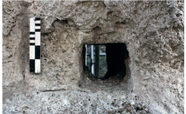
Abb. 140 Kastelen LU. Westfassade, Erdgeschoss. Äussere Mündung des Kanals Pos. 4105. Das im Mörtel unmittelbar an der Mündung erhaltene halbrunde Negativ weist auf eine einst hier eingelegte hölzerne Rinne hin. Blick von Westen.
