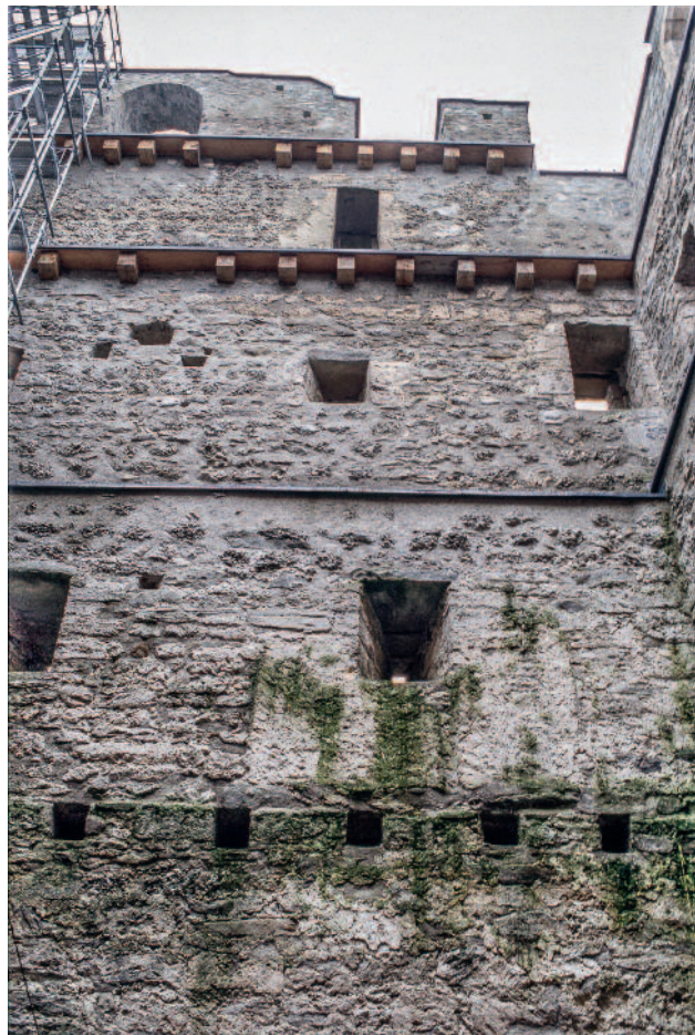
Abb. 343 Kastelen LU. Innenseite Nord nach erfolgter Restaurierung. In den oberen Stockwerken sind eichene Balkenstummel in die Negative der Balkenlagen eingesetzt. Der Mauerabsatz zum 2. Obergeschoss ist mit Bleifolie abgedeckt. Blick gegen Norden.
