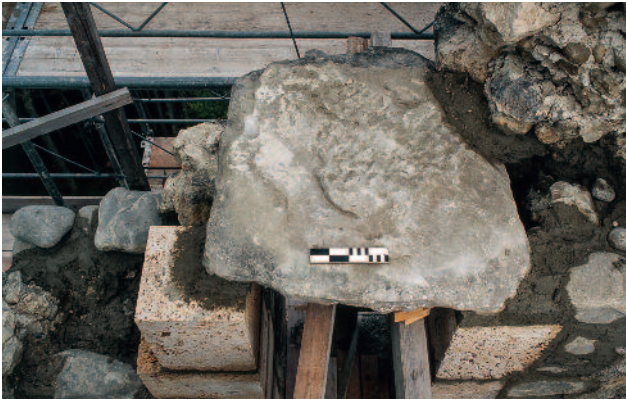
Abb. 184 Kastelen LU. Nordseite, 4. Obergeschoss. Freiliegende, soeben frisch versetzte Sturzplatte über dem Austritt Pos. 1501 an der Nordwest- ecke, mit deutlich sichtbaren Bearbeitungsspuren.
