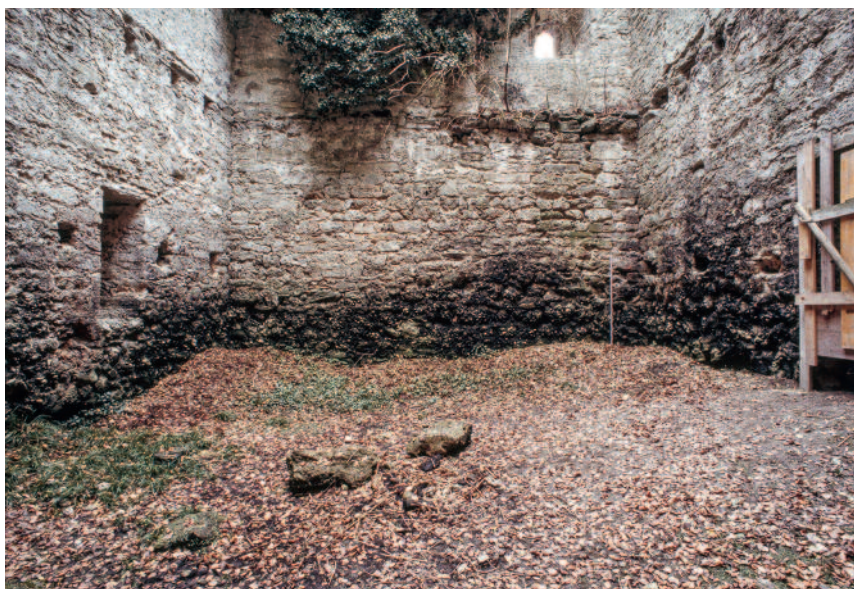
Abb. 296 Kastelen LU. Vor der Konservierung 1998–2002 präsentierte sich das Innere des Wohnturms als unregelmässige Hügelandschaft, die von Südosten gegen Nordwesten hin abfiel. Blick gegen Osten.
