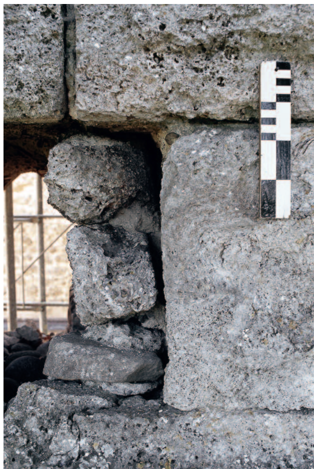
Abb. 137 Kastelen LU. Nordfassade, 2. Obergeschoss. Rauchöffnung Pos. 1302. Blick auf die Mündung mit Ausfütterung aus Tuffsteinbrocken. Blick von Norden.
