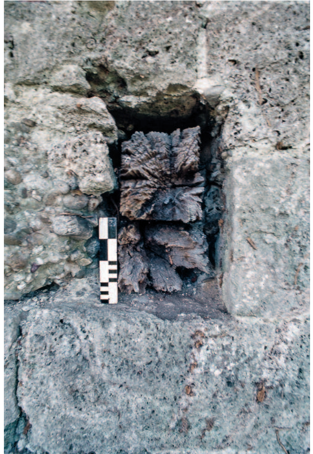
Abb. 168 Kastelen LU. Nordfassade, 3. Obergeschoss. Reste der beiden Kragbalken Pos. 1403 zu Abortaustritt Pos. 1402. Blick von Norden.
