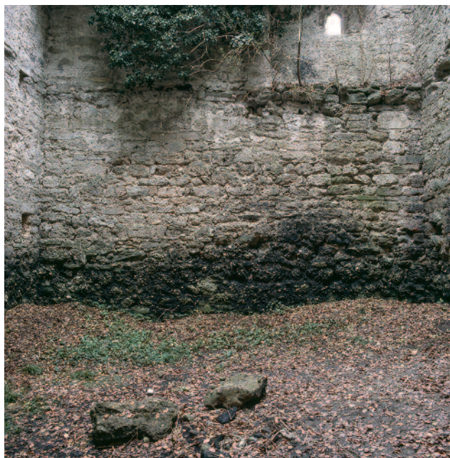
Abb. 149 Kastelen LU. Innenseite Ost. Im Bereich des Mauerrücksprungs der östlichen Kapellenwand (rechts oben) sind am Übergang vom Erd- zum 1. Obergeschoss die vorkragenden Steinlagen der Konsole Pos. 2104 zu erkennen. Links davon setzt sich das Negativ der Bodenbretter fort (Pos. 2103). Blick gegen Osten.
