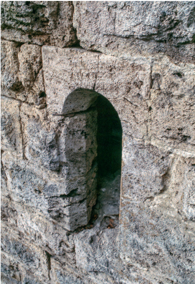
Abb. 119 Kastelen LU. Südfassade, 1. Obergeschoss. Rundbogenfenster Pos. 3201 (Kapelle). Die gesamte gefaste Fensteröffnung wurde aus Normquadern herausgearbeitet. Blick von Südosten.
