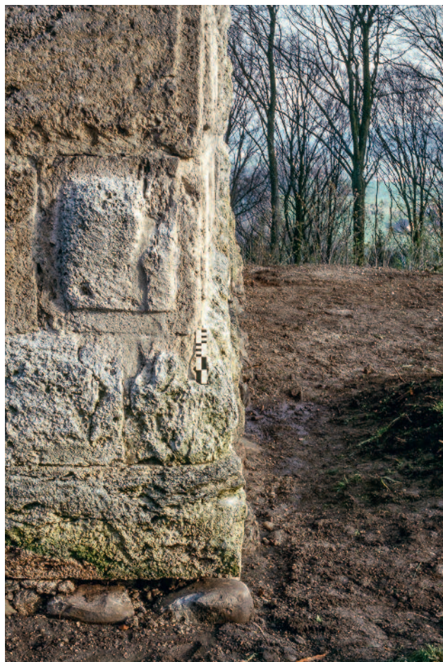
Abb. 82 Kastelen LU. Südfassade, Südostecke. Stirnseitiger Buckel eines Eckquaders. Blick von Süden.
