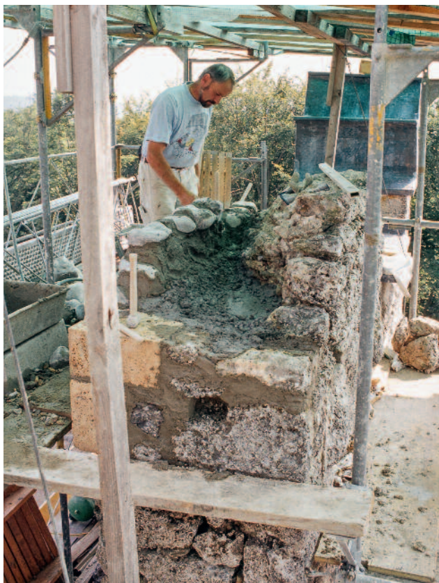
Abb. 331 Kastelen LU. Josef Wermelinger, Alberswil, beim Aufmauern des inneren Mauermantels an der Westseite des Wohnturms.
