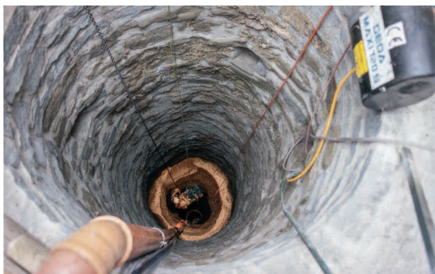
Abb. 19 Kastelen LU. Dokumentation des Sodbrunnens 2004 während der durch den Verein Burgruine Kastelen vorgenommenen Sanierungsarbeiten: Christoph Rösch beim Vermessen des Brunnenschachtes.
