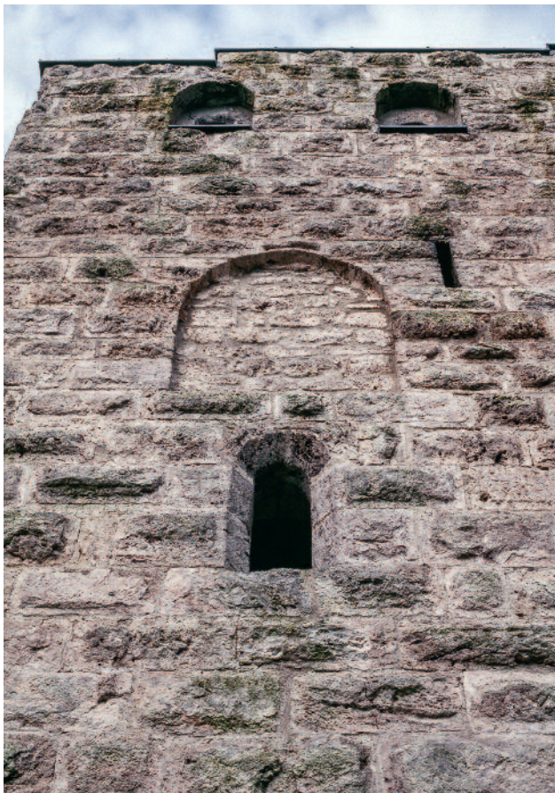
Abb. 223 Kastelen LU. Ostfassade, 1. bis 3. Obergeschoss. Spitzbogige Mauernische Pos. 2311 unmittelbar über dem östlichen Kapellenfenster Pos. 2202. Blick von Osten.
