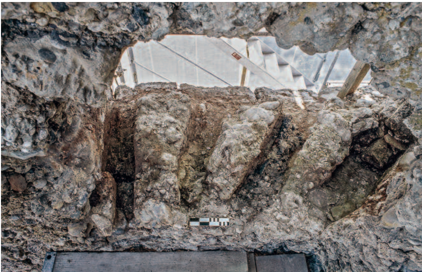
Abb. 186 Kastelen LU. Nordwestecke, 4. Ober- geschoss. Negative der fächerförmig angeord- neten Erkerkonsolen im Mauerausbruch Pos. 4403 (Pos. 1426, 4407-4409). In den Negativen sind Brandrötungen und verkohlte Holzreste zu erken- nen. Aufsicht/Blick gegen Westen.
