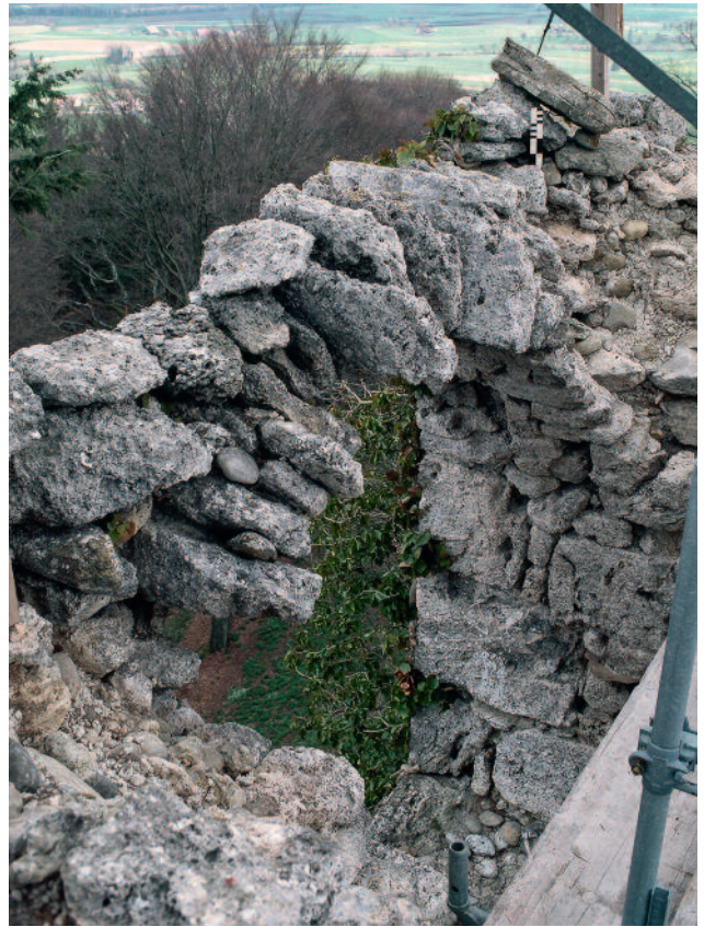
Abb. 123 Kastelen LU. Innenseite Nord, 4. Obergeschoss. Rundbogenöffnung Pos. 1502. Reste des Gewölbes und östliche Leibung. Blick gegen Nordosten.
