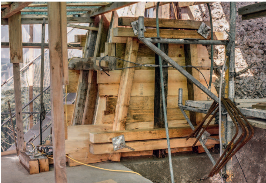
Abb. 335 Kastelen LU. Westseite, 4. Obergeschoss. Unterer Teil der Schalung für den in zwei Etappen betonierten Stützkeil über der Südwestecke. Blick gegen Nordwesten.
