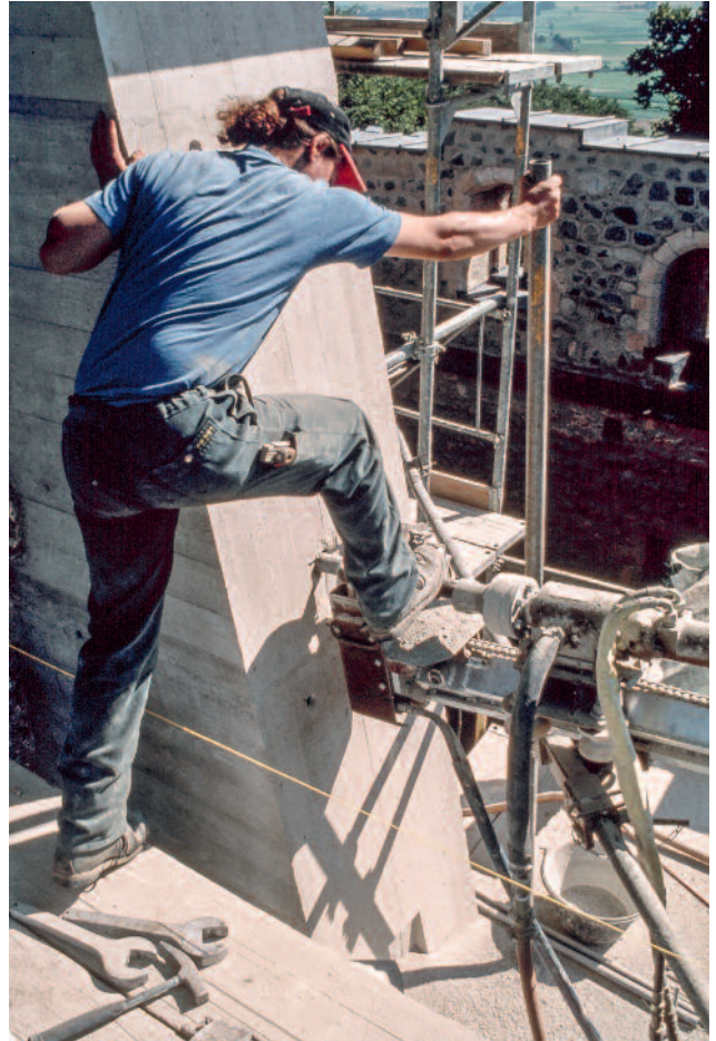
Abb. 336 Kastelen LU. Westseite, 4. Obergeschoss. Bohrarbeiten für das Einsetzen eines Zugankers in den Mauerkern beim betonierten Stützkeil über der Südwestecke. Blick von Südwesten.
