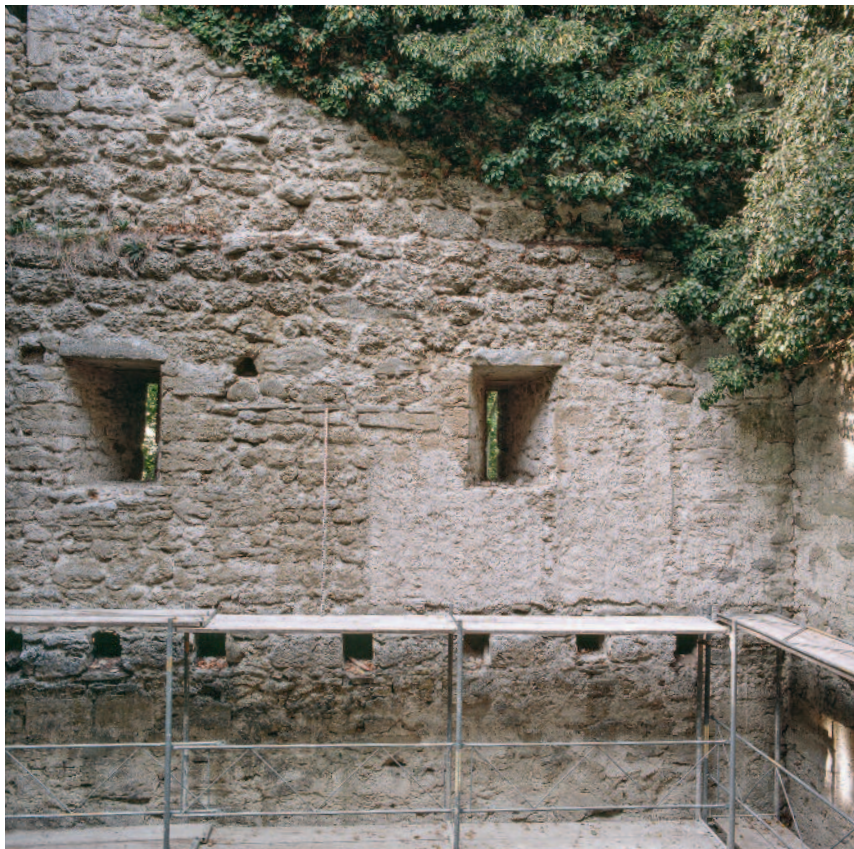
Abb. 244 Kastelen LU. Innenseite Nord, 1. Obergeschoss. Rechts ist der sekundäre Verputz Pos. 5201 mit den Negativen senkrecht stehender Hölzer zu erkennen. Er scheint in der Bildmitte von einer Wand begrenzt worden zu sein. Zustand vor der Restaurierung. Blick gegen Norden.
