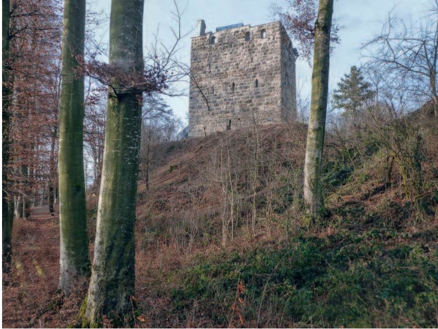
Abb. 274 Kastelen LU. Der als Monolith auf seinem Plateau stehende Wohnturm wendet der übrigen Burganlage seine Hauptseiten zu. Links die umlaufende Burgterrasse, rechts der Graben und der Ansatz des östlichen Plateaus. Blick von Südosten.
