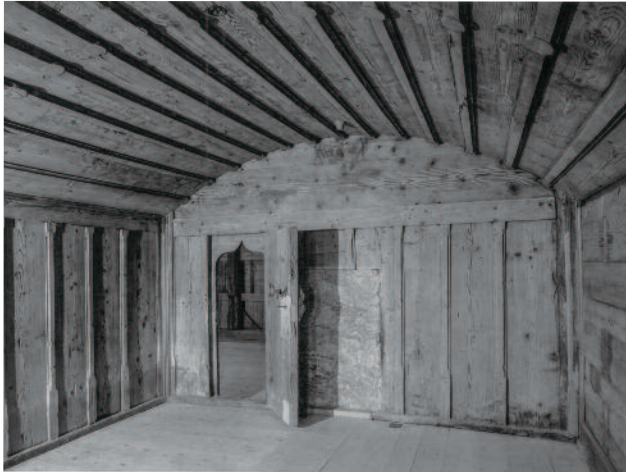
Abb. 229 Hohenrain LU, Johanniterkommende. Anderes Jahrhundert, gleiches Konzept: Spätmittelalterliche Stube im Obergaden des Turms Roten (wohl 15. Jh.), hier mit gewölbter Bohlen-Balkchen-Decke und Kachelofenstandort in der Wandmitte neben der Tür.
