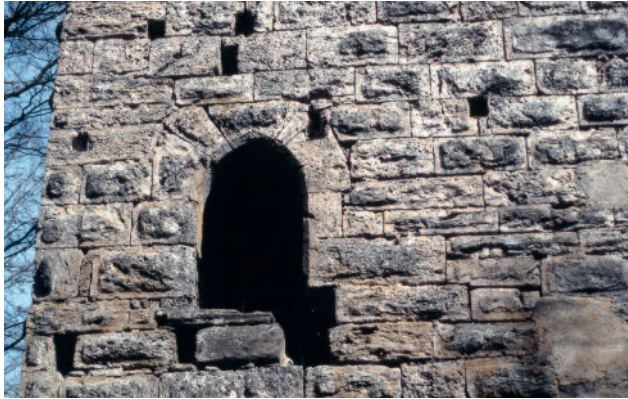
Abb. 158 Kastelen LU. Westfassade, 1. Obergeschoss. Hocheingang Pos. 4202. Rund um das Spitzbogenportal sind die Balkenlager der gedeckten Zugangslaube sichtbar. Blick von Westen.
