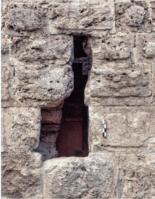
Abb. 297 Kastelen LU. Nachträglich zu einem Durchschlupf erweiterte Lichtscharte Pos. 3101 an der Südseite des Erdgeschosses. Blick von Süden.
