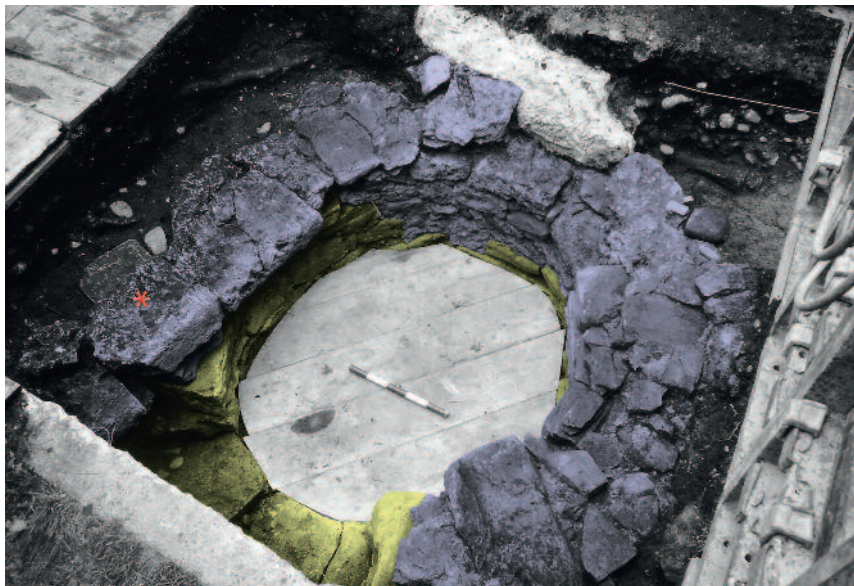
Abb. 262 Kastelen LU. Mauerkranz des Sodbrunnens im Zustand der Freilegung 2003. ■ mittelalterliches Mauerwerk ■ Aufmauerung im frühen 20. Jh. Der Stern bezeichnet das Gesimsfragment Kat. 139.
