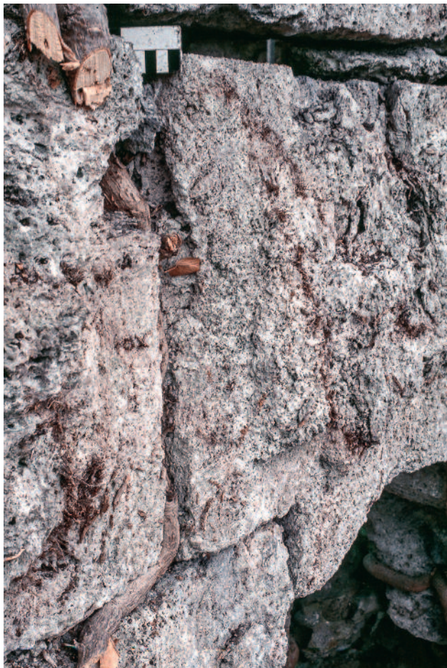
Abb. 107 Kastelen LU. Ostfassade, 3. Obergeschoss. Rechts der eingehängte Sturzstein der Blende zu Rundbogenfenster Pos. 2402. Blick von Südosten.
