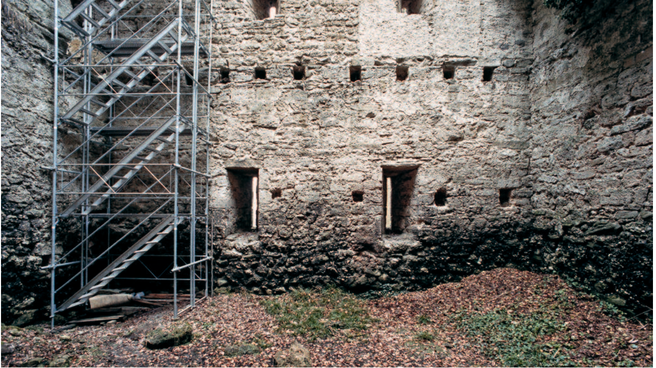
Abb. 235 Kastelen LU. Innenseite Nord, Zustand vor der Restaurierung. Deutlich sind auf Höhe der Lichtschlitze Pos. 1101 und 1102 die nachträglich in das Mauerwerk eingehauenen Auflager für die Balken des Zwischenbodens sowie möglicherweise die Träger eines Treppenpodestes zu erkennen. Blick gegen Norden.
