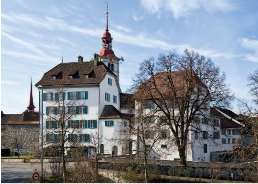
Abb. 26 Sursee LU. Mittelalterliche Stadtstrukturen in barockisiertem Gewand: Der St. Urbanhof besetzt die Eckposition in der kyburgischen Stadtmauerung. Um 1596–1598 wurde er fast gänzlich neu gebaut. Links davon der grosse ehemalige Stadthof des Klosters Muri: Dieses Gebäude besteht bis zum vierten Obergeschoss aus den Mauern des kyburgischen Stadtsitzes. Zwischen beiden Häusern führt das Hintertor in die Stadt und zum Kirchhügel mit der Pfarrkirche St. Georg.
