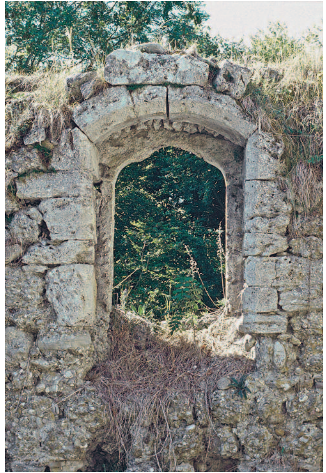
Abb. 115 Kastelen LU. Innenseite Süd, 3. Obergeschoss. Doppelfenster Pos. 3403. Das Doppelfenster wurde durch Entfernen des Mittelpostens und Abspitzen des Sturzes in ein grossflächigeres Fenster mit Sitzbank umgebaut. Blick gegen Süden.
