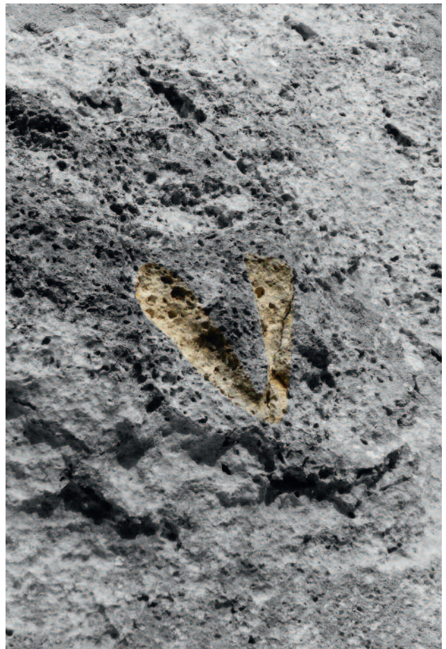
Abb. 201 Kastelen LU. Steinmetzzeichen «V». Die in die raue Oberfläche der Buckelquader geschlagenen Zeichen sind oft erst auf den zweiten Blick zu erkennen.
