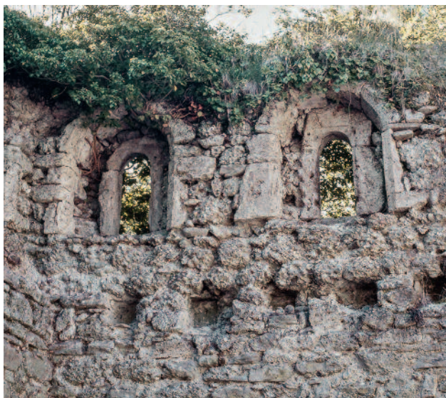
Abb. 108 Kastelen LU. Innenseite Süd, 3. Obergeschoss. Rundbogenfenster Pos. 3401 und 3402, Zustand während der Freilegung 1998. Blick gegen Süden.
