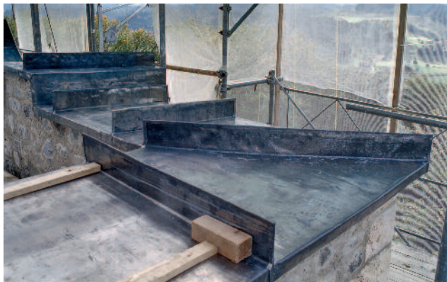
Abb. 341 Kastelen LU. Kronenabdeckung aus Bleifolie an der Nordwestecke des Wohnturms. Die senkrecht aufstehenden Stosslappen werden in einem nächsten Arbeitsschritt noch eingerollt. Blick von Nordosten.
