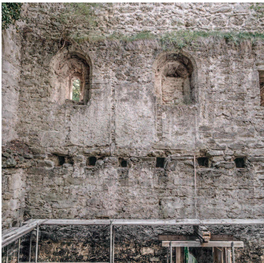
Abb. 245 Kastelen LU. Innenseite Süd. Im 1. Obergeschoss ist der Standort der Kapelle durch die Rundbogenfenster Pos. 3201 und 3202 ausgezeichnet. Die Wände tragen den sekundären Verputz Pos. 5201. Blick gegen Süden.
