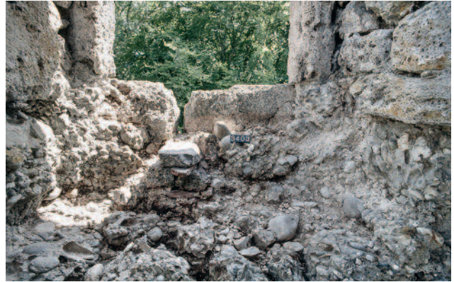
Abb. 126 Kastelen LU. Innenseite Süd, 3. Obergeschoss. Doppelfenster Pos. 3403. Die Fensterbank wurde bei einem Umbau abgetragen und mit einer durchgehenden Sitzbank versehen (vgl. Abb. 116). Der dabei entstandene Mauerflick ist in Resten erhalten (Mauerwerk mit Ziegeleinschüssen, Pos. 3411). Blick gegen Süden.
