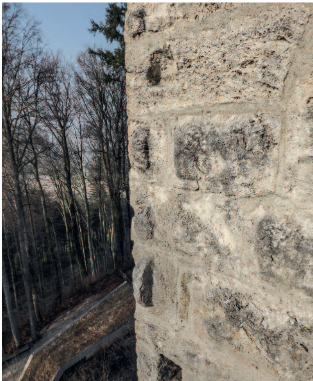
Abb. 159 Kastelen LU. Westfassade, 1. Obergeschoss. In die Buckelquader Ecksteine gehauene senkrechte Nut für die Laube zum Hocheingang. Sie beginnt oberhalb des Kragbalken-Negativs Pos. 4110 (unten) und wird unterbrochen durch das nachträglich eingehauene Auflager Pos. 4212 (oben). Blick von Südwesten.
