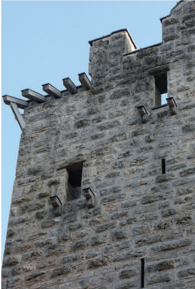
Abb. 167 Kastelen LU. Nordfassade, Zustand nach der Restaurierung (2016). Austritte auf die Aborterker des 2. und 3. Obergeschosses, links oben die Ansätze der Konsolen zum Wehrrerker des 4. Obergeschosses. Blick von Nordwesten.
