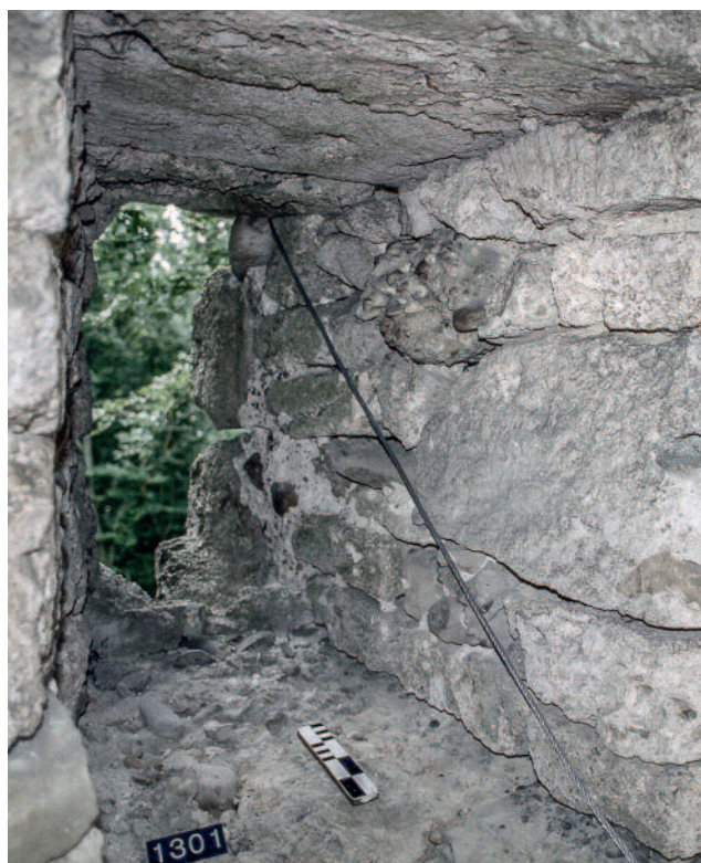
Abb. 129 Kastelen LU. Innenseite Nord, 2. Obergeschoss. Fenster­nische des Fensters Pos. 1327. Trotz starker Verwitterung ist der in die Tuffsteinquader geschlagene, um die Fensteröffnung laufende Fensterfalz zu erkennen. Blick gegen Norden.
