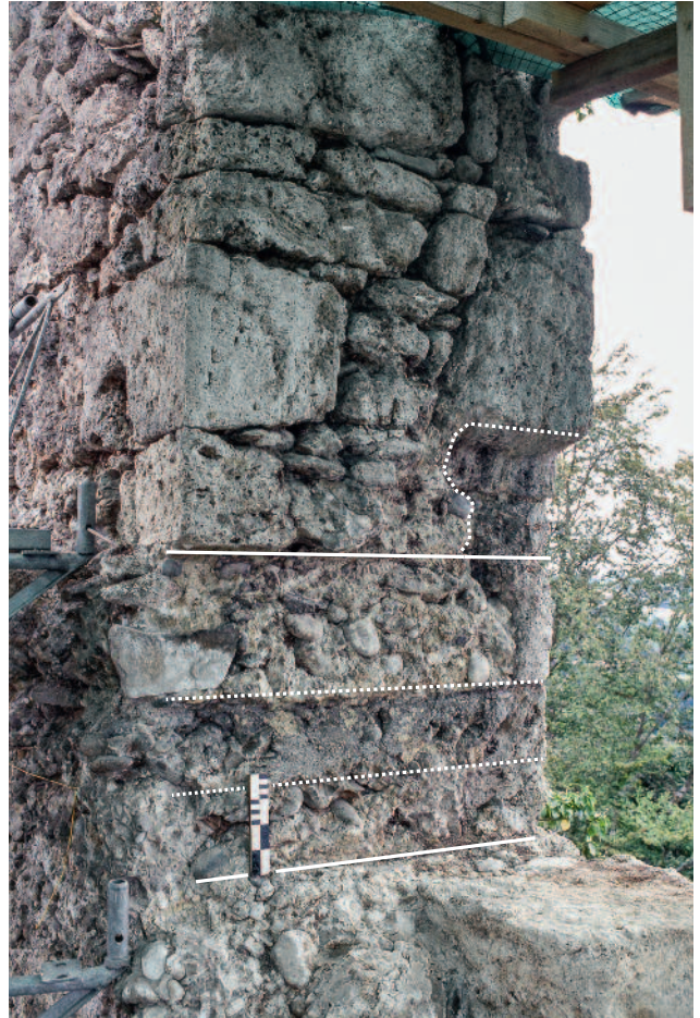
Abb. 180 Kastelen LU. Innenseite Nord, 4. Obergeschoss. Erkeraustritt Pos. 1509. Blick von innen an die westliche Leibung (obere Bildhälfte). Die äussere Kante der Türöffnung ist durch einen jüngeren Eingriff gestört (Pos. 5409), darunter folgt der Ausbruch der einstigen Erkerkonsole (Pos. 1419, mit Abdrücken dreier aufeinanderliegender Balken). Blick gegen Nordwesten.
