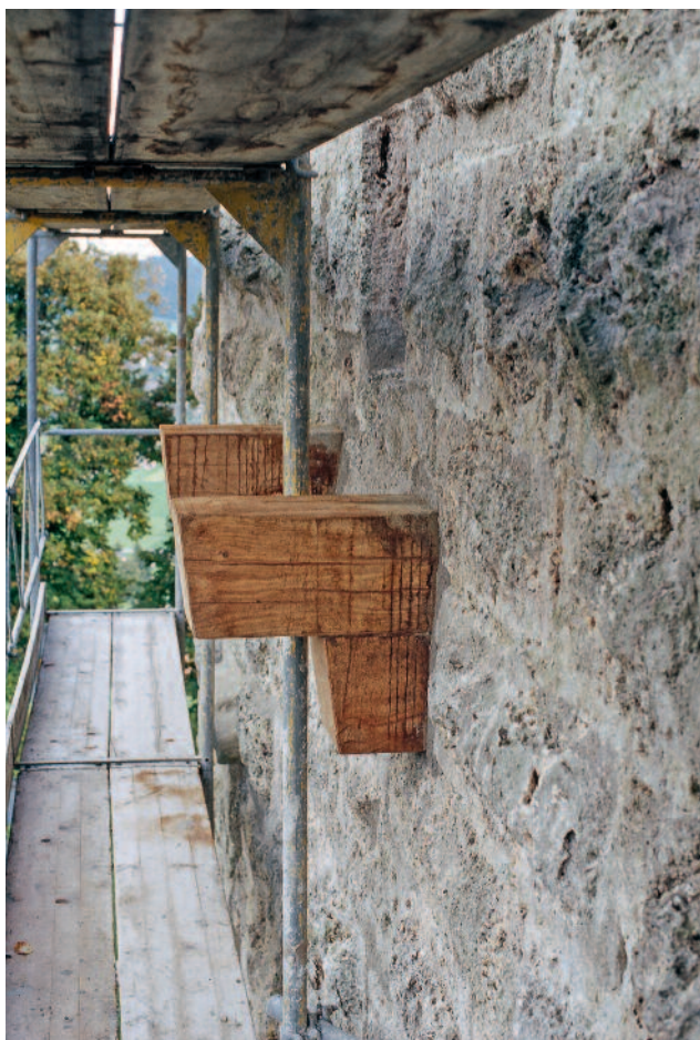
Abb. 169 Kastelen LU. Nordfassade, 3. Obergeschoss, Zustand nach der Restaurierung. Anstelle der Originalhölzer ins Mauerwerk eingesetzte eichene Balkenstummel unterhalb des Austritts Pos. 1402. Blick von Westen.
