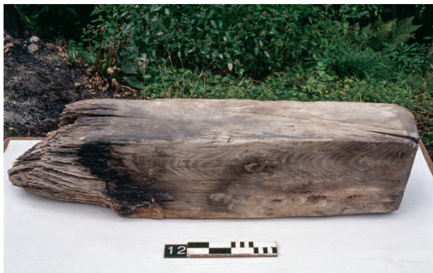
Abb. 208 Kastelen LU. Aus dem Balkenloch Pos. 1404 geborgener, sorgfältig bearbeiteter und an der Stirnseite mit dem Beil gefaster Balckenrest zur Konsole des Aborterkers Pos. 1402 (Nordseite, 3. Obergeschoss).
