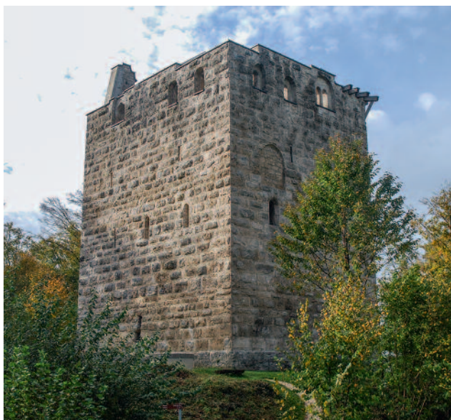
Abb. 73 Kastelen LU. Die Ruine des Wohnturms nach der Restaurierung, 2014. Blick von Südosten auf die Schauseiten des Bauwerks.
