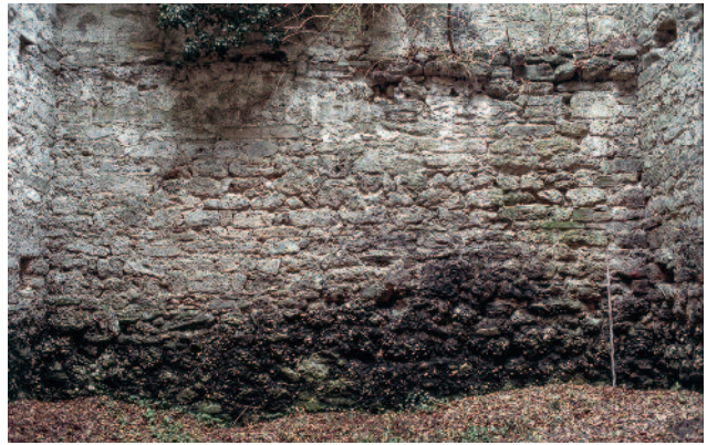
Abb. 85 Kastelen LU. Innenseite Ost, Erdgeschoss. Das Mauer­gefüge besteht im Sockelbereich mehrheitlich aus unregelmässigen Nagelfluhbrocken, darüber aus Sandsteinen und behauenen Tuffsteinen. Blick gegen Osten.
