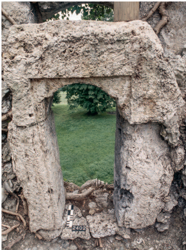
Abb. 110 Kastelen LU. Innenseite Ost, 3. Obergeschoss. Gewände des Sitznischenfensters Pos. 2402 mit rechteckiger Aussparung für den Fensterflügel (Fensterfalz). Blick gegen Osten.
