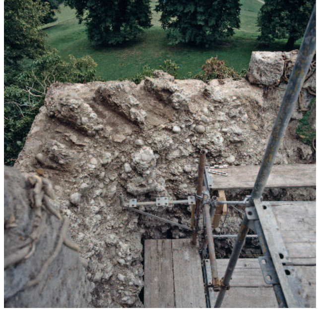
Abb. 188 Kastelen LU. Nordostecke, 4. Obergeschoss. Mauerkrone mit Resten der Balkennegative der fächerförmig angeordneten Erkerkonsolen. Blick gegen Osten.
