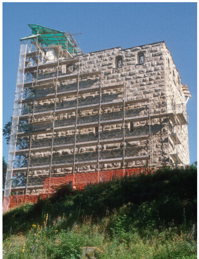
Abb. 332 Kastelen LU. Bereits teilweise abgebautes Gerüst an der Südfassade, Blick von Südosten.
