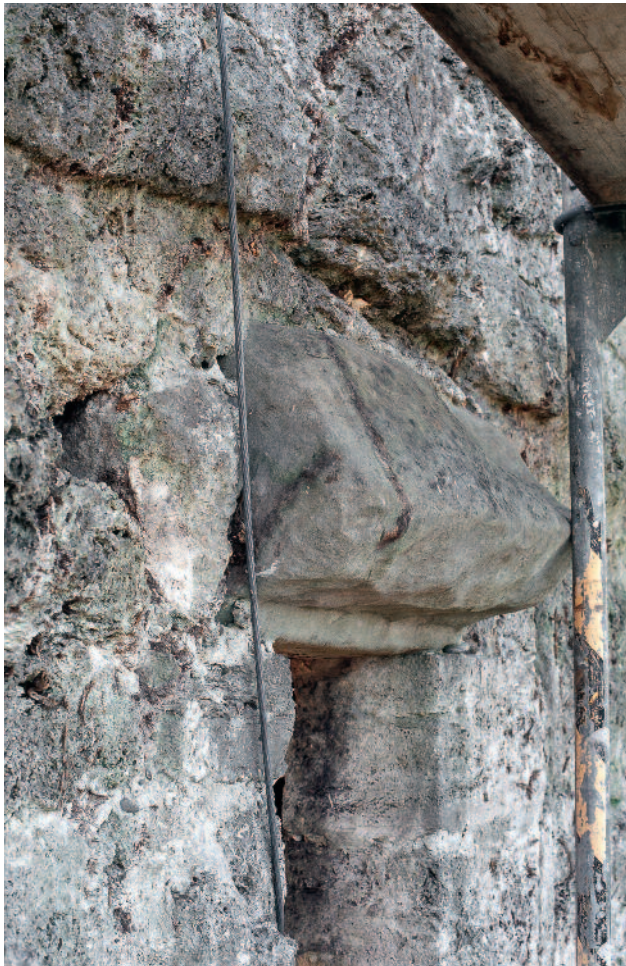
Abb. 176 Kastelen LU, Nordfassade, 3. Obergeschoss. Abortaustritt Pos. 1402. Teilweise roh belassener, keilförmig vorkragender Sandsteinsturz. Oberhalb des Sturzes die in die Tuffquader geschlagene Ansatzstelle für das Erkerdach. Blick von Nordosten.
