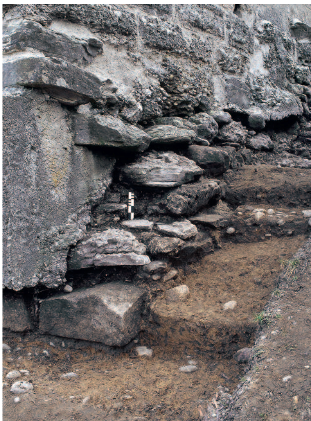
Abb. 77 Kastelen LU. Grabungsfläche an der Westseite ausserhalb des Wohnturms (2001). Freigelegtes Turmfundament mit keilförmiger Betonplombe in der Nordwestecke (links). Über dem Fundament die aus zwei Quaderlagen bestehende vorspringende Sockelzone, rechts im Hintergrund der Ansatz des Treppenfundamentes Pos. 1020. Blick von Nordwesten.
