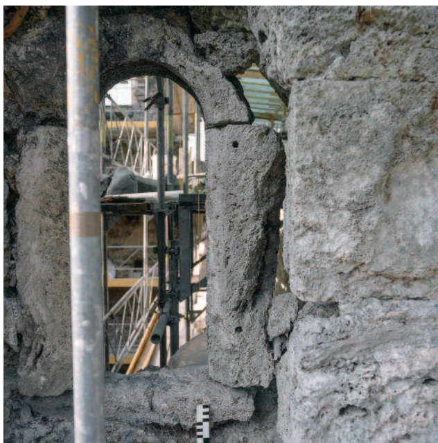
Abb. 132 Kastelen LU. Südfassade, 3. Obergeschoss. Rundbogenfenster Pos. 3401. Der östliche Fensterposten trägt an der Aussenseite Dübellöcher zur Anbringung eines Fensterladens. Blick von Süden.
