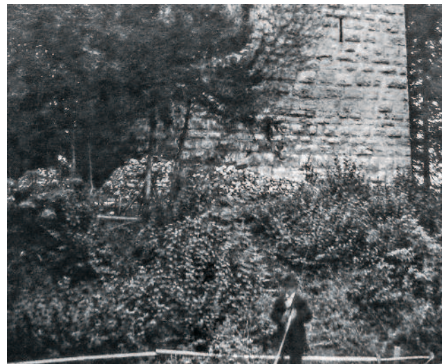
Abb. 265 Kastelen LU. Landvermesser bei der Arbeit, um 1921. Im Hintergrund deutlich zu erkennen ist das am Fuss des Wohnturms aufgehäufte Aushubmaterial aus dem Sodbrunnen (Ausschnitt, Blick von Südosten).
