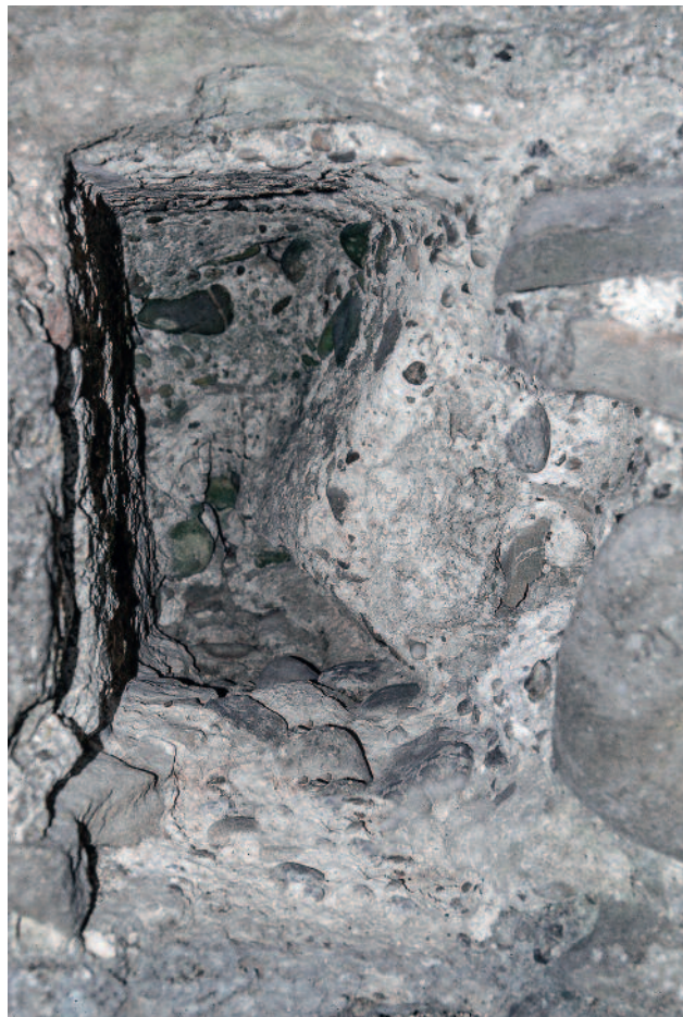
Abb. 146 Kastelen LU. Innenseite Nord. Bodenbalkenlage zum 1. Obergeschoss. Das durch Balkennegativ Pos. 1109 überlieferte Balkenende weist einen unregelmässigen Querschnitt auf. Blick gegen Norden.
