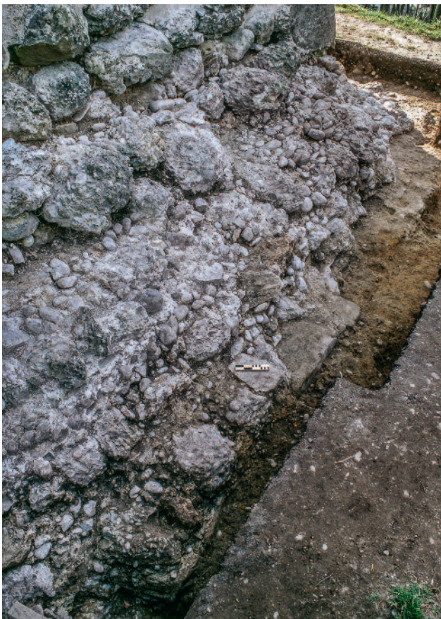
Abb. 154 Kastelen LU. Freigelegte Reste des Treppenfundamentes Pos. 1020 vor der Westseite des Wohnturms (Grabungsfläche 2001). Blick von Nordwesten.
