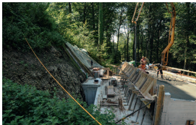
Abb. 20 Kastelen LU. Arbeiten zum Bau des Unterstandes an der Nordseite des Burghügels, 2009. In der linken Bildhälfte der freiliegende Fels, im Hintergrund unter der Plastikplane ein archäologischer Aufschluss. Blick gegen Westen.
