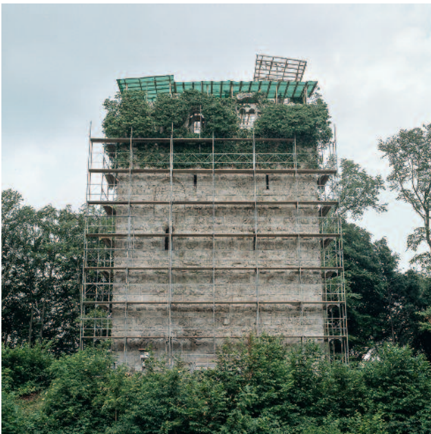
Abb. 14 Kastelen LU. Ostfassade beim Entfernen des Efeus, 1999, mit Baugerüst und Schutzdach. Blick von Osten.
