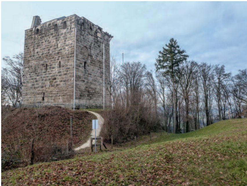
Abb. 275 Kastelen LU. Der Burggraben trennt den Wohnturm vom östlich gelegenen Plateau. Er ist in seiner heutigen Form stark durch Auffüllungen und Erosion geprägt. Blick von Südosten.
