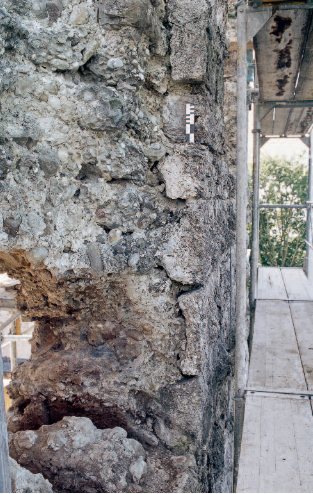
Abb. 83 Kastelen LU. Westfassade, 4. Obergeschoss. Die Mauer­schale besteht hier aus lediglich noch plattigen Buckelquadern, welche den lagig aufgeführten Mauer­kern aus Nagelfluhbrocken verkleiden. Blick von Norden.
