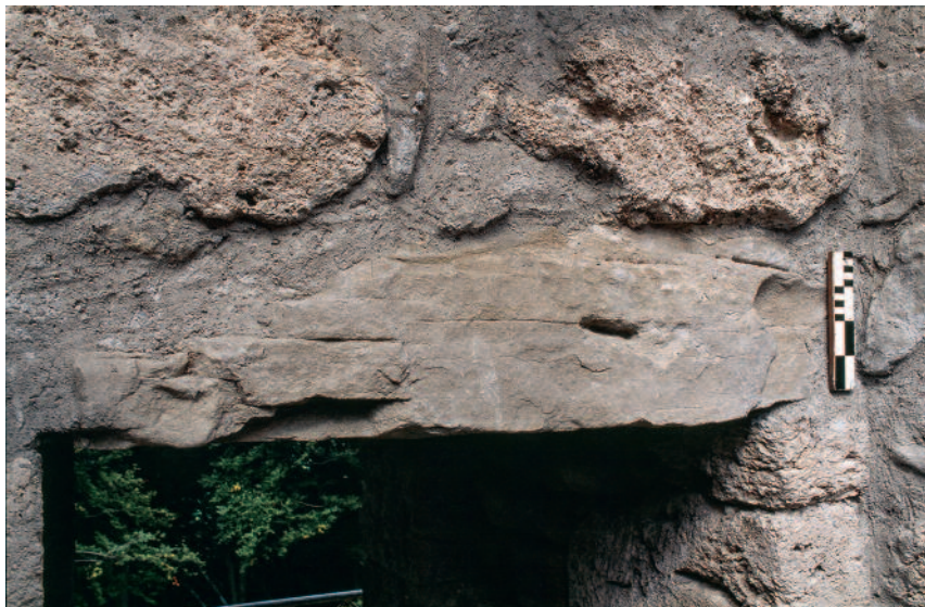
Abb. 202 Kastelen LU. Innenseite Nord, 2. Obergeschoss. Türsturz des Abortaustritts Pos. 1304. Am Sturz eine im Steinbruch vorbereitete Keiltasche zur Herstellung von Sandsteinplatten. Blick gegen Nordosten.
