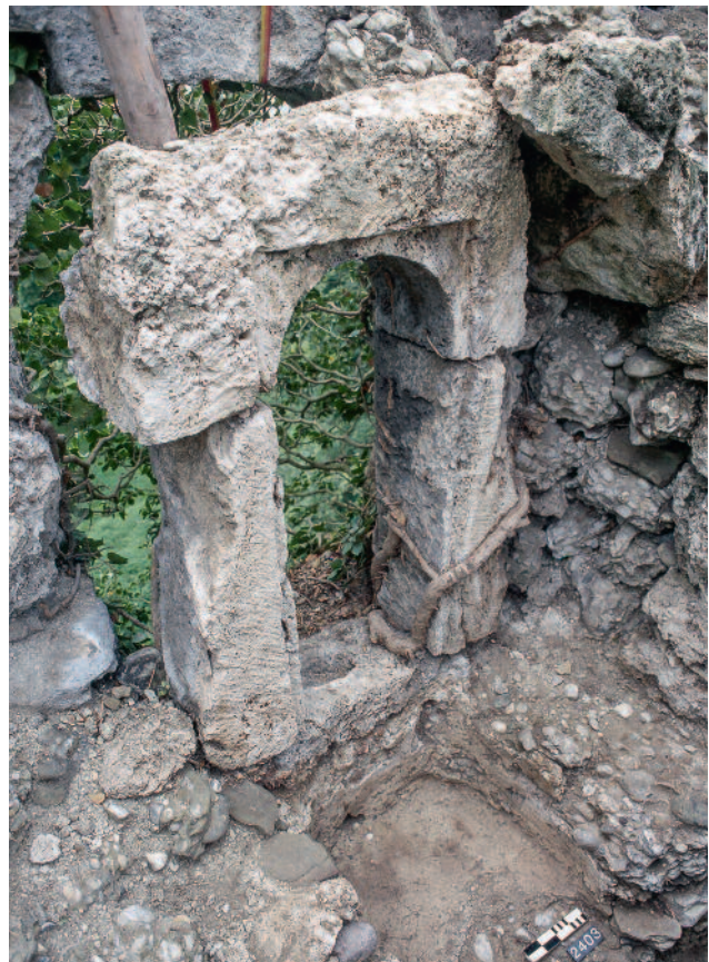
Abb. 113 Kastelen LU. Innenseite Ost, 3. Obergeschoss. Fenstergewände und Reste der Sitznische des Fensters Pos. 2403. Blick gegen Südosten.
