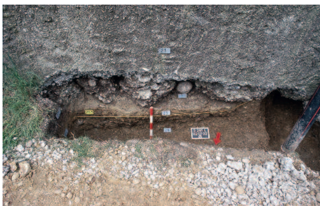
Abb. 78 Kastelen LU. Nordfassade, Unterkante des Fundaments. Die in das Moränensediment eingetiefte Fundamentgrube weist an ihrer Sohle eine flächige Mörtelgusssschicht auf. Blick von Norden.
