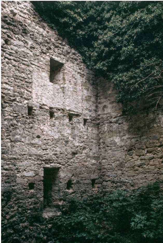
Abb. 102 Kastelen LU. Innenseite, Nordostecke im Erd- und im 1. Obergeschoss, Zustand vor der Restaurierung (1992). Auf Fensterhöhe im Erdgeschoss sind die Balkenlager eines Zwischengeschosses zu erkennen. Die Osthälfte des 1. Obergeschosses trägt den sekundären Verputz Pos. 5201, Reste desselben Putzes finden sich auch im Zwischengeschoss (Pos. 5103). Blick gegen Nordosten.
