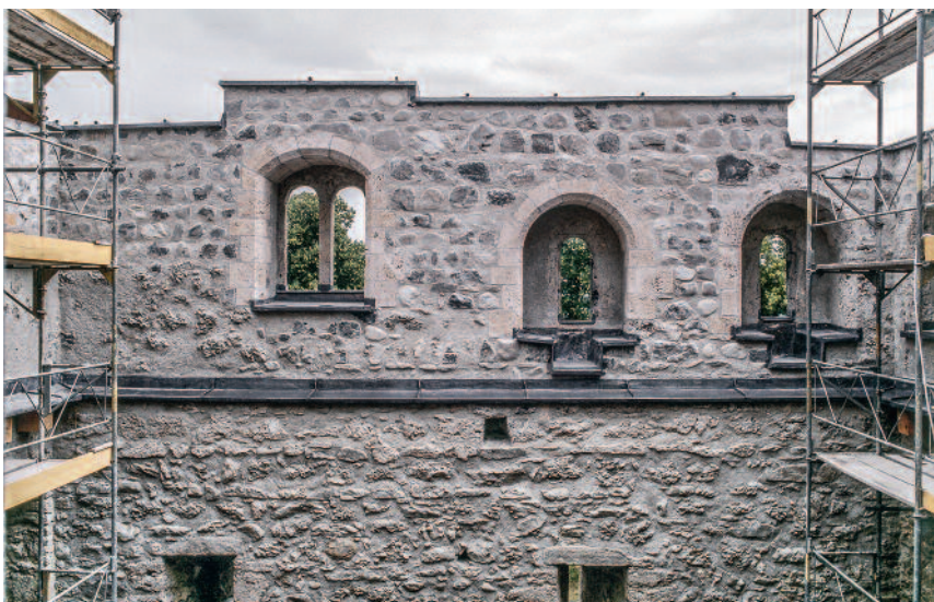
Abb. 333 Kastelen LU. Innenseite Ost, 3. Obergeschoss mit rekonstruierten Fensterwänden aus frisch zugeschnittenen Tuffsteinblöcken. Gut zu erkennen ist der Strukturunterschied zwischen den original vermauerten rauen Nagelfluhbrocken und den Bollensteinen im neu aufgeführten Mauermantel. Die Mauerkrone, die Fensterbänke und der darunter liegende Mauerabsatz sind bereits mit Bleifolie geschützt.
