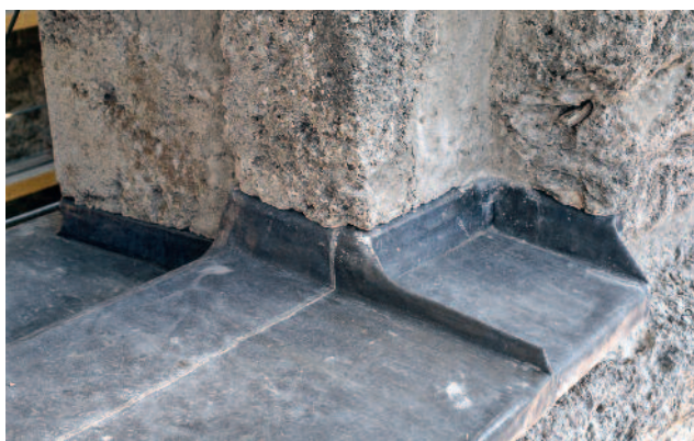
Abb. 342 Kastelen LU. Südfassade, 3. Obergeschoss. Mit Bleifolie sorgfältig abgedeckte Fensterbank. Blick von Südosten.
