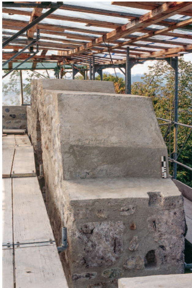
Abb. 340 Kastelen LU. Die fertig sanierte, nach aussen geneigte Mauerkrone der nördlichen Turmseite vor dem Verlegen einer Schicht Dachpappe und dem Aufbringen der Abdeckung aus Bleifolie. Blick von Osten.
