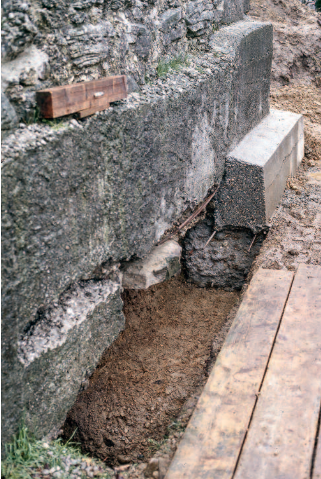
Abb. 334 Kastelen LU. Äusserer Mauerfuss bei der Nordwestecke. Die Ecke ist zur Stabilisierung des Fundamentes frisch mit Beton unterfangen. Im Vordergrund der teilweise ausgehobene Tunnel Pos. 0087 unter dem nördlichen Turmfundament. Blick von Nordosten.
