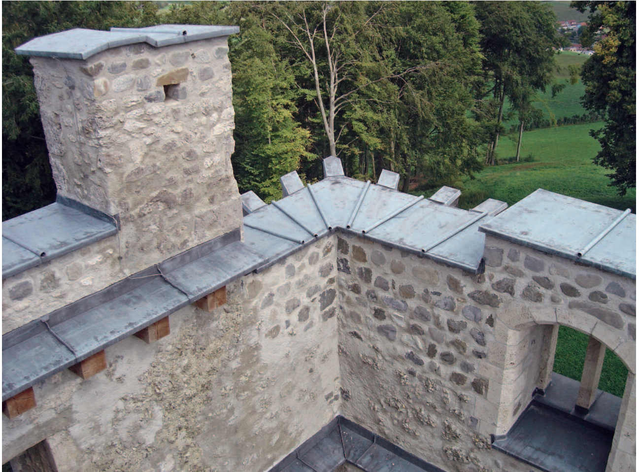
Abb. 346 Kastelen LU. Sanierte Mauerkrone an der nordöstlichen Ecke der Ruine. Das Steinmaterial der neu aufgemauerten inneren Mauerschale setzt sich vom originalen Mauerwerk ab, in die Balkenlöcher sind Hölzer eingesetzt. Abdeckung der Krone mit Bleifolie.
