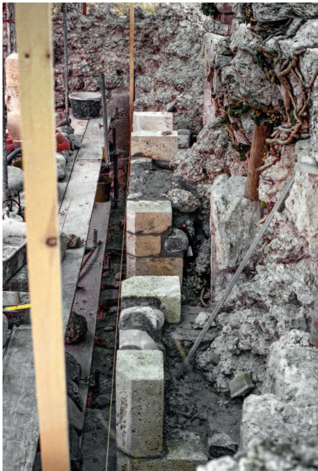
Abb. 337 Kastelen LU. Innenseite Ost, 3. Obergeschoss. Wiederaufbau der Fensternischen und des inneren Mauermantels. Blick von Süden.
