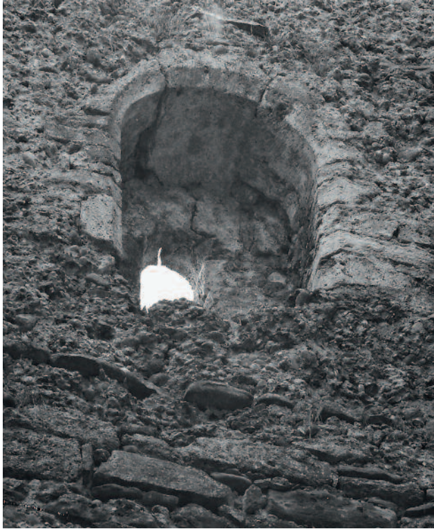
Abb. 105 Kastelen LU. Innenseite West, 3. Obergeschoss. Rundbogenfenster Pos. 4402. Die gefasteten Kanten der Fensternische sind aus Tuffsteinplatten von geringstmöglicher Stärke hergestellt. Historische Aufnahme aus den 1960er-Jahren (Hans Marti). Blick gegen Westen.
