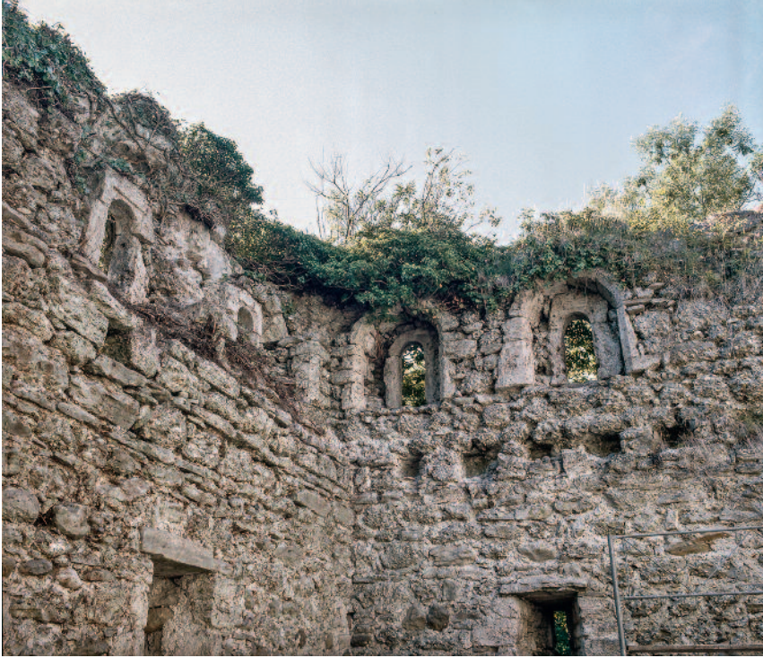
Abb. 227 Kastelen LU. Innenansicht der Südostecke. Die beim Entfernen des Efeus 1998 wieder zum Vorschein gekommene reiche Befensterung mit vier Rundbogenfenstern im 3. Obergeschoss.
