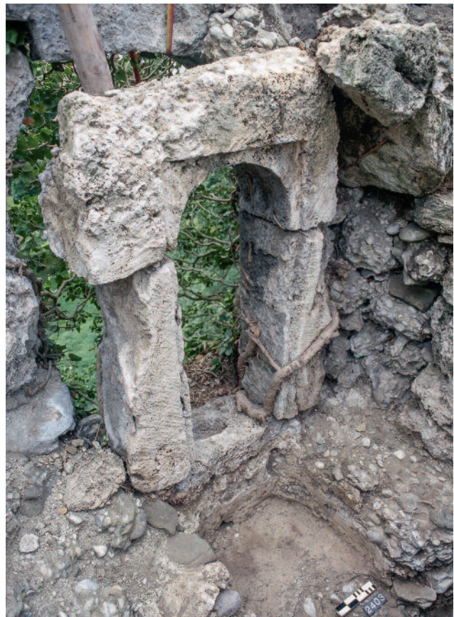
Abb. 113 Kastelen LU. Innenseite Ost, 3. Obergeschoss. Fenstergewände und Reste der Sitznische des Fensters Pos. 2403. Blick gegen Südosten.
