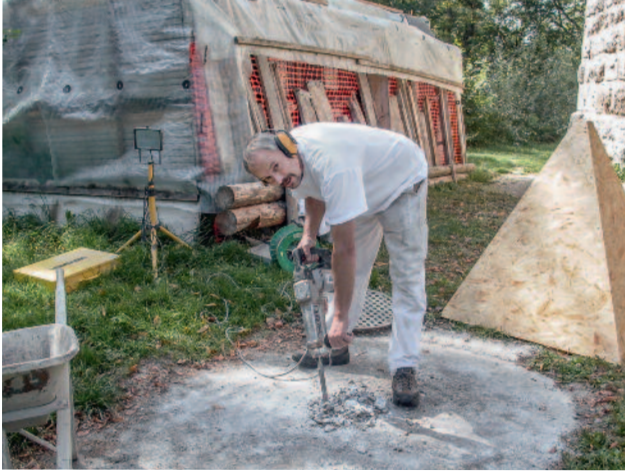
Abb. 253 Kastelen LU. Josef Wermelinger beim Öffnen der Betonabdeckung über dem Brunnenschacht, 17. September 2003.
