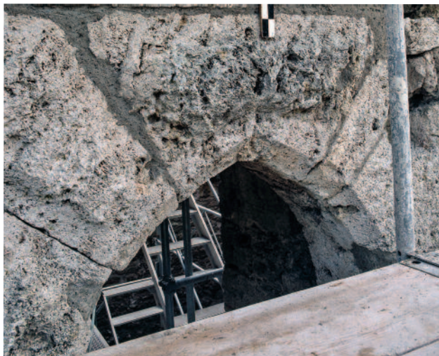
Abb. 166 Kastelen LU. Westfassade, 1. Obergeschoss. Hocheingang Pos. 4202. Die Mörtelreste an der Bogenspitze des Hocheingangs stammen von der Zumauerung der Türöffnung nach der Aufgabe des Wohnturms 1743. Blick von Nordwesten.
