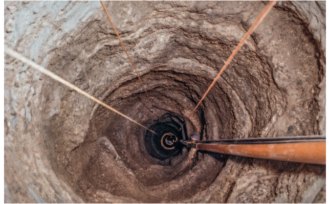
Abb. 258 Kastelen LU. Durch die Nagelfluh geschlagener oberster Abschnitt des Sodbrunnens, im Bereich unmittelbar unterhalb des gemauerten Brunnenkranzes.
