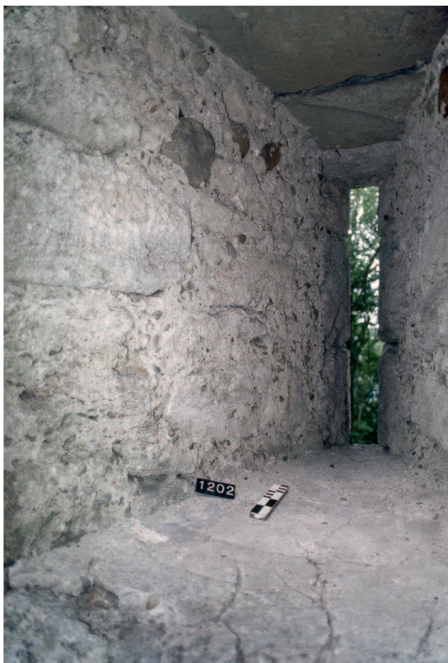
Abb. 94 Kastelen LU. Innenseite Nord, Lichtscharte Pos. 1202 im 1. Obergeschoss. Der in der späteren Nutzungszeit des Wohnturms erneuerte Mörtelstrich auf der Fensterbank schliesst nahtlos an die Mauerfläche der Leibung an. Der bauzeitliche Pietra-rasa-Verputz dieser Fläche ist weitgehend verwittert. Blick gegen Nordwesten.
