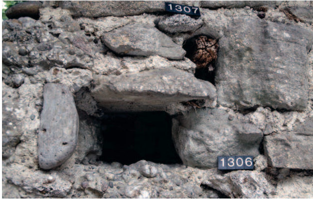
Abb. 206 Kastelen LU. Innenseite Nord, 2. Obergeschoss. Oben rechts der Stummel des Gerüsthebels Pos. 1307, darunter das erst nachträglich entstandene Balkenloch Pos. 1306. Blick gegen Nordosten.
