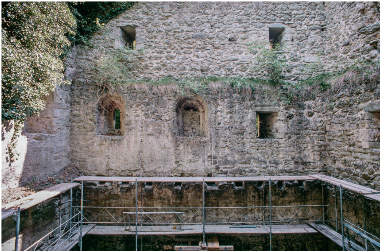
Abb. 101 Kastelen LU. Innenseite Süd, 1. und 2. Obergeschoss. Gut erkennbar die grossflächigen sekundären Verputzreste (Pos. 5201) mit Abdrücken stehender Hölzer im Bereich der zwei Kapellenfenster Pos. 3201 und 3202. Blick gegen Süden.
