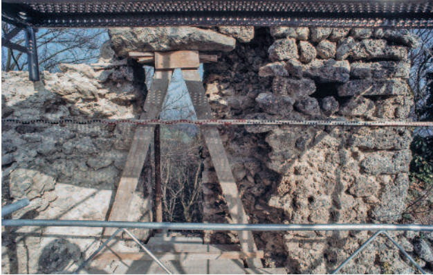
Abb. 183 Kastelen LU. Innenseite Nord, 4. Obergeschoss. Austritt Pos. 1501 auf den Wehrker an der Nordwestecke. Zustand 1998 mit Not- sicherung des kaum mehr eingebundenen Sturzes. Blick gegen Norden.
