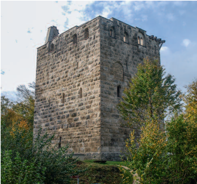
Abb. 73 Kastelen LU. Die Ruine des Wohnturms nach der Restaurierung, 2014. Blick von Südosten auf die Schauseiten des Bauwerks.
