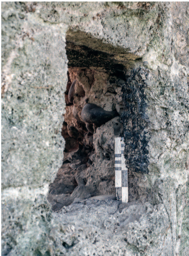
Abb. 139 Kastelen LU. Nordfassade, 3. Obergeschoss. Blick auf die Mündung der Rauchöffnung Pos. 1401. Beide an der Ruine vorhandenen Rauchöffnungen weisen deutliche Russspuren auf. Blick von Nordosten.
