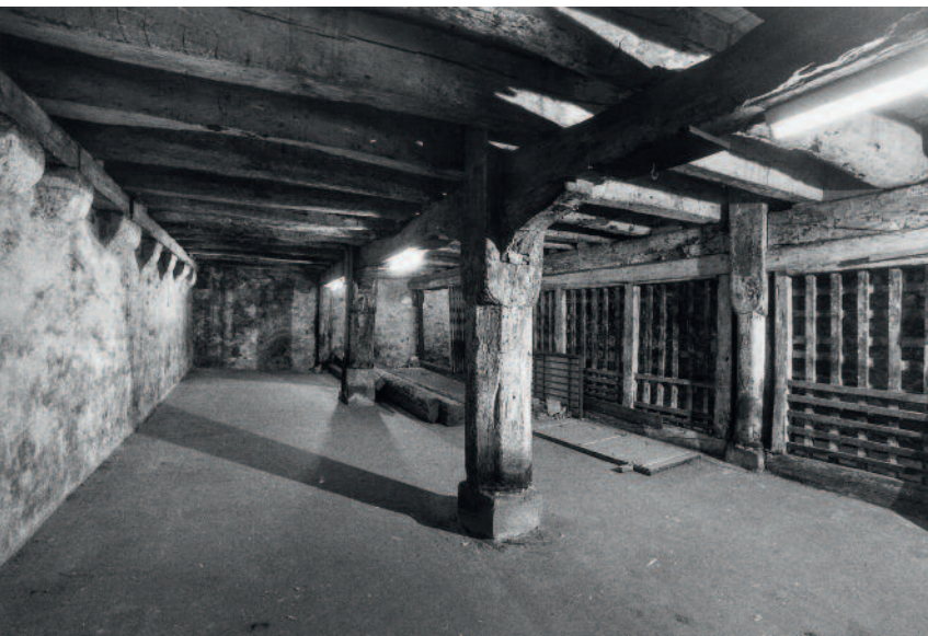
Abb. 219 Basel BS, Peterskirchplatz 1, «Zum Grossen Keller». Hölzerne Tragstruktur aus der zweiten Hälfte des 13. Jh.
