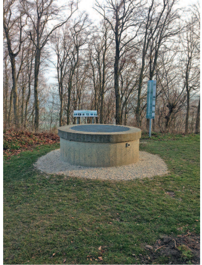
Abb. 254 Kastelen LU. Der Sodbrunnen nach der Restaurierung durch den Verein Burgruine Kastelen in seinem heutigen Zustand (Aufnahme 2016). Blick von Norden.
