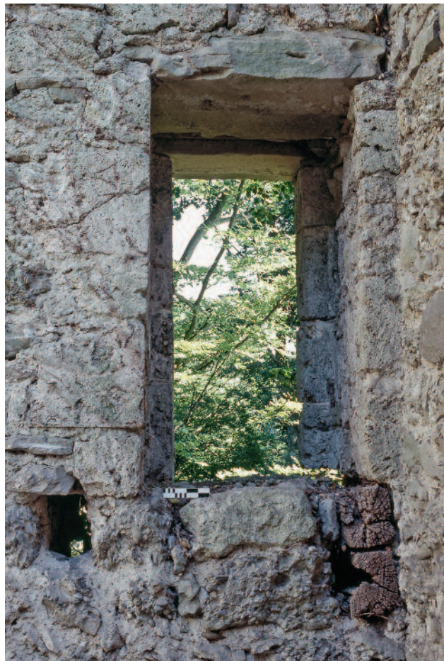
Abb. 170 Kastelen LU. Innenseite Nord, 2. Obergeschoss. Abortaustritt Pos. 1304. Unterhalb der Schwelle sind die Balkenenden der Erkerkonsolen sichtbar (Pos. 1322, 1323). Blick gegen Norden.
