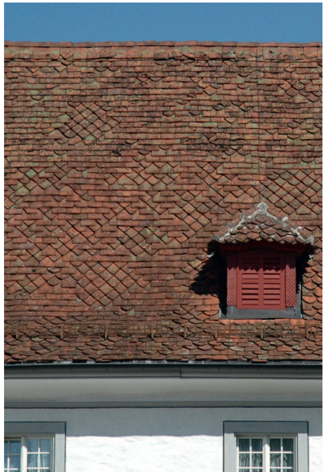
Abb. 190 Kloster St. Urban, Pfaffnau LU. Ziegel des 13./14. Jh. auf dem Dach des Frauenhauses. Die Ziegeldeckung kann in dieser Form frühestens um 1784 erfolgt sein. Zustand 2004, nach der Restaurierung von 1992.
