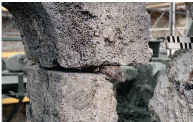
Abb. 133 Kastelen LU. Ostfassade, 3. Obergeschoss. Hölzerner Dübel beim Gewände des Rundbogenfensters Pos. 2403. Das Holzstück steckte ursprünglich in einer heute fast vollständig weggebrochenen Vertiefung. An seinem linken Rand sind die Reste der eisernen Angel für einen Fensterladen zu erkennen. Blick von Südosten.
