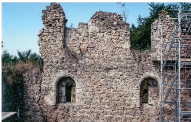
Abb. 86 Kastelen LU. Innenseite West. Fast ausschliesslich aus Nagelfluhbrocken aufgeführter innerer Mauer­mantel auf der Höhe des 3. und 4. Obergeschosses. Blick gegen Westen.
