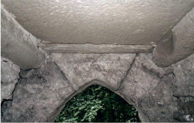
Abb. 162 Kastelen LU. Westseite, 1. Obergeschoss. Hocheingang Pos. 4202. Sorgfältig aus sandsteinernen Werkstücken gefertigte Decke im Durchgang des Hocheingangs. Die Steinplatten des Sturzes sind beidseitig auf Kragsteinen aufgelegt. Blick gegen Westen.
