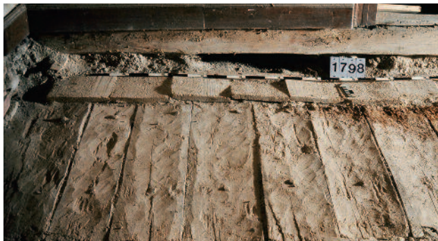
Abb. 214 Diessenhofen TG, Unterhof. Originale Bodenkonstruktion der Zeit um 1278. Die nur grob bearbeiteten Bohlen wurden mit Holznägeln an der Balkenlage befestigt und mit einem Mörtelestrich überdeckt.
