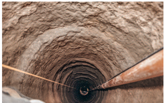
Abb. 260 Kastelen LU. Untere Hälfte des Brunnenschachts mit den in härteren Felspartien stehengelassenen Wülsten.
