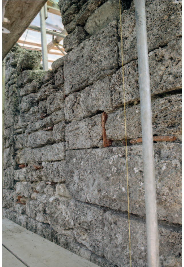
Abb. 89 Kastelen LU. Westfassade, 4. Obergeschoss. Ziegeleinschüsse im bauzeitlichen Mauerwerk des 13. Jh. (Fugen im Vordergrund) sowie in der späteren Vermauerung der Rundbogenöffnung Pos. 4501 (links). Blick von Südwesten.
