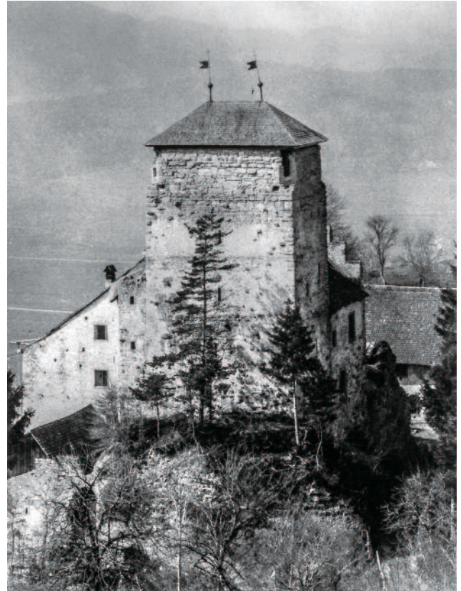
Abb. 269 Wikon LU, Schloss. Zustand der Burg vor 1890. An den Turmecken sind die Spuren der durch eine rundbogige Tür zu betretenden Wehrerker erkennbar. Blick von Osten.
