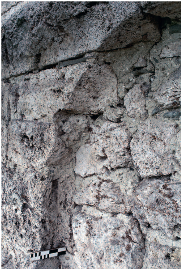
Abb. 142 Kastelen LU. Ostfassade, 2. Obergeschoss. Segment der Mauernische Pos. 2311. Die einzelnen Elemente des Bogens sind aus den Normquadern gehauen, Fehlstellen wurden mit Mörtel ausgebessert. Blick von Nordosten.
