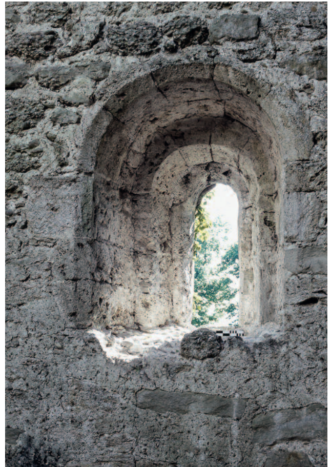
Abb. 120 Kastelen LU. Innenseite Ost, 1. Obergeschoss. Rundbogenfenster Pos. 2202 (Kapelle) mit sorgfältig gearbeiteter, mehrfach gestufter Fenster niche. Blick gegen Osten.
