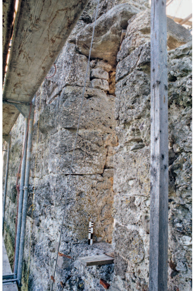
Abb. 185 Kastelen LU. Nordfassade, 4. Obergeschoss. Austritt Pos. 1501 auf den Wehrker an der Nordwestecke. Zustand vor der Restaurierung. Blick von Nordwesten.
