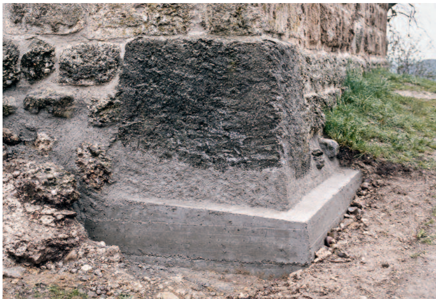
Abb. 300 Kastelen LU. Durch einen Zementflick der Zeit nach 1912 gesicherte Südwestecke des Wohnturms mit ergänzter Unterfangung. Zustand unmittelbar nach der Sanierung 2001.
