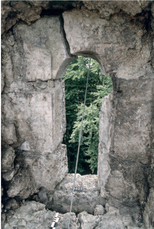
Abb. 131 Kastelen LU. Innenseite West, 3. Obergeschoss. Rundbogenfenster Pos. 4401 mit verwitterten Spuren des Fensterfalzes. An der rechten Seite sind zwei Dübellöcher für einen Fensterflügel oder -laden eingelassen. Blick gegen Westen.
