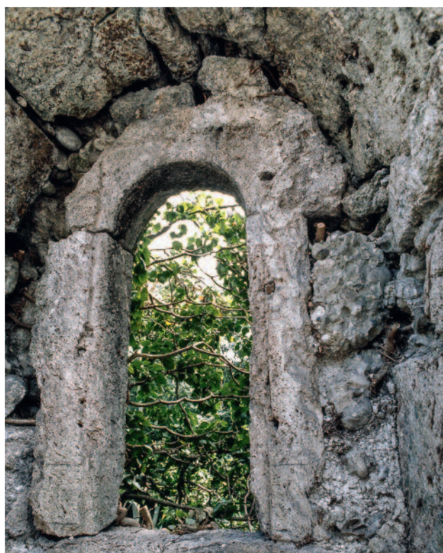
Abb. 130 Kastelen LU. Innenseite Süd, 3. Obergeschoss. Rundbogenfenster Pos. 3401 mit sorgfältig gefertigtem Fensterfalz. Am rechten Fensterpfosten sind Dübellöcher zur Verankerung des Fensterflügels angebracht.
