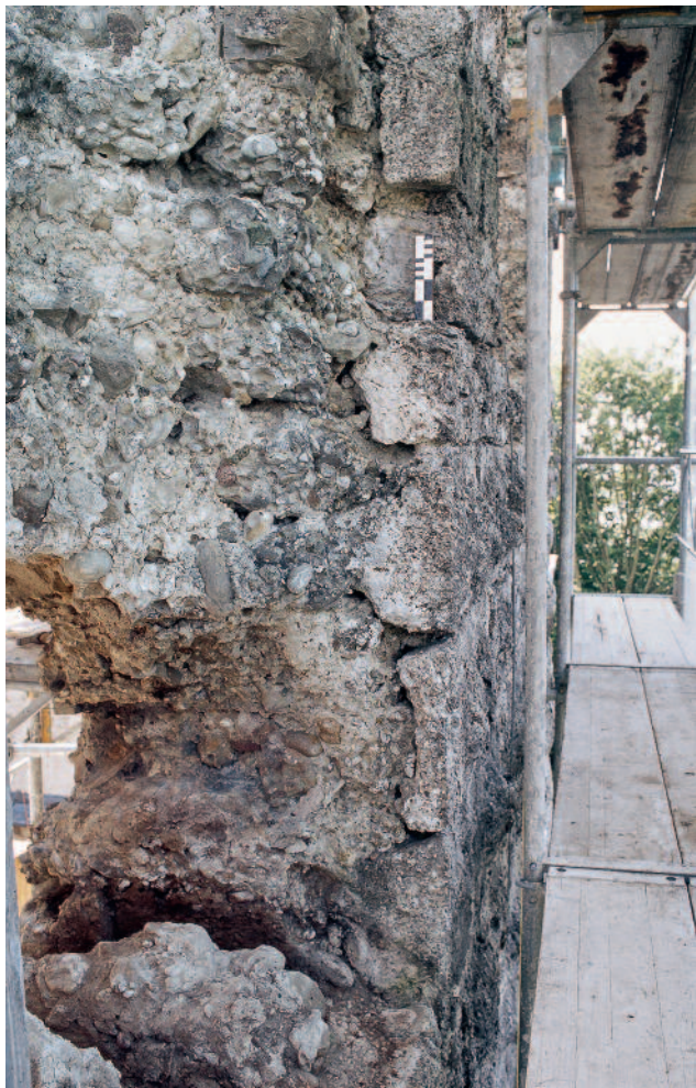
Abb. 83 Kastelen LU. Westfassade, 4. Obergeschoss. Die Mauer­schale besteht hier aus lediglich noch plattigen Buckelquadern, welche den lagig aufgeführten Mauer­kern aus Nagelfluhbrocken verkleiden. Blick von Norden.
