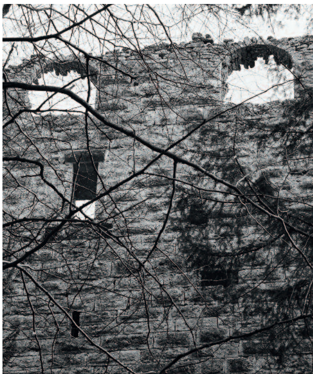
Abb. 121 Kastelen LU. Nordfassade, 2. bis 4. Obergeschoss. Aufnahme aus den 1960er-Jahren (Hans Marti). Die beiden Öffnungen des 4. Obergeschosses besitzen beide noch Reste des Bogengewölbes. Blick von Norden.
