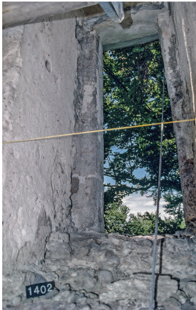
Abb. 179 Kastelen LU. Innenseite Nord, 3. Obergeschoss. Abortaustritt Pos. 1402. Durchgang zur Erkertür mit gut erhaltenem Verputz Pos. 1427. Blick gegen Norden.
