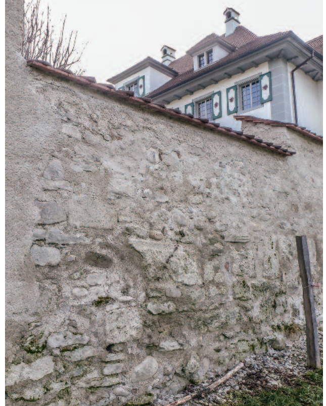
Abb. 299 Alberswil LU, Schloss Kastelen. In der Gartenmauer des Schlosses sind zahlreiche Tuffquader verbaut, stellenweise lassen sich deutlich Fragmente von Buckelquadern erkennen. Gartenmauer an der Nordseite des Schlosses, Blick von Nordosten.
