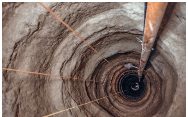
Abb. 259 Kastelen LU. Der Brunnenschacht ab einer Tiefe von 20 m. Blick auf die engste Stelle und die darunter gleichmässiger werdende Wandung.
