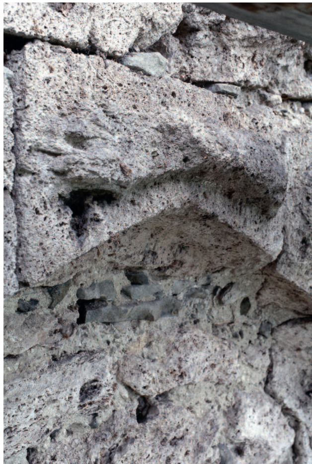
Abb. 143 Kastelen LU. Ostfassade, 2. Obergeschoss. Mauernische Pos. 2311. Aus einem Buckelquader gehauener Schlussstein. Blick von Südosten.
