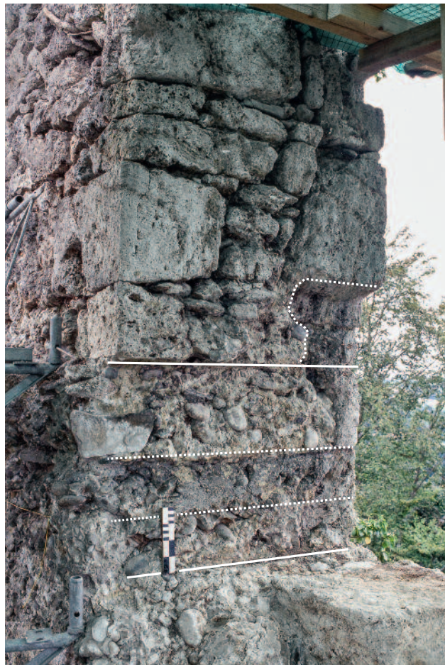
Abb. 180 Kastelen LU. Innenseite Nord, 4. Obergeschoss. Erkeraustritt Pos. 1509. Blick von innen an die westliche Leibung (obere Bildhälfte). Die äussere Kante der Türöffnung ist durch einen jüngeren Eingriff gestört (Pos. 5409), darunter folgt der Ausbruch der einstigen Erkerkonsole (Pos. 1419, mit Abdrücken dreier aufeinanderliegender Balken). Blick gegen Nordwesten.
