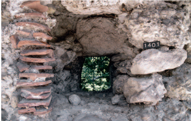
Abb. 138 Kastelen LU. Innenseite Nord, 3. Obergeschoss. Nachträglich durch die Mauer gebrochene Rauchöffnung Pos. 1401. Die linke Kante der Öffnung besteht aus einem vermörtelten Stapel fragmentierter Dachziegel. Blick gegen Norden.
