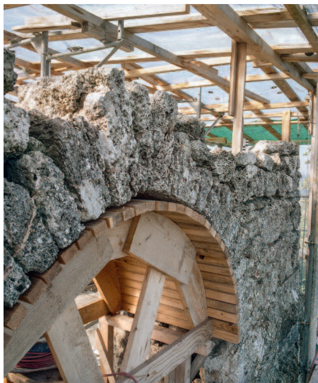
Abb. 122 Kastelen LU. Nordfassade, 4. Obergeschoss. Rundbogenöffnung Pos. 1502. Die Stirnseiten des Bogens sind aus sorgfältig zugerichteten Tuffsteinstücken gefügt. Blick von Nordosten.
