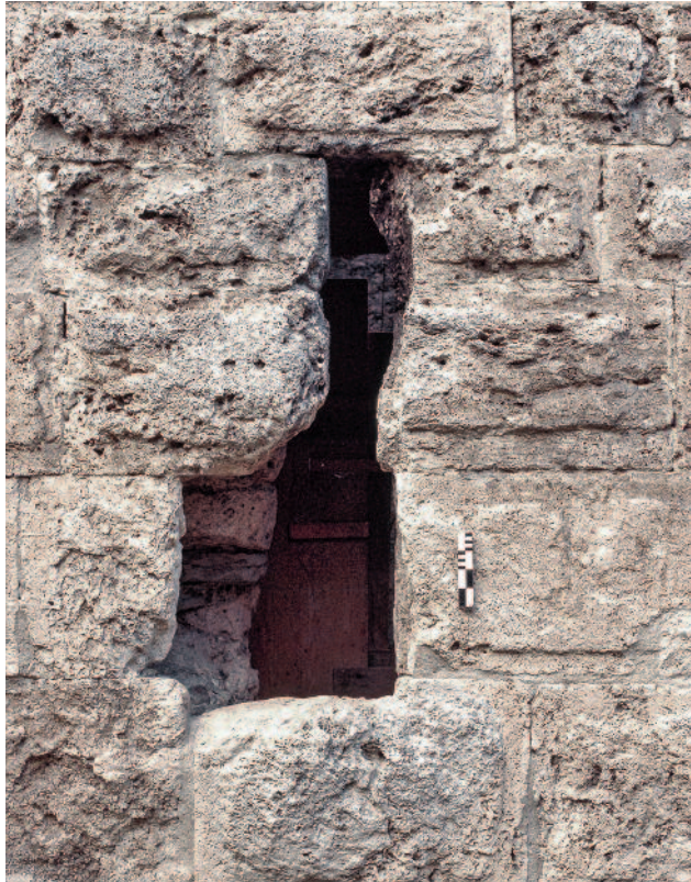
Abb. 297 Kastelen LU. Nachträglich zu einem Durchschlupf erweiterte Lichtscharte Pos. 3101 an der Südseite des Erdgeschosses. Blick von Süden.
