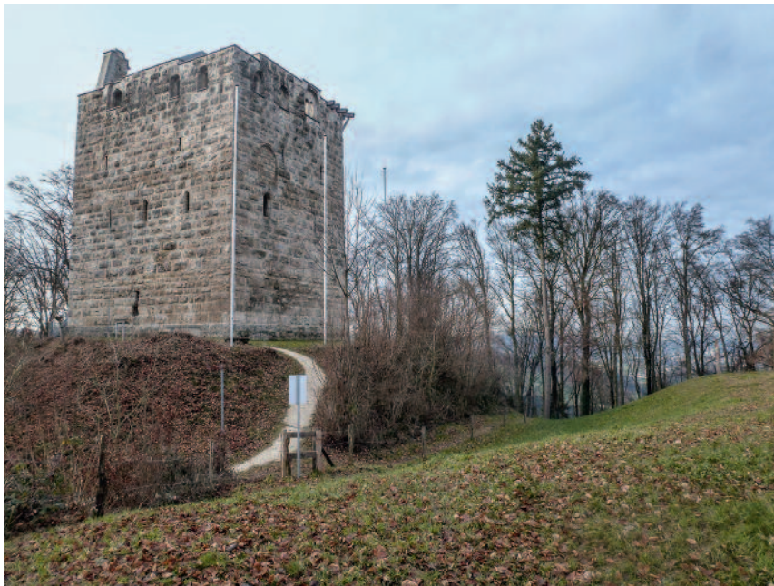
Abb. 275 Kastelen LU. Der Burggraben trennt den Wohnturm vom östlich gelegenen Plateau. Er ist in seiner heutigen Form stark durch Auffüllungen und Erosion geprägt. Blick von Südosten.
