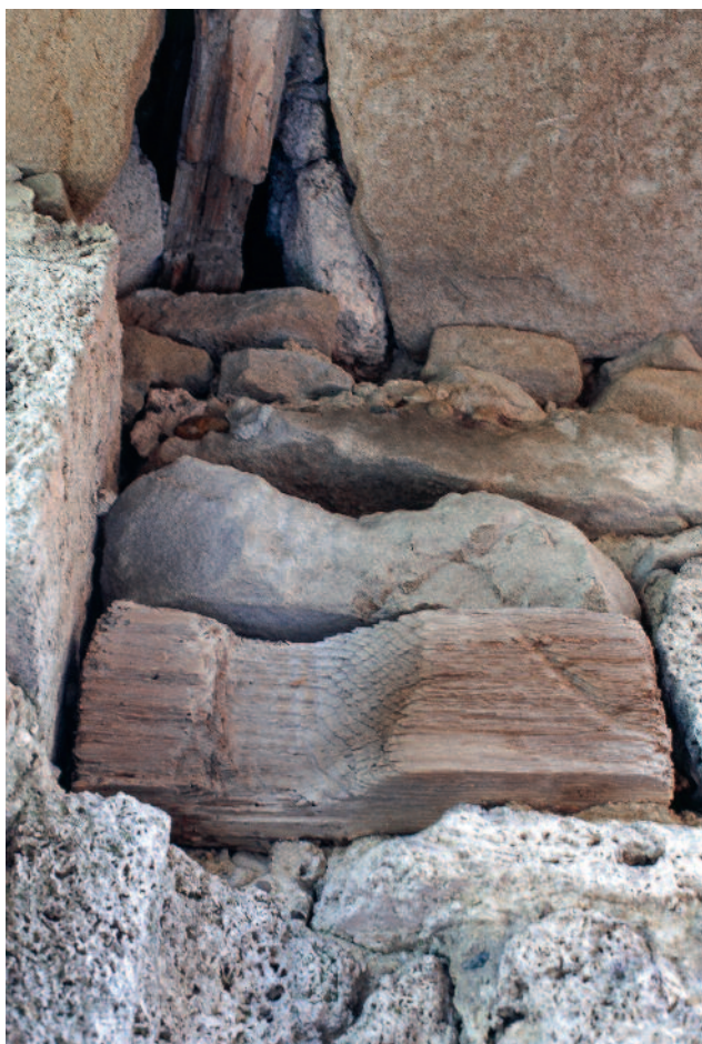
Abb. 174 Kastelen LU. Nordseite, 2. Obergeschoss. Abortaustritt Pos. 1304. Im oberen Teil der östlichen Türleibung eingemauertes Holz- und darüber liegendes Sandsteinstück mit herausgeschlagenen Aussparungen. Untersicht/Blick gegen Osten.
