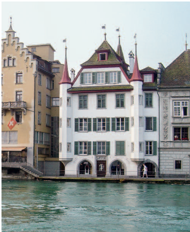
Abb. 286 Luzern, Reusssteg 6, sogenanntes Pfyffersches Stipendihaus, errichtet um 1580.
