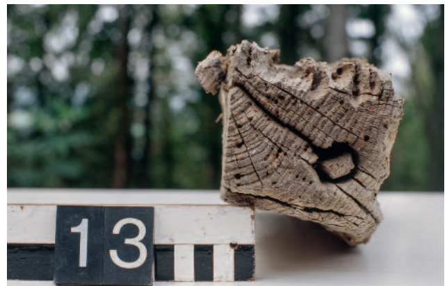
Abb. 178 Kastelen LU, Nordseite, 3. Obergeschoss. Abortaustritt Pos. 1402. Aus der westlichen Leibung geborgener Holzdübel für einen Türkloben, mit eingesetztem Holznagel.
