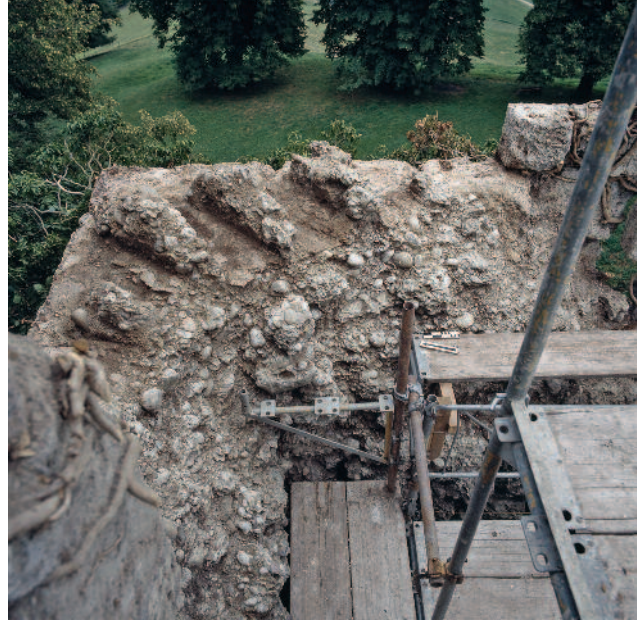
Abb. 188 Kastelen LU. Nordostecke, 4. Obergeschoss. Mauerkrone mit Resten der Balkennegative der fächerförmig angeordneten Erkerkonsolen. Blick gegen Osten.
