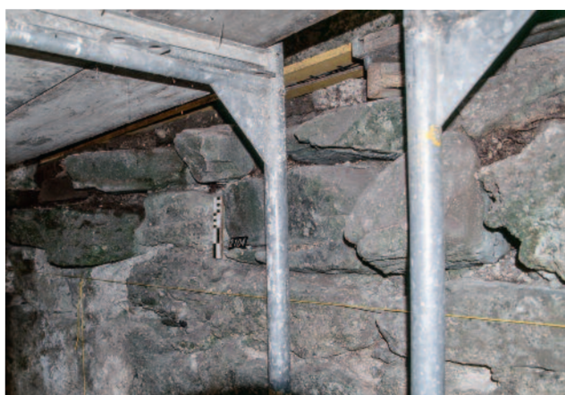
Abb. 148 Kastelen LU. Innenseite Ost. Übergang vom Erd- zum 1. Obergeschoss im Bereich des Mauerrücksprungs des oberen Geschosses. Auf dem Absatz des Mauerrücksprungs haben sich Fragmente eines Mörtelbodens erhalten (Pos. 2205; hell, oben), darunter befinden sich Reste einer aus zwei Steinlagen bestehenden Konsole (Pos. 2104). Blick gegen Nordosten.
