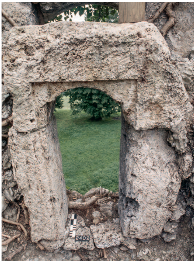
Abb. 110 Kastelen LU. Innenseite Ost, 3. Obergeschoss. Gewände des Sitznischenfensters Pos. 2402 mit rechteckiger Aussparung für den Fensterflügel (Fensterfalz). Blick gegen Osten.
