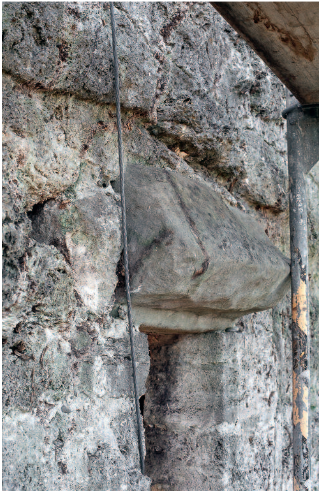
Abb. 176 Kastelen LU, Nordfassade, 3. Obergeschoss. Abortaustritt Pos. 1402. Teilweise roh belassener, keilförmig vorkragender Sandsteinsturzs. Oberhalb des Sturzes die in die Tuffquader geschlagene Ansatzstelle für das Erkerdach. Blick von Nordosten.
