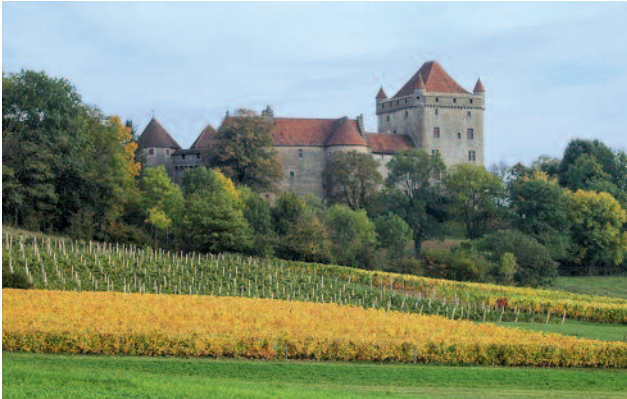
Abb. 23 Château le Pin (Dép. Jura, F). Eine der Burgen des Grafen Johann von Chalon, über der Salzstrasse nördlich von Lons-le-Saunier gelegen, erbaut um/vor 1253, also gleichzeitig mit der Kastelen. Die Gebäude neben dem Hauptturm sind jüngeren Datums.
