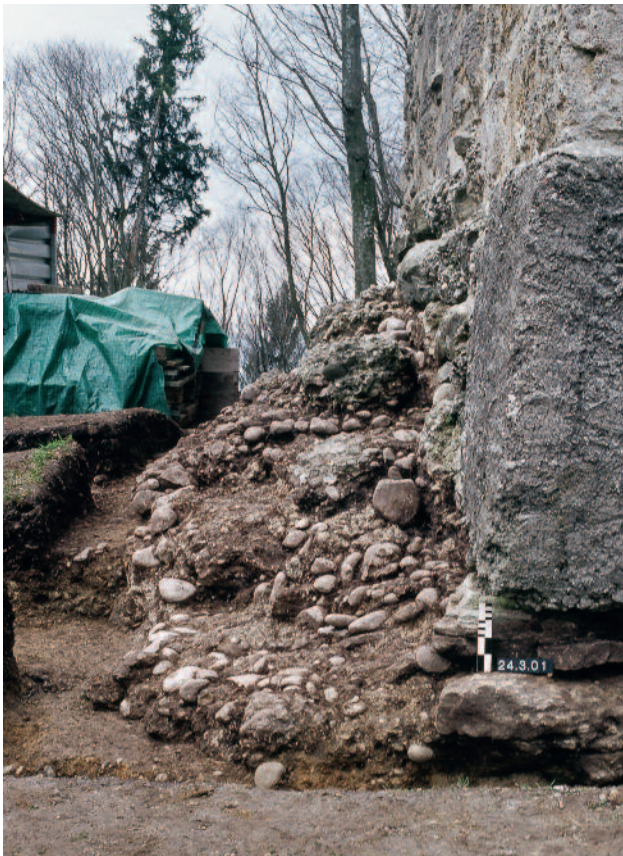
Abb. 17 Kastelen LU. Freilegungsarbeiten 2001. Fundament der Zugangstreppe (Pos. 1020) an der Westseite des Wohnturms. Blick gegen Norden.
