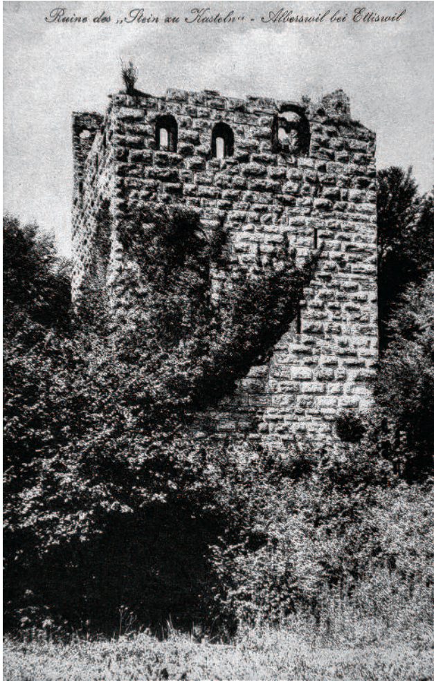
Abb. 6 Kastelen LU. Die Ruine um die Jahrhundertwende. Die südwestliche Turmecke ist noch in ihrer ursprünglichen Höhe erhalten. Blick von Südosten (Postkarte der Tuch- und Haushaltwarenhandlung Jos. Hinny, Ettiswil).
