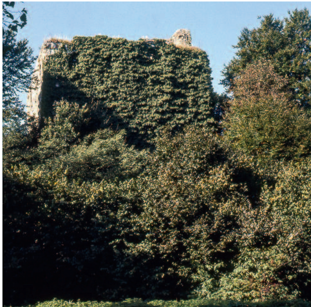
Abb. 12 Kastelen LU. Ab den 1970er-Jahren bis zur Restaurierung 1998 war die gesamte Ostfassade des Wohnturms von dichtem Efeu überwachsen (Foto Hans Marti, um 1980). Blick von Osten.
