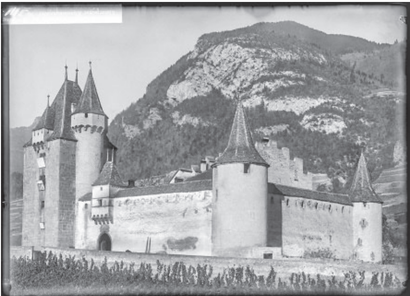
10 Aigle VD, Schloss. Resultat der bernischen Baumassnahmen zwischen 1497 und 1507 sind der aus der Flucht vortretende Turm, der Wehrker über dem Portal, die heutige Form des Wohnbaus und der Ausbau der Ringmauer mit den Rundtürmen. Gesamtaufnahme um 1900.
