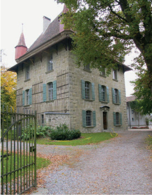
5 Bern BE, Schloss Holligen. Kurz nach 1500 durch Wilhelm von Diesbach neu aufgebauter Wohnturm. Dach und Erker aus der Bauzeit. Die romantisierenden Eckblossen sollen an die Ritterzeit erinnern. Die schützenden Klebdächer entstanden 1697, die (bereits dritte) Befensterung um 1765.
