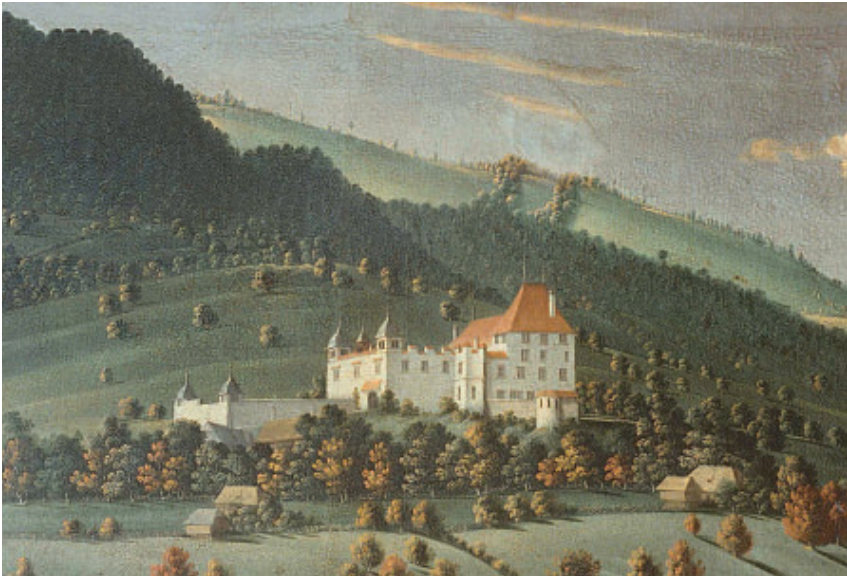
8 Toffen BE. Ansicht des Schlosses von Südosten, 1667. Vor dem mehrfach umgebauten und vergrößerten Wohnturm der von Mauern und schlanken Trakten eingefasste Empfangshof, polygonal vorspringend die ehemalige Schlosskapelle, entstanden unter Bartholomäus May, nach 1507. Auf den Umbau um 1634 gehen die Eckpavillons unter welschen Hauben zurück. Ausschnitt aus Ölvedute von Albrecht Kauw, Privatbesitz.
