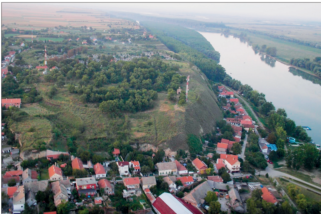
Abb. 58 Titel (SRB): Burgberg, Luftbild. Die einzige heute noch sichtbare Ruine ist eine verödete Kapelle aus dem Anfang des 19. Jhs. – (Foto G. Vučan).
