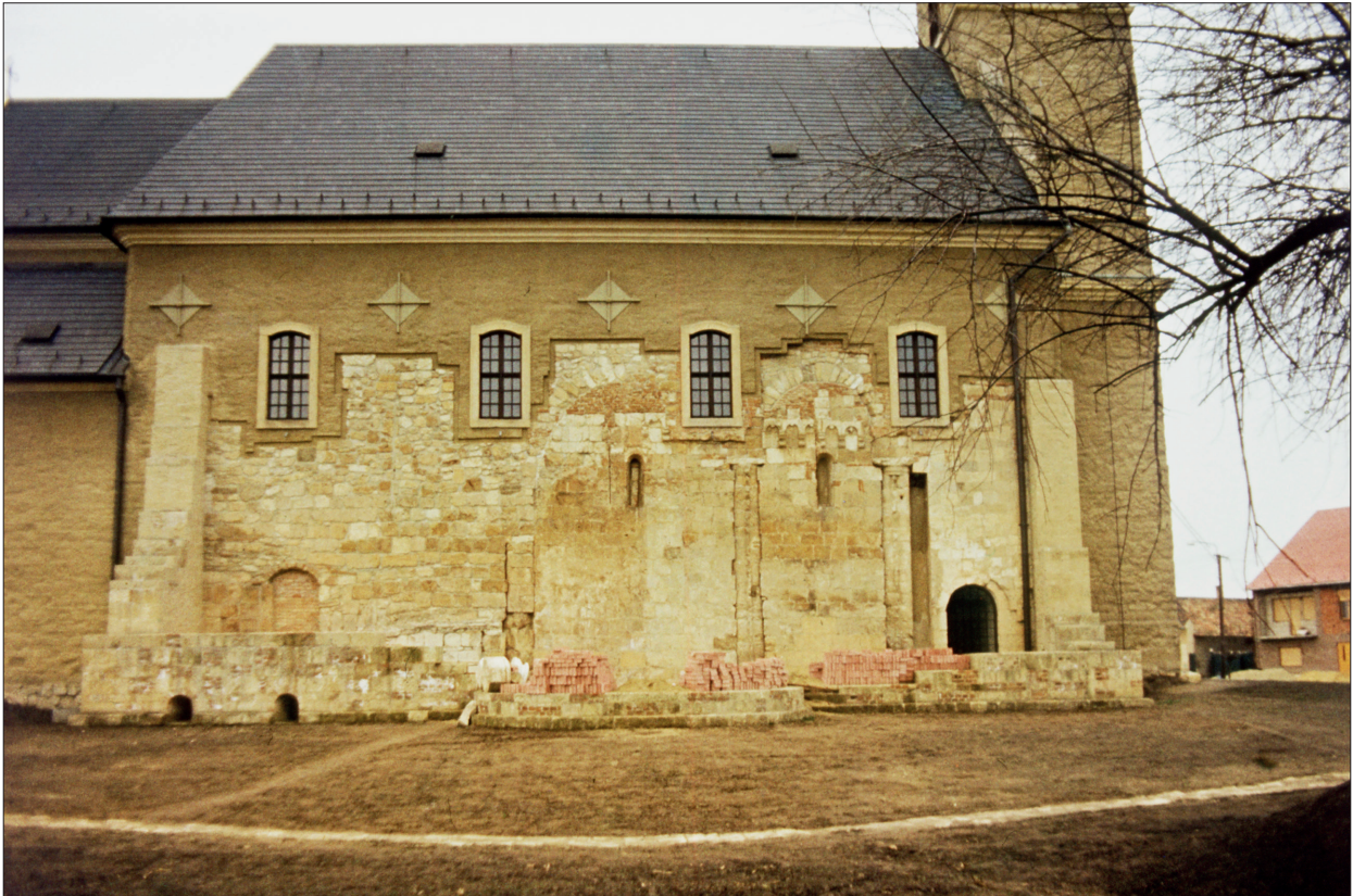
Abb. 38 Feldebrő (H): Kirche, die Nordwand der Kirche, Überreste der Arkatur der I. Bauphase. – (Foto M. Takács).
