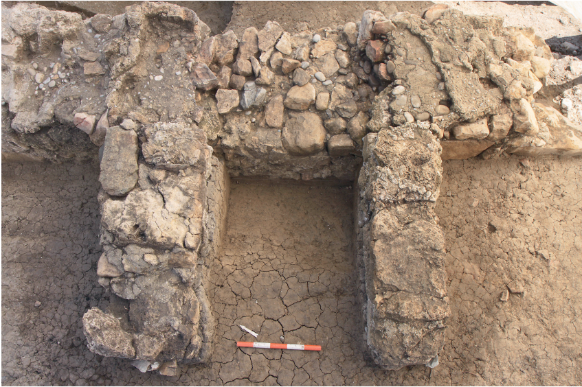
Abb. 69 Altreu SO. Die parallelen Zungenmauern M 4 und M 6 im mittleren Hausdrittel des Hauses H 2. Auf der Abbruchkante von M 5 am oberen Bildrand die beiden Steinnegative, die vielleicht von einem Türgewände stammen. Blick nach Osten.
