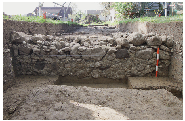
Abb. 83 Altreu SO. Ansicht der Mauer M 1, die den mittleren vom hinteren Teil des Hauses H 6 abtrennte. Blick nach Süden.
