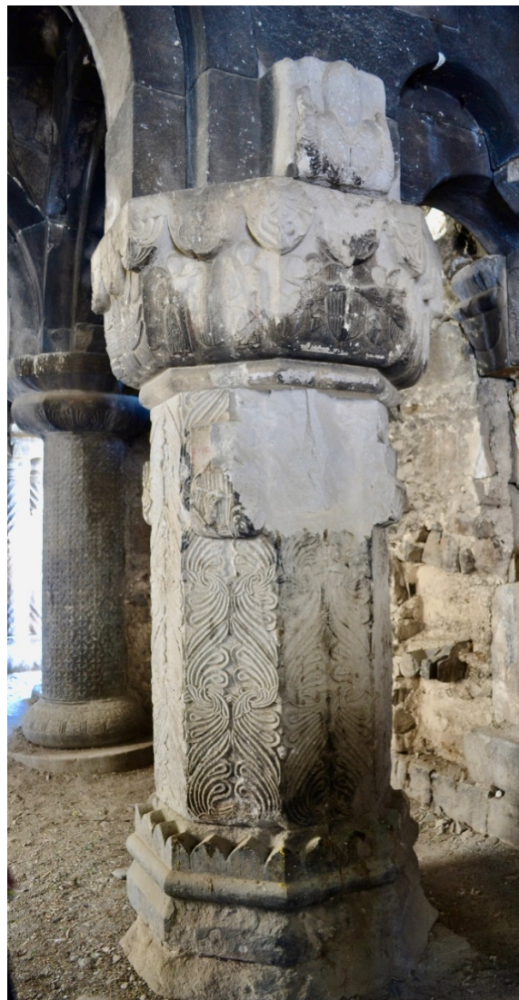
Abb. 4: Blick von Nordwesten auf den Engelspfeiler (S. Feist).
