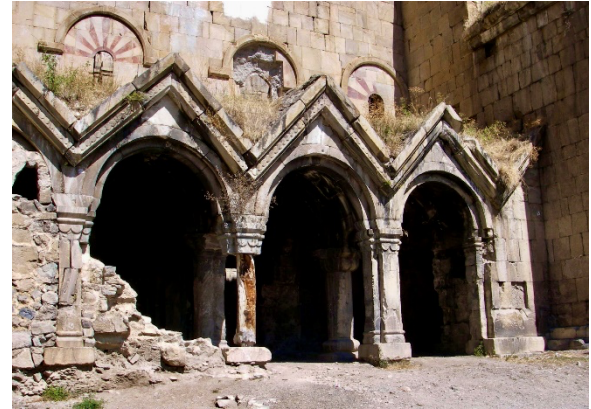
Abb. 2: Blick von Südwesten auf die südliche Vorhalle (S. Feist).
