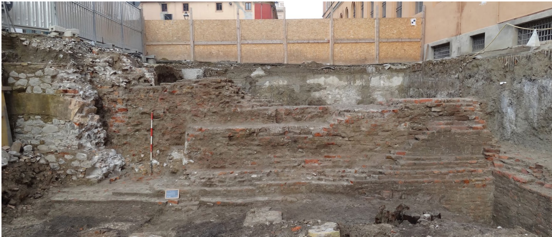
Fig. 6: Tratto delle mura tardoantiche di Parma, dallo scavo di via del Conservatorio.
