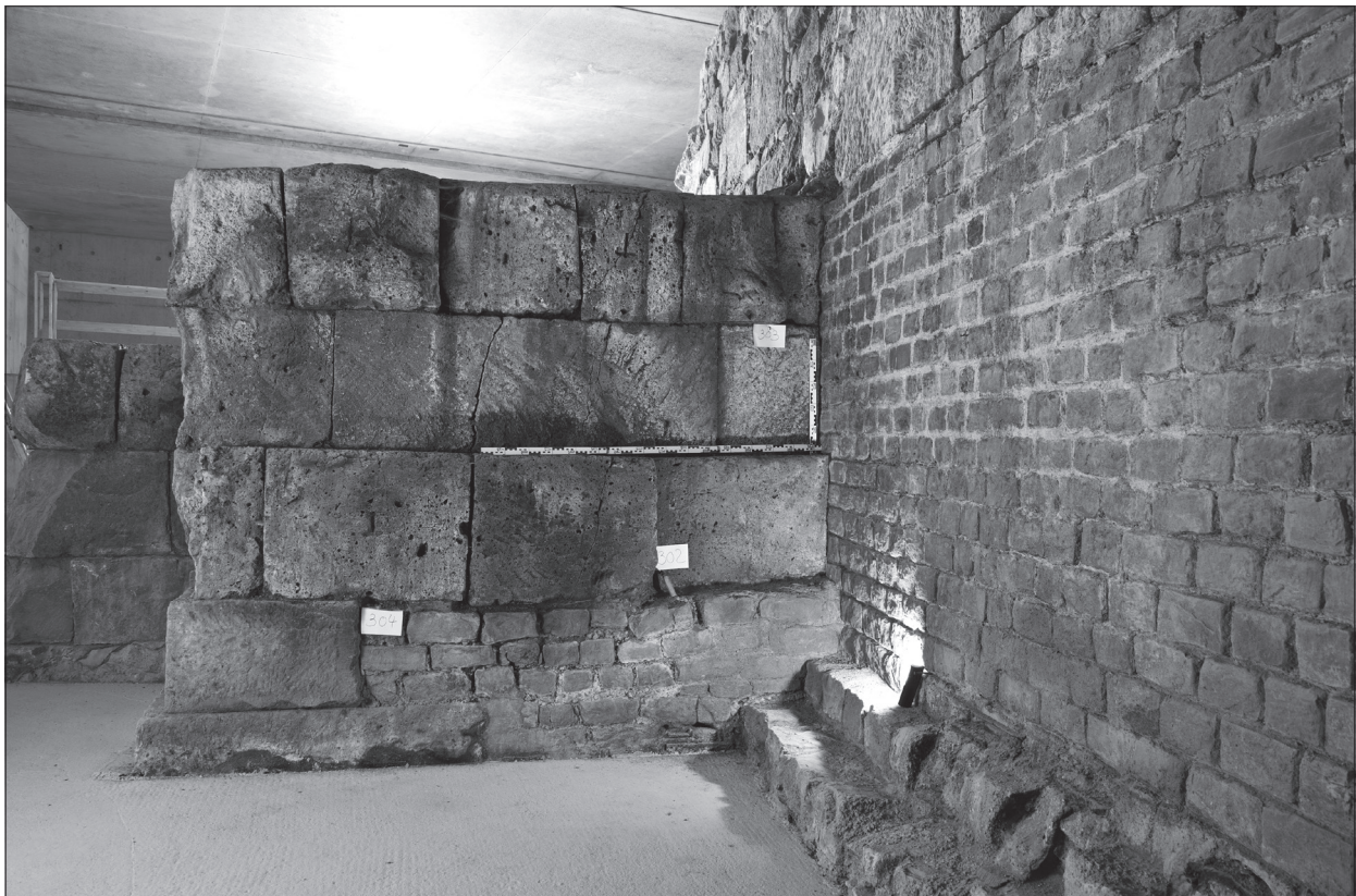
Abb. 193 Köln, Kurt-Hackenberg-Platz. Stadtmauer mit Kanalauslass am Hafentor. – (Foto: B Streubel, RGZM).
