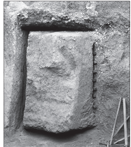
Abb. 152 FS 33, Meurin 5. Blocklösung 4: Sieben Keiltaschen sind eingeschlagen und mit Eisenkeilen bestückt. – (Foto RGZM).
