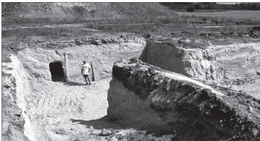
Abb. 122 FS 40, Flur »Im Steinacker«. Nordprofil der Baugrube in Parzelle 18/93 mit Stollenanschnitt. – (Foto RGZM).
