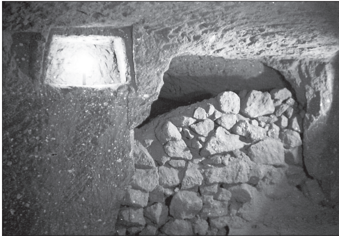
Abb. 131 FS 49, Franz-Josef-Straße. Mit Versatz zuge-setzter Durchgang zwischen zwei Abbaukammern. – (Foto im Archiv des Plaidter Geschichtsvereins).
