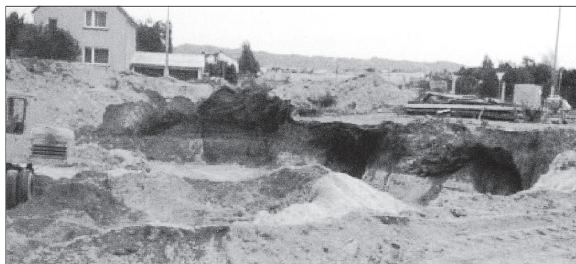
Abb. 146 FS 58, Ochtendunger Straße 32. Baugrube 1987 mit zwei »Alten Männern«. – (Nach Horch 2005, Abb. 19).
