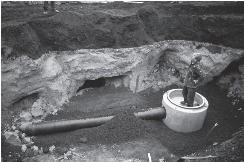
Abb. 114 FS 40, Flur »Im Steinacker«. Südprofil der Straßenbrasse; die Skizze zeigt den dahinter liegenden Stollenverlauf. – (Foto RGZM).
