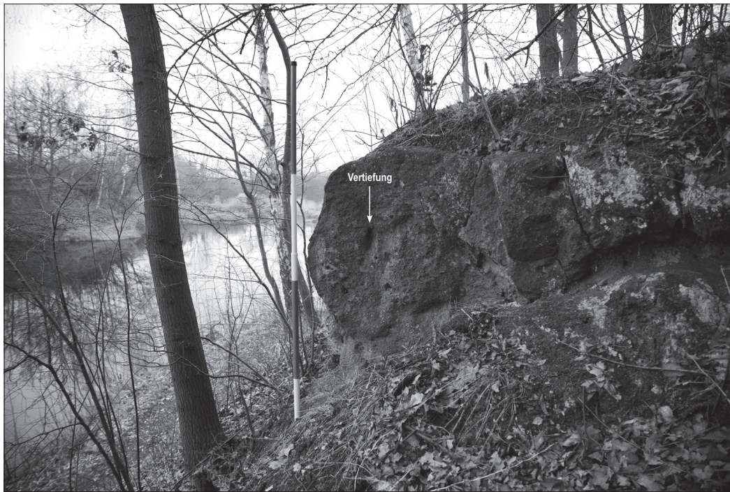
Abb. 34 FS 11, Grubenkomplex D. Zerwas/Söhne und andere. Abbauwand oder Stützpfiler eines antiken Bergwerks. – (Foto B. Streubel, RGZM).
