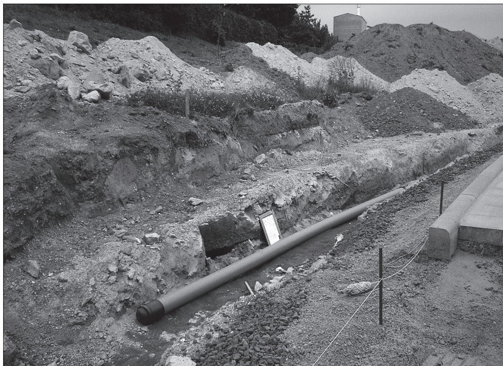
Abb. 36 FS 17, »In der Rathskaul«. Baumaßnahmen im Juni 2008. Links neben dem Zeichenrahmen (DIN A 3) ist ein Stollenanschnitt zu erkennen. – (Foto RGZM).
