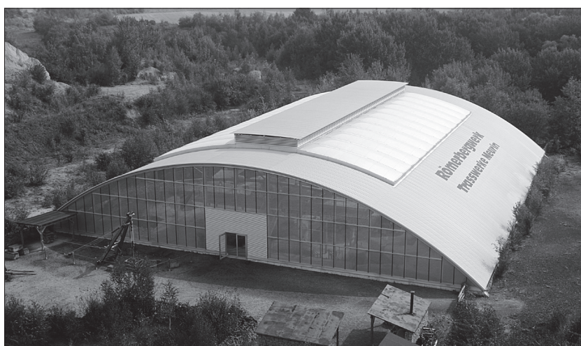
Abb. 71 FS 31, Meurin 2. Das Römerbergwerk Meurin 2011. – (Foto R. Sollfrank, Trasswerke Meurin).
