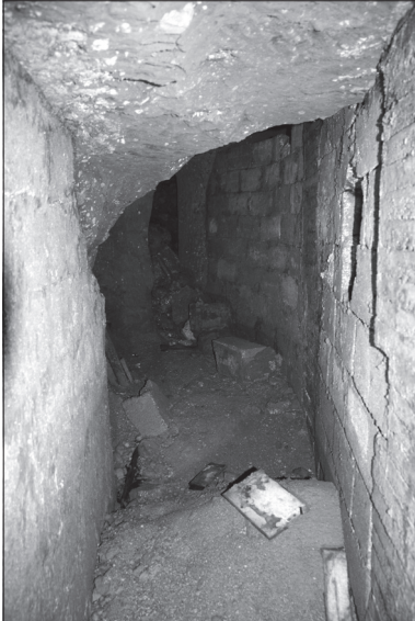
Abb. 139 FS 53, Niederstraße. Blick von Stollen C in den vorderen, östlichen Kellerraum. – (Foto W. Horch).
