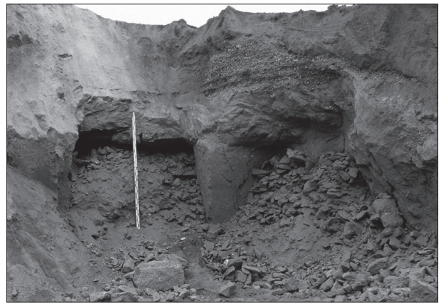
Abb. 61 FS 30, Meurin 3 im August 1999. In den angeschnittenen Abbaukammern stapelt sich der antike Versatz bis unter die Decke. Abbauspuren an den Stützpfeilern wiederum zeigen, dass auch hier große Quader aus dem Anstehenden gewonnen wurden. – (Foto RGZM).
