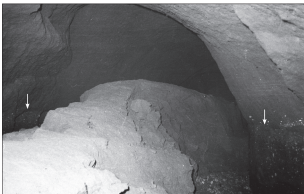
Abb. 135 FS 51, Miesenheimer Straße. Aufnahme aus Position 8 (vgl. Abb. 132 ), die Pfeile markieren die ursprüngliche Decke. – (Foto E. Spurzem).
