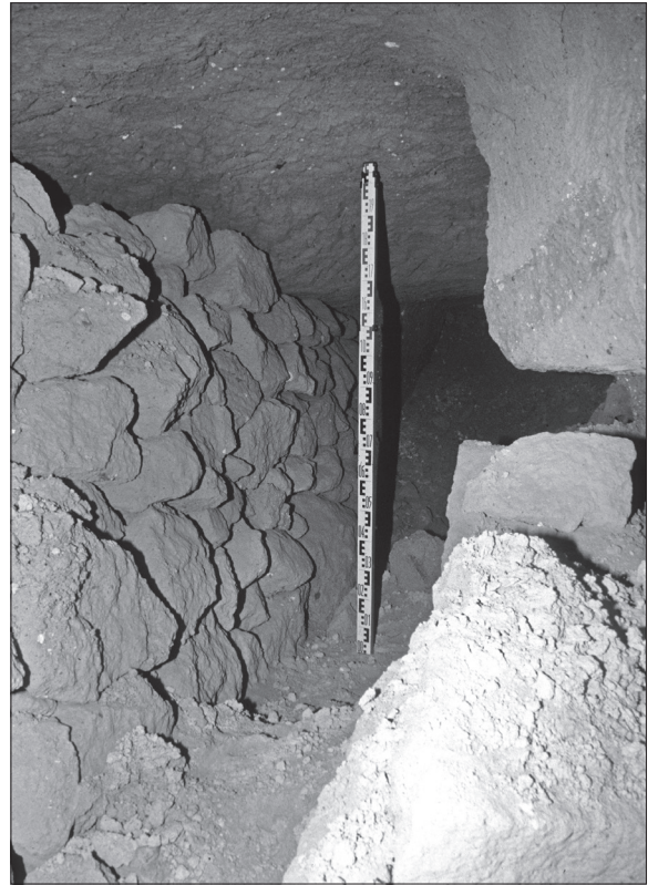
Abb. 63 FS 30, Meurin 4. Durch Trockenmauern freigehaltener Gang in Kammer 1. – (Foto RGZM).
