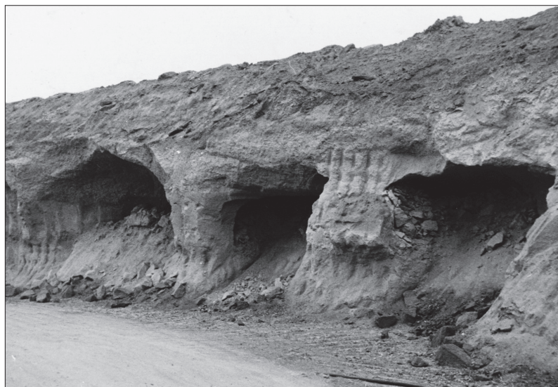
Abb. 44 FS 19, Autobahnbau um 1970. Stollenanschnitte in der Trasse. – (Foto Robert Oppert).
