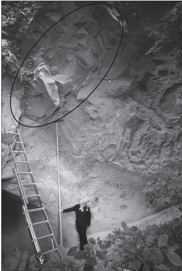
Abb. 25 Brohl-Lützing, alter Trassbruch im Brohltal westlich des Jägerheims. In einer Partie festen Tuffsteins (oberhalb der Messlatte) sind noch halbe Bohrlöcher erhalten.
