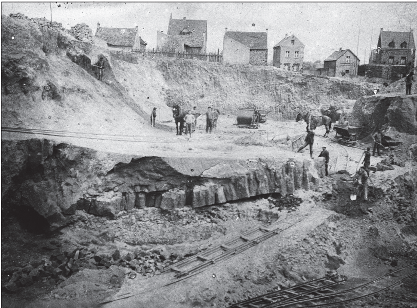
Abb. 10 FS 55, Finkenweg. Trassgrube um 1910; im unteren Tuffstein ist ein altes Bergwerk angeschnitten. – (Foto Sammlung H.-W. Müsch).
