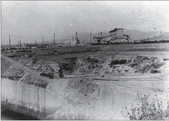
Abb. 12 FS 24, Meurin 1930er Jahre. Im Bildmittelgrund rechts sind deutlich zwei »Alte Männer« im Römertuff zu erkennen. – (Foto im Besitz von Heinz Breitbach).
