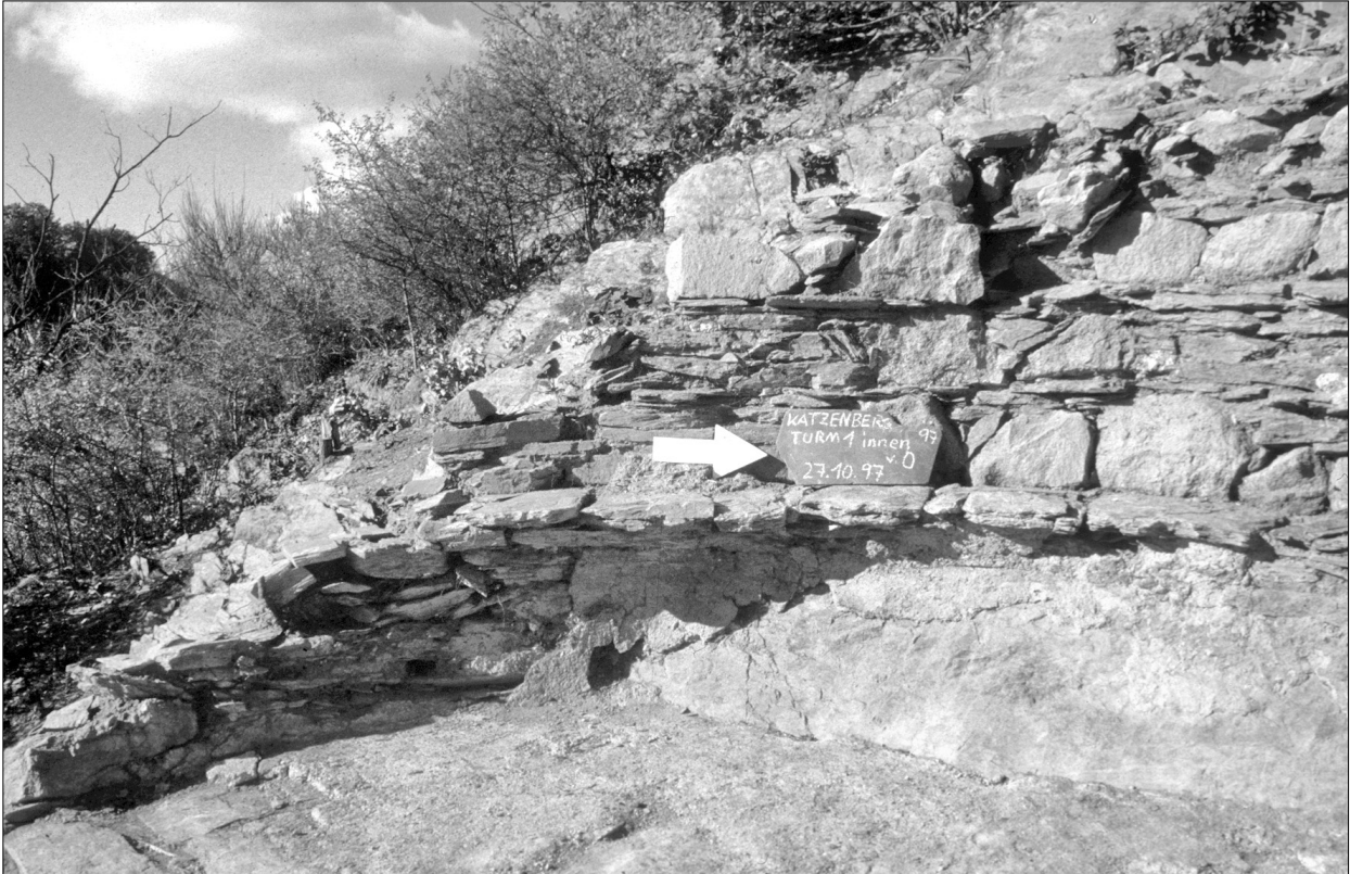
Abb. 70 Katzenberg 1997. Turm 1, Bank aus Schieferplatten.
