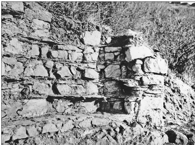
Abb. 36 Katzenberg. Südflanke, Schnitt 152, Turm 2, Inneres von Westen, um 1930 (Archiv des GAV Mayen).
