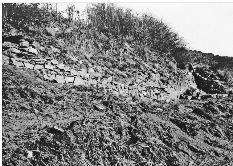
Abb. 32 Katzenberg. Südflanke, Umfassungsmauer an Schnitt 147, rechts Turm 2, um 1930 (Archiv des GAV Mayen).
