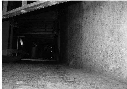
Fig. 3: Il pozzo montacarichi in corso di scavo.
