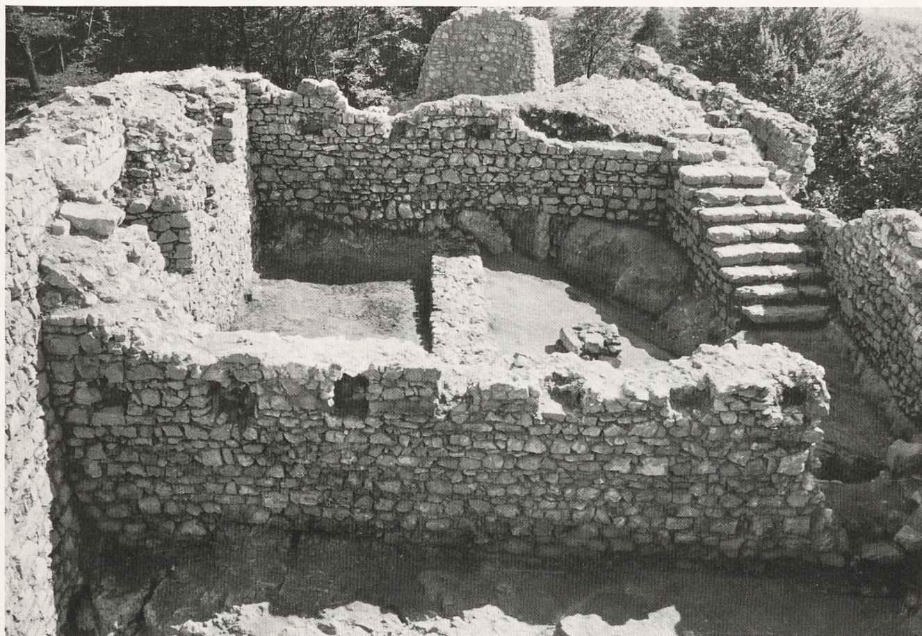
Abb. 7: Inneres des Wohnturms, Blick gegen Süden. Im Vordergrund jüngere Quermauer mit Türöffnung und Balkenlöchern. Linkerhand nachträglich aufgeführte Wandverstärkung. (Aufn. 336)
