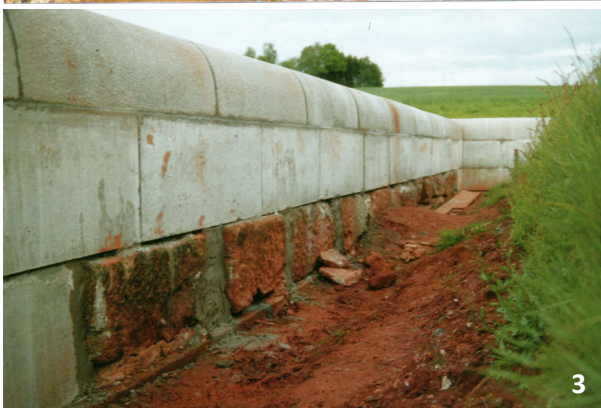
Abb. 28: Wadern-Oberlöstern, 2000. Die Originalsteinquader des Bodendenkmals wurden mit grauen Fabrikbetonblöcken überbaut (Fotos E. Jäckel).
