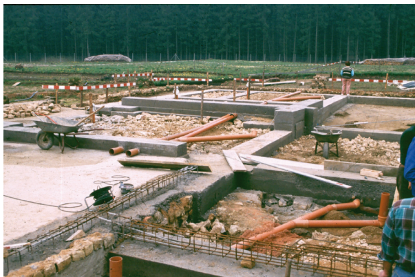
Abb. 9: Erste Bauarbeiten an den Fundamenten des Badegebäudes (Foto: Archäologiepark Römische Villa Borg).
