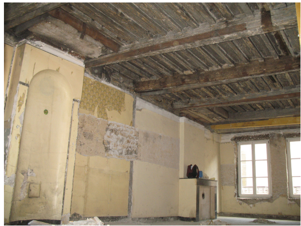
Abb. 6: Metz, Moselle (57), „Rue Taison“. Hier konnte bei bauarchäologischen Untersuchungen ein Gebäude aus der ersten Hälfte des 17. Jahrhunderts dokumentiert werden, das sich durch Balkendecken mit hölzernen Unterzügen sowie durch Kamine des 18. Jahrhunderts auszeichnete, die nachträglich an die Zwischenwände angesetzt worden waren. Ferner konnten Spuren der ehemaligen Farbfassung und Dekoration der Räume nachgewiesen werden. Die detaillierte Beobachtung und Dokumentation des aufgehenden Mauerwerks erlaubt es häufig, den ältesten Baubestand eines Gebäudes festzustellen und die Gebäudeentwicklung über die Jahrhunderte zu verfolgen (Foto: I. Ferraresso, Inrap).
