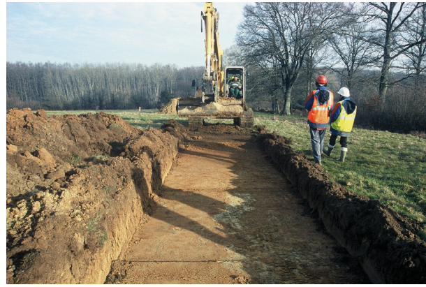
Abb. 3: Anlässlich einer archäologischen Prospektion werden Baggerschnitte angelegt, bei denen ein Bagger mit flacher, ungezählter Böschungsschaufel zum Einsatz kommt (Foto: L. Cargouët, Inrap).
