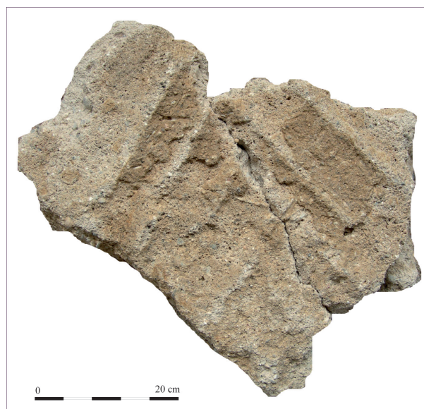
Fig. 2 : Rue Marchant. Traces en chevrons sur le revers du fragment permettant l'accrochage de l'enduit sur un mur en matériaux périssables (Cliché M. Mondy, Inrap).
