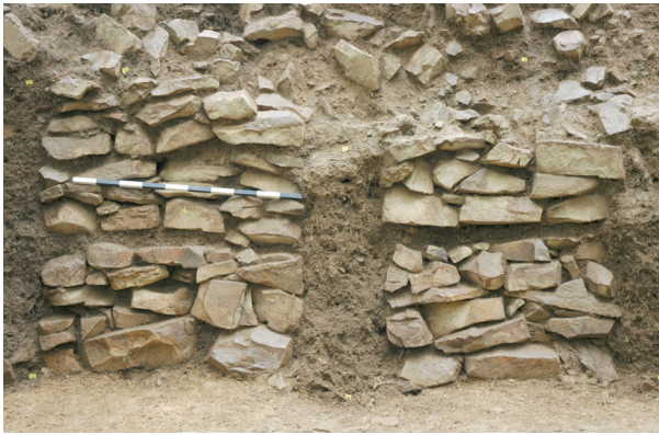
Abb. 19: Donnersberg, Zwischenwall. Detailaufnahme der beiden östlichsten Mauersegmente mit den Lücken für Kanthölzer, die hier als Längsbinder zwischen den Frontpfosten eingebaut gewesen waren (GDKE Speyer).
