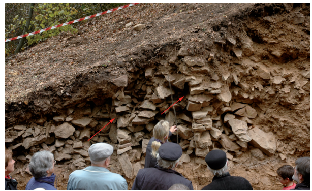
Abb. 14: Donnersberg, Mittelwall. Grabungsbefund der zwei Mauern im Profil durch den Wall (GDKE Speyer).
