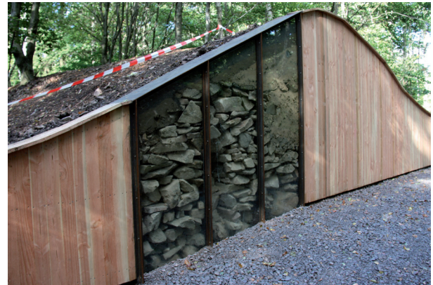
Abb. 17: Donnersberg, Mittelwall. Das verkleidete Profil direkt nach der Fertigstellung (GDKE Speyer).
