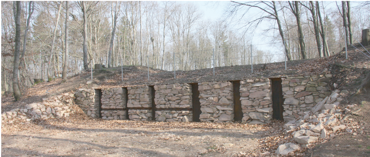
Abb. 25: Donnersberg, Zwischenwall. Die fertige Mauer im „Fenster in den Zwischenwall“ (GDKE Speyer).
