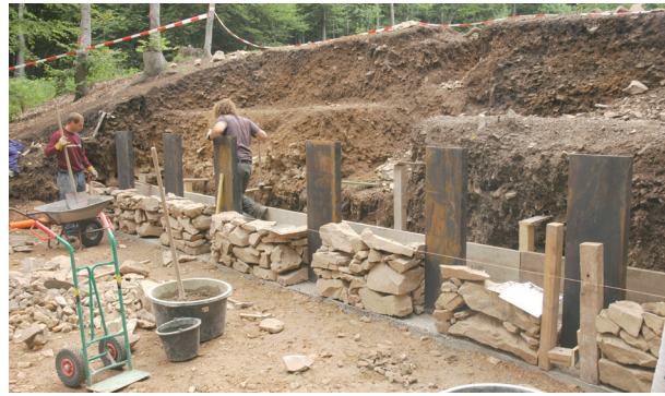
Abb. 24: Donnersberg, Zwischenwall. Arbeitsbild: Wiederaufbau der Mauersegmente (GDKE Speyer).
