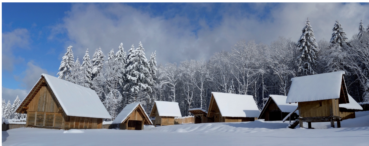
Das Keltendorf im dritten Bauabschnitt, Februar 2015. / L'hameau celte en février 2015. Troisième phase de construction (Foto: M. Koch).
