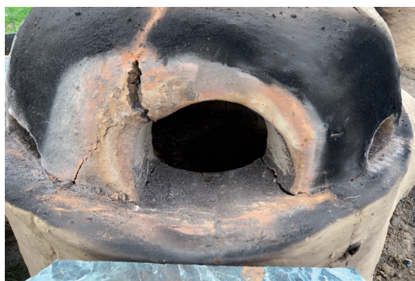
Abb. 5: Risse in der Ofenkuppel nach dem Borg Furnace Project 2013 [Foto: F. Wiesenberg].
