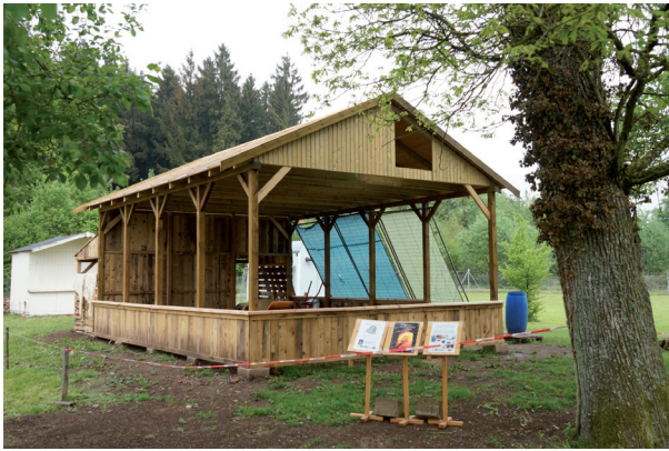
Abb. 6: Der neue Schutzbau der Glashütte im Bau [Foto: F. Wiesenberg].
