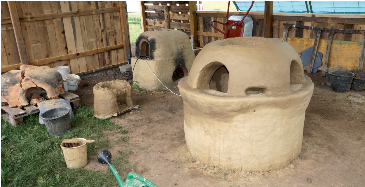
Abb. 8: Glashütte der Villa Borg. Restaurierter Glasofen und Kühllofen, dazwischen Perlenofen (im Bau), links dahinter die abgetragene Ofenkuppel des Glasofens [Foto: F. Wiesenberg].
