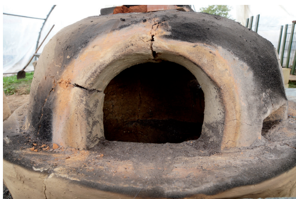
Abb. 4: Risse in der Ofenkuppel nach dem Borg Furnace Project 2013 [Foto: F. Wiesenberg].
