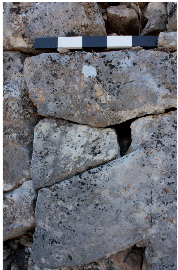
Abb. 17: AT1 Frontmauer - Detail [Foto: B. Özen-Kleine].
