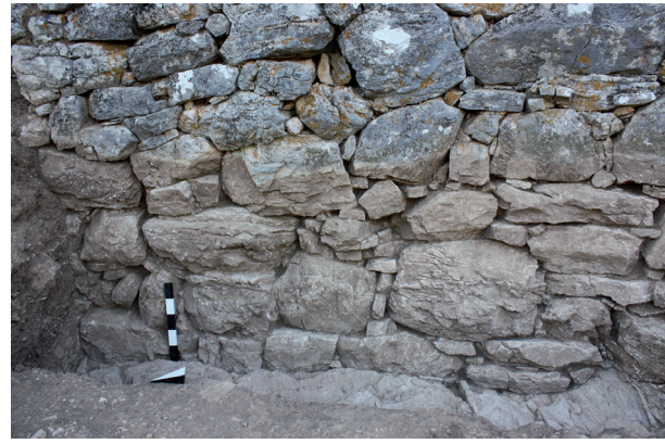
Abb. 7: Akropolismauer im Abschnitt K2. Ansicht der Fundamentlage [Foto: S. Özen].
