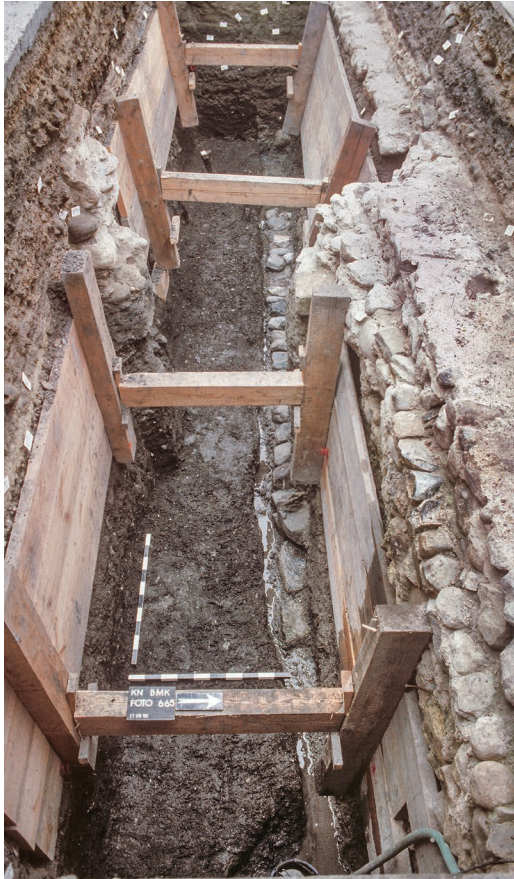
106 Marktstätte, Schn. 6. Unterhalb der Aussteifung großflächig erfasste Auffüllschicht II afs 657; rechts geschnitten von Baugrube VI bg 667; darin liegt die unterste Wackensteinlage des Fundamentes VI fb 669; von Osten (Dia 665).
