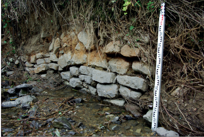
Abb. 63 Mendig, »Im Winkel«. Trockenmauerwerk am Segbach (6.9.2015). – (Foto S. Wenzel).
