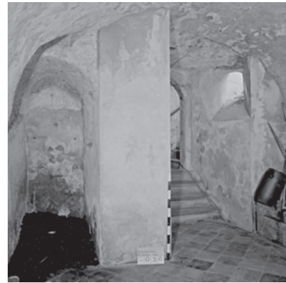
Abb. 65 Links: Nische (vormaliger Abgang) mit spitzbogigem fensterartigem kleinen seitlichem Durchbruch zum neuen Zugang (wohl ehemaliger leicht schräger Lichtschacht), rechts: Abknickender Kryptazugang (heute) mit ehemaligem Lichtschacht (von Norden)
