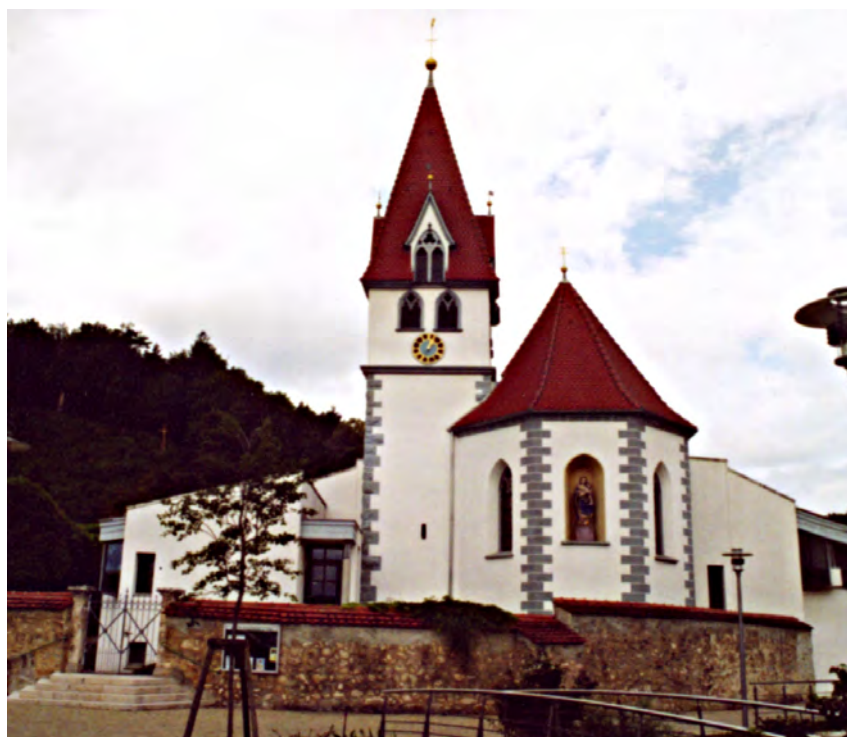
Abb. 89 Ansicht der Kirche von Osten mit den neuen Anbauten im Jahr 2011
