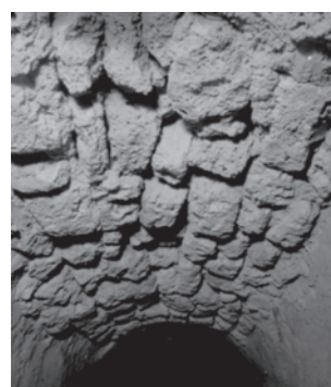
Abb. 49 Deckengewölbe des Zugangsstollens, innen (von Osten)
