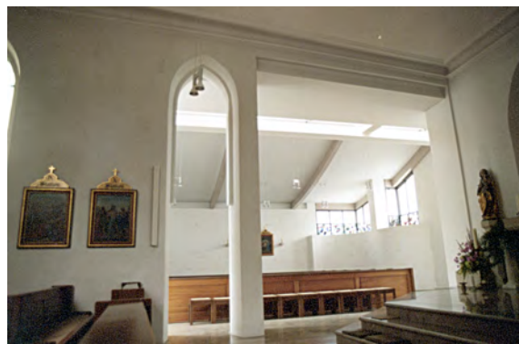
Abb. 82 Die modernen Anbauten (Nordflügel) mit erweitertem Gemeindebereich, Aufbruch der Seitenwand des Kirchenschiffs, Blick vom Kirchenschiff nach Norden im Jahr 2011
