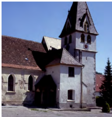
Abb. 67 Zweistöckige Sakristei vor dem Abbruch mit westlichem, hölzernem Eingangsvorbau für die Sakristei und Krypta und östlichem Anbau
