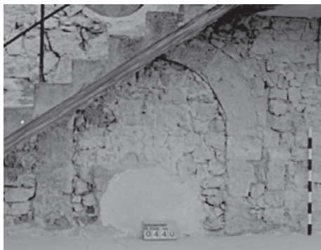
Abb. 46 Südwand außen mit Resten der zweiphasigen, ehemaligen Türgewände unter der Außentreppe zur Empore
