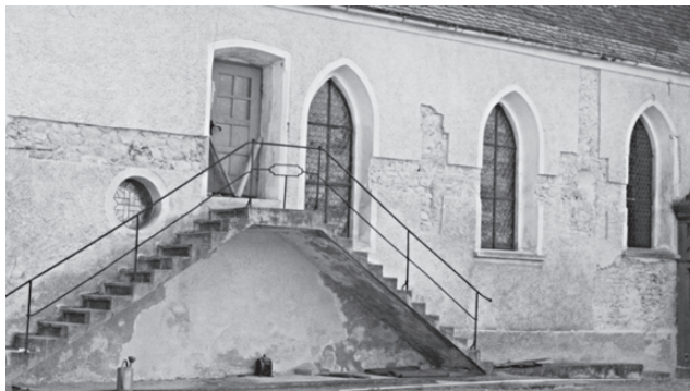
Abb. 73 Langhaussüdwand mit äußeren Emporeneingang vor dem modernen Umbau und Verlegung des Zugangs ins Innere (im südwestlichen Kirchenschiff) und Abriß der Außentreppe, Zumauerung der Tür
