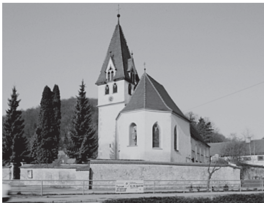
Abb. 2 St. Vitus in Schmiechen vor der Erweiterung, von Nordosten
