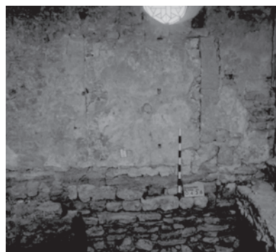
Abb. 47 Südwand innen mit den Resten der ehemaligen, später zugemauerten Tür und ihrer Gewände
