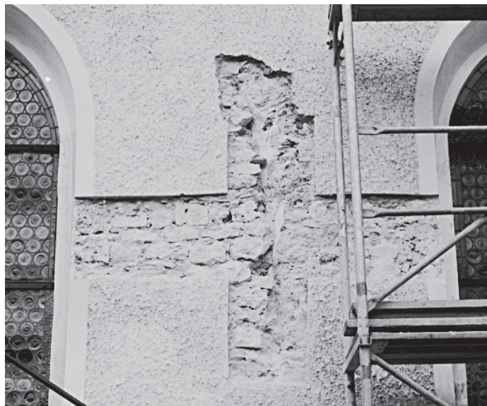
Abb. 45 Südwand mit freigelegten Resten eines der ehemaligen Fenster
