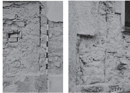
Abb. 18 Baufugen in der Süd- (links) und Nordfassade (rechts), mit der östlichen Erweiterung des Kirchenschiffs in der Periode IV
