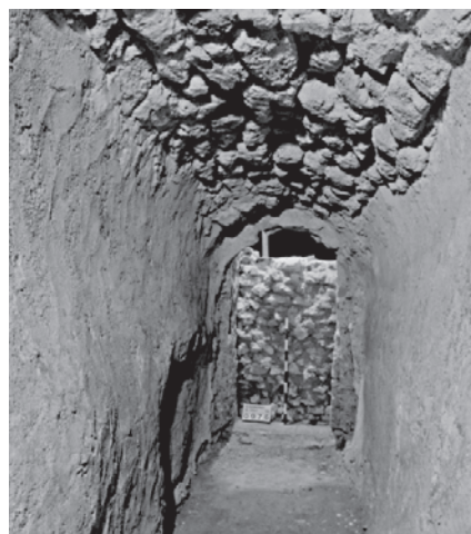
Abb. 44 Zugangsstollen, von Westen, Richtung Aufgang
