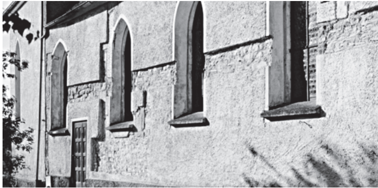
Abb. 13 Untersuchungen der nördlichen Kirchaußenfassade von 1985
