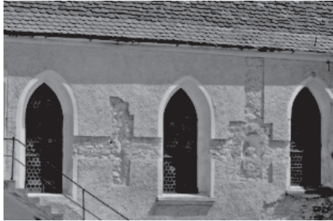
Abb. 17 Reste von zwei der ehemaligen romanischen Fenster in der Südfassade
