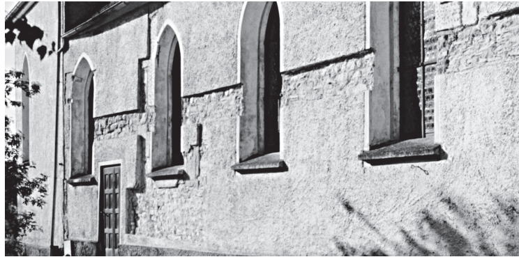
Abb. 13 Untersuchungen der nördlichen Kirchengaußenfassade von 1985
