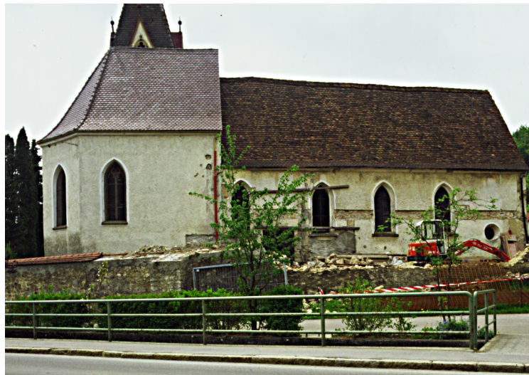
Abb. 14 Nordseite des Kirchengebäudes zu Beginn des Umbaus mit Teilabbruch der Friedhofsmauer und Teilfreilegung der Mauerstrukturen der Nordwand des Kirchenschiffs
