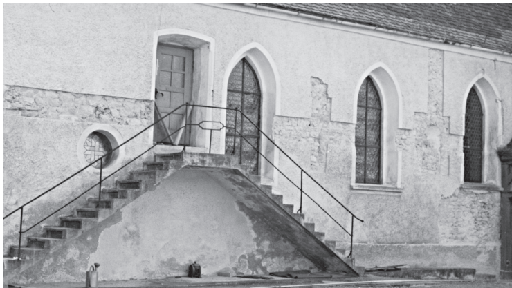
Abb. 16 Untersuchungen der südlichen Kirchenaußenfassade von 1985
