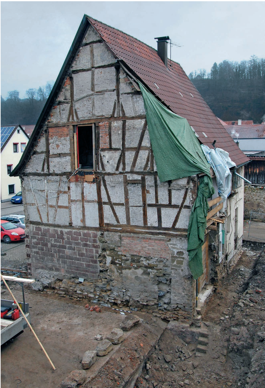
Mühlacker-Dürrmenz, Hofstraße 17. Das älteste Gebäude des Ortes (Wiederaufbau 1504/05 über älteren Kellern) nach Abriss der Neben- gebäude.
